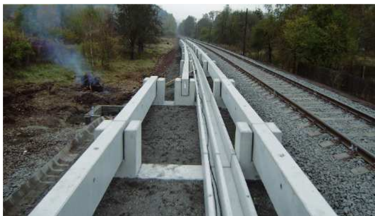
Obrázek 15 Konstrukční systém UMSTEIGER – PLUS 2000
