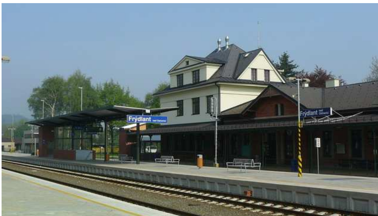
Obrázek 19 Železniční stanice Frýdlant nad Ostravicí
