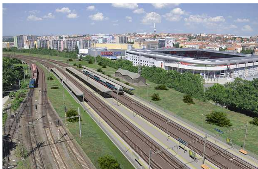
Obr. 9: Nová železniční zastávka Praha-Eden
