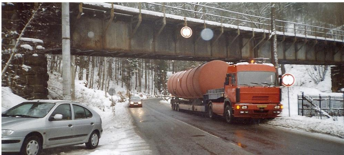
Obrázek 19 Průjezd pod mostem v protisměru u města Loket
