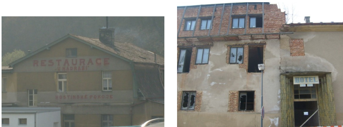
Obrázek 10: Zchátralé budovy ubytovacích zařízení v obci Srbsko
