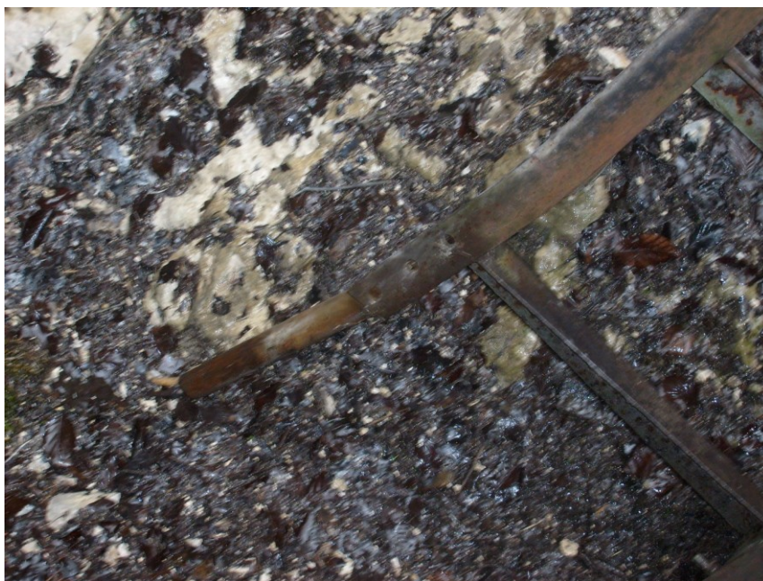
Obrázek 12: Neupevněný kovový žebřík NP Slovenský ráj
