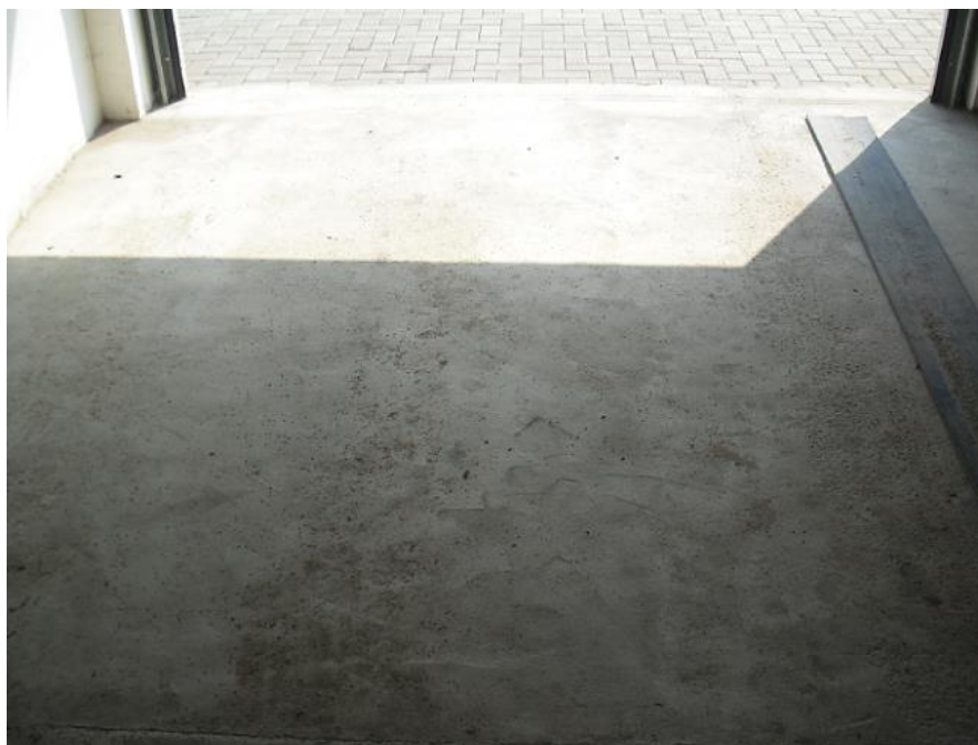
Obrázek 41 – Garáž (beton lehký)
