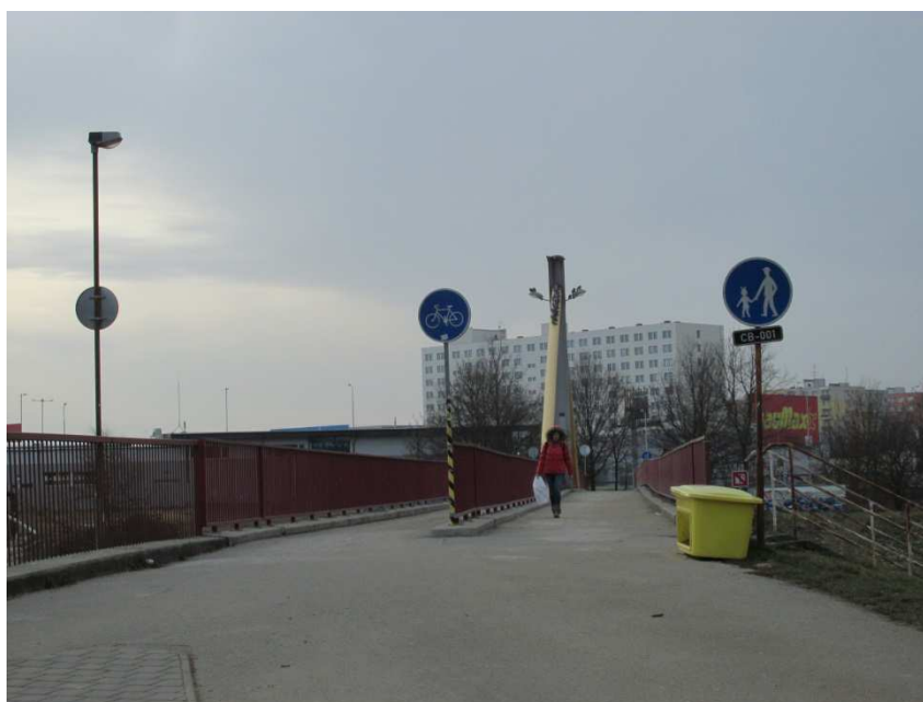
Obrázek 2.14: Lávka u Pražského sídliště (zdroj: autor)
