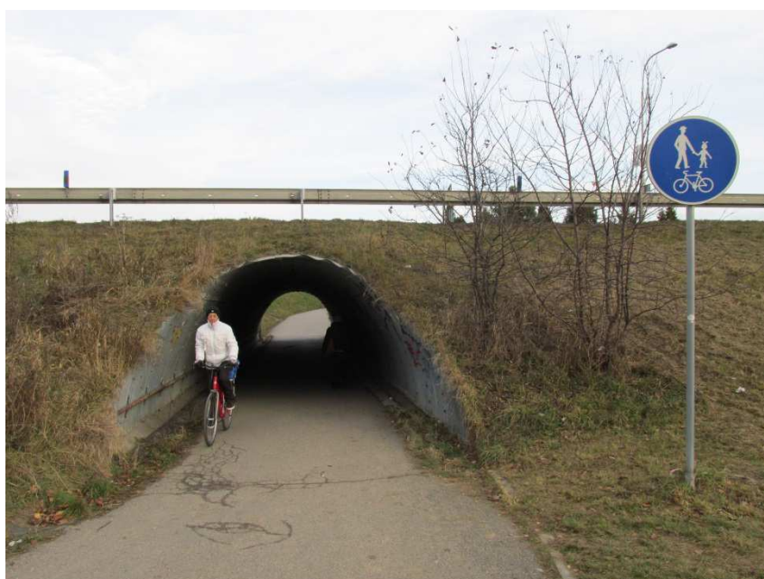
Obrázek 2.12: Podjezd pod silnicí I/3 (Na Dlouhé louce) (zdroj: autor)
