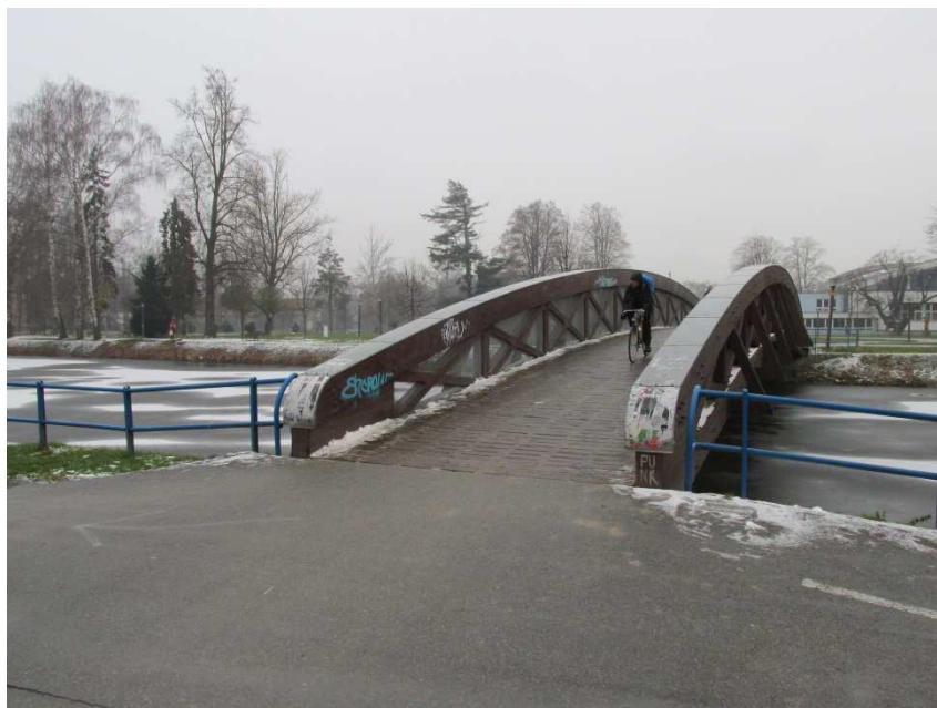
Obrázek 2.3: Lávka přes slepé rameno Malše u Radniční ulice (zdroj: autor)
