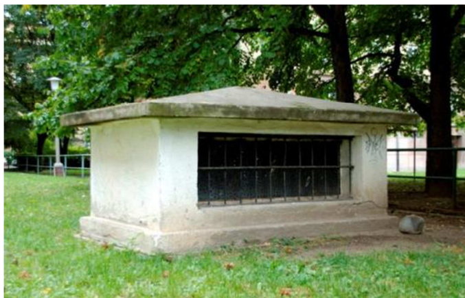
Obr. 1 Povrchový výstup z podzemního úkrytu vybudovaného v 50. letech 20. století v rámci obytného komplexu v Brně – Králově Poli
