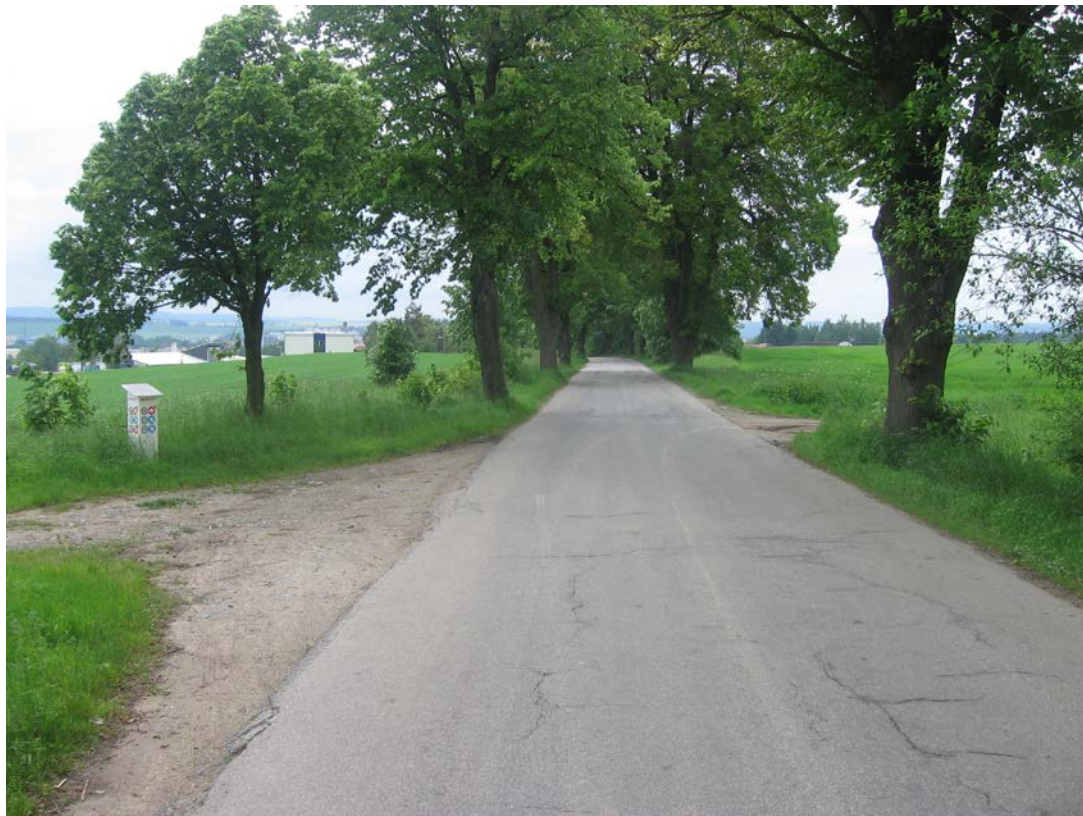
Obr.7 – pohled na budoucí křížení JV obchvatu a ulice Kosovská
