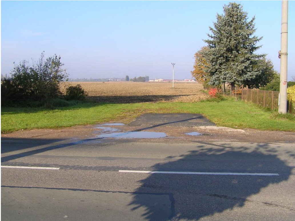
Budoucí parkovací stání. km 0,344 821
