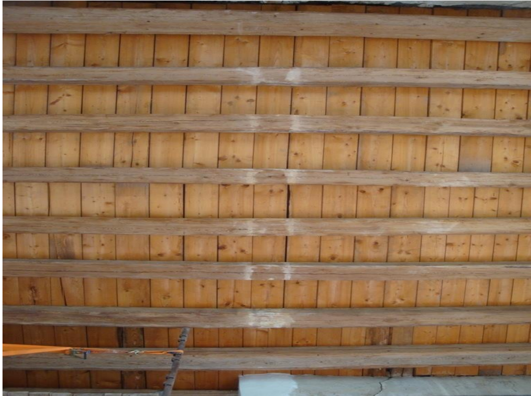
Obr. 3: Na trémovém stropě, v místě uprostřed, jsou viditelné stopy po zbourané severní příčce.
