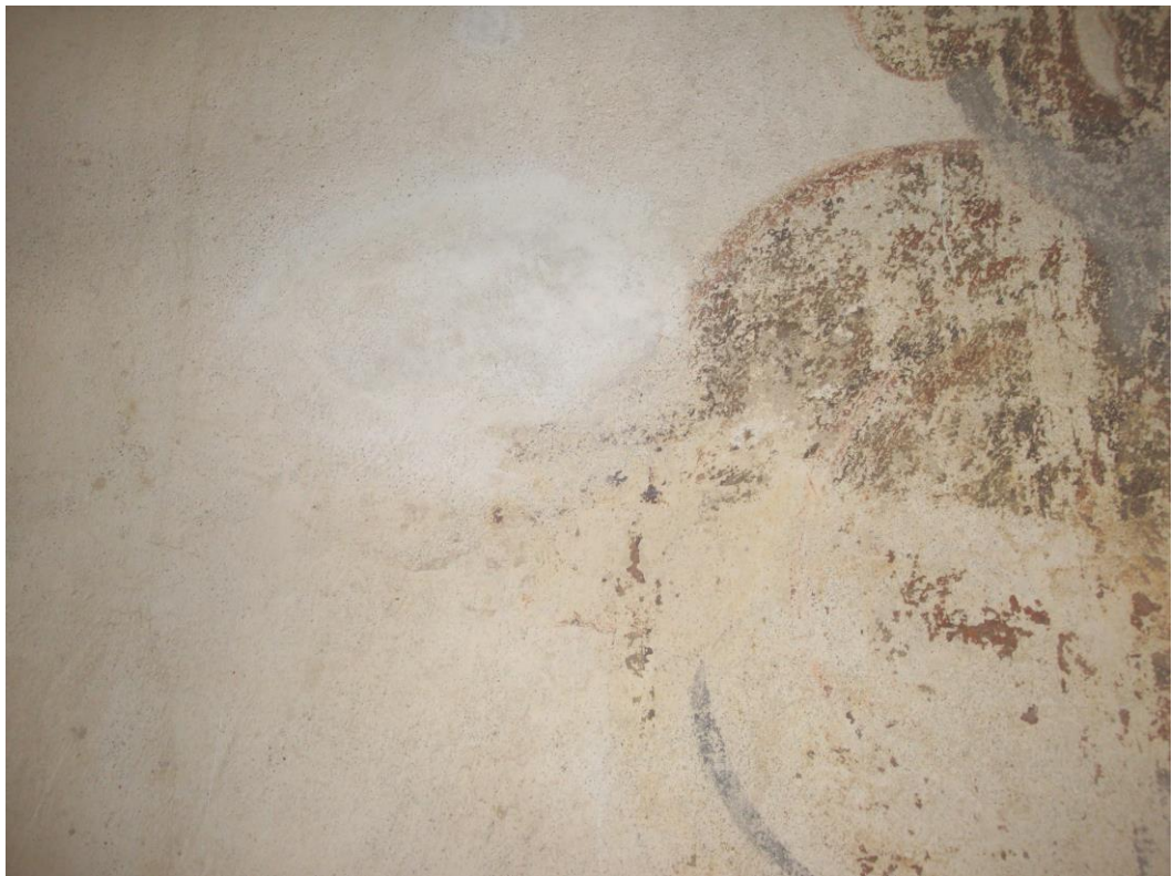
Obr. 68, 69: Stav po tmelení a pačokování.
