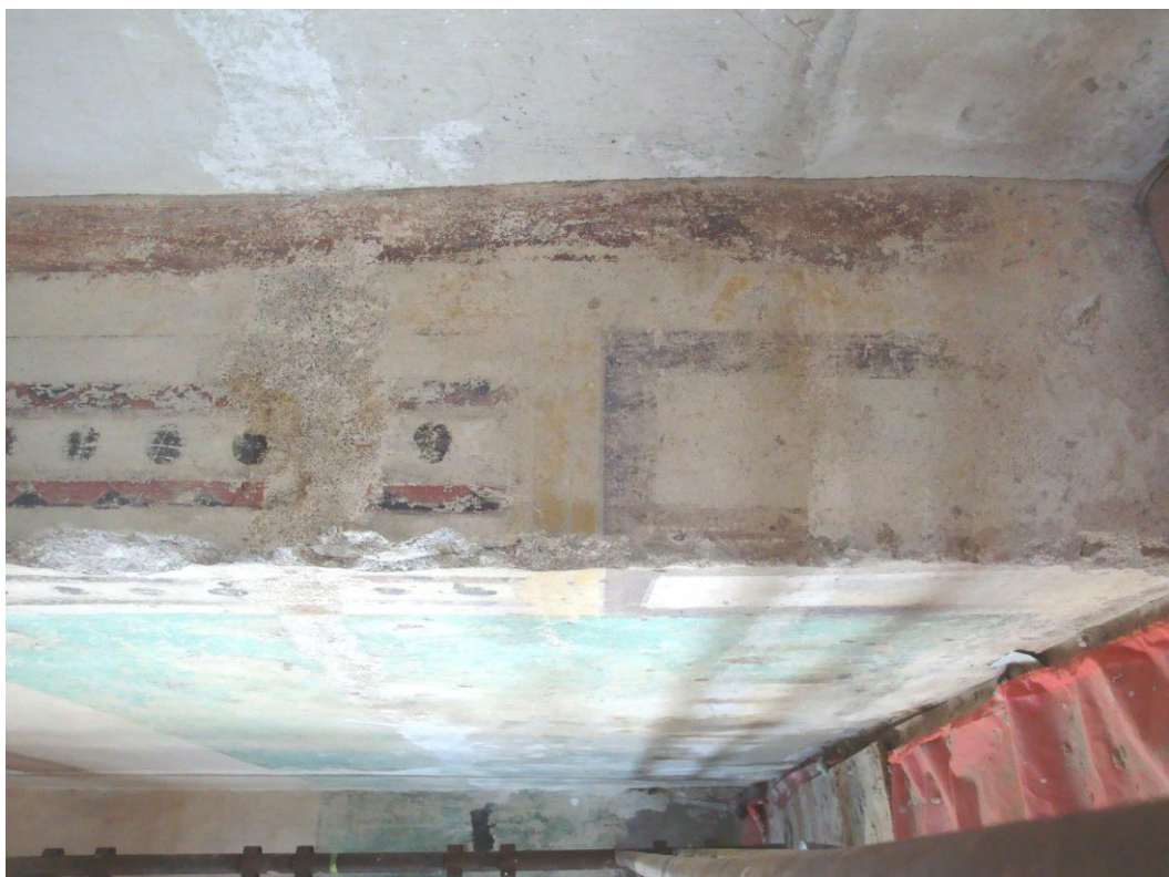
Obr. 74, 75: Jižní špaleta zazděného dveřního otvoru – stav před a po tmelení a pačokování.
