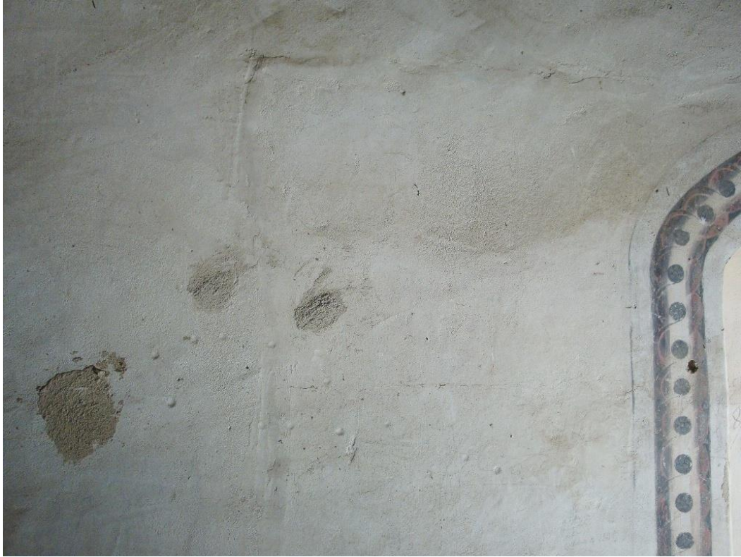
Obr. 5: Obrys zazděného středového dveřního otvoru – nasvícení v bočním světle.
