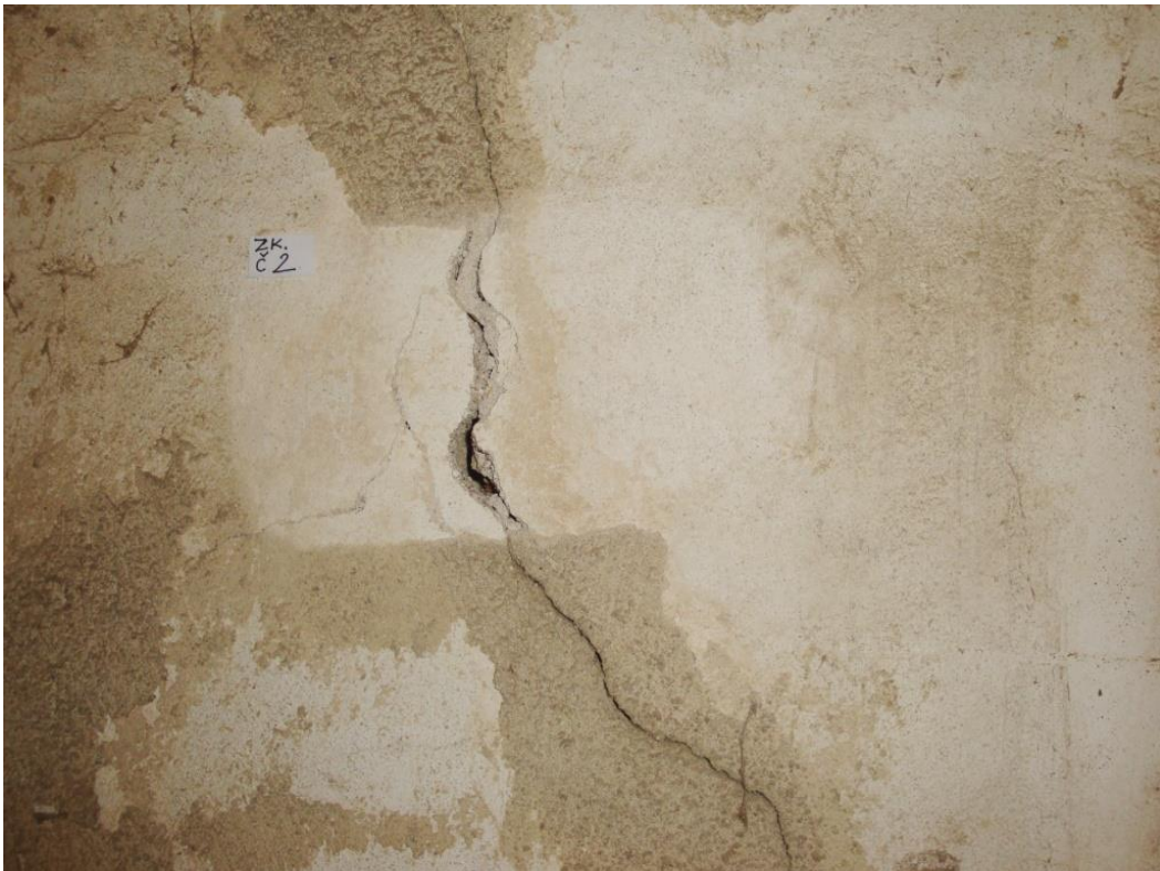
Obr. 11: Zkouška čištění č. 2 v místě nalevo od erbu po mechanickém odstranění cementových vysprávek a prachových depozitů.
