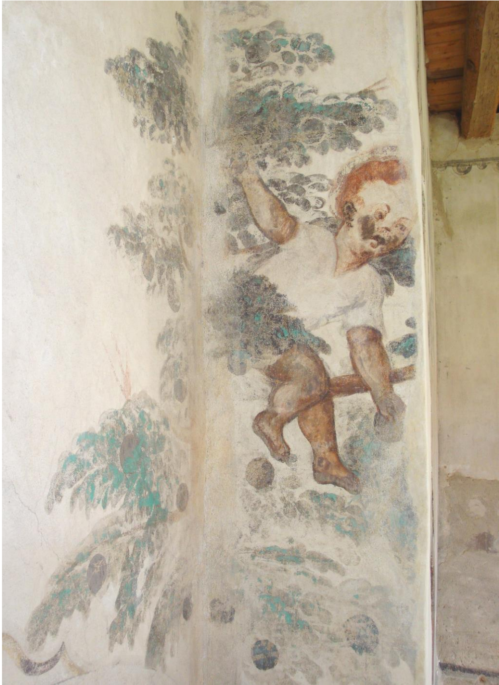
Obr. 88: Detail výjevu s chlapeckou postavou – stav po restaurování.
