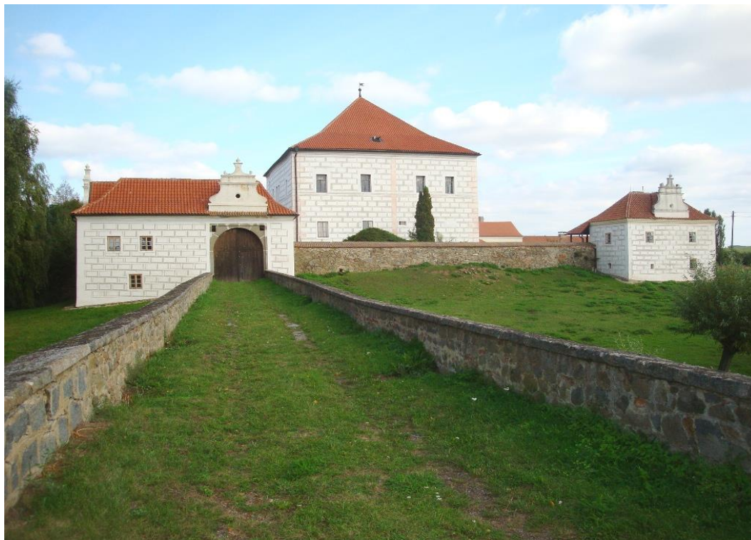
Obr. 1: Současný pohled na tvrz Jakuba Krčina z Jelčan a Sedlčan v Křepenicích z příjezdové cesty.
