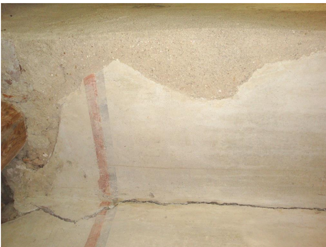
Obr. 54, 55: Severozápadní kout původní místnosti – horní části stěny, stav po čištění.
