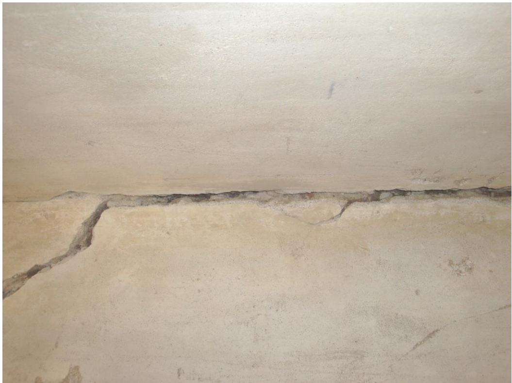
Obr. 56, 57: Jihozápadní kout místnosti – horní části stěny, stav po čištění.
