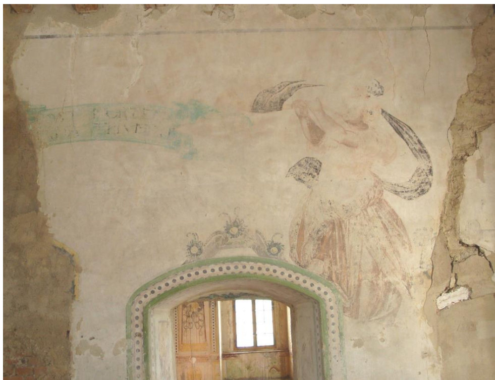
Obr. 10: Západní část jižní stěny vstupního sálu v 1. patře tvrze v Křepenicích. Postava personifikace Famy v řaseném rouchu drží podobný hudební nástroj jako na ohradní zdi zámku Kratochvíle.
