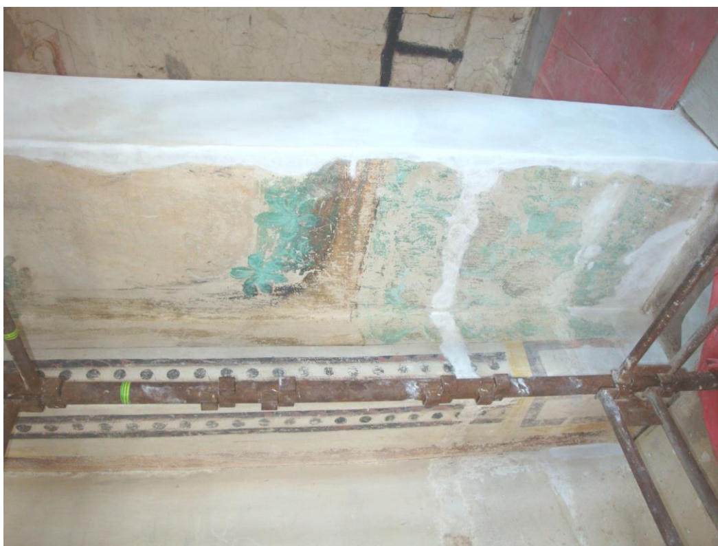
Obr. 64, 65: Přeštukovaná část severní příčky, stav v průběhu úpravy povrchu vápenným pačokem.
