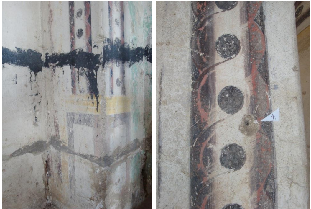
Obr. 8: Pravá část dveřní špalety v místě odběru vzorku č. 3 z nároží žlutého rámování soklu. Obr. 9: Odběr vzorku č. 4 z pásového pletence nalevo vedle dveřního zazděného otvoru.
