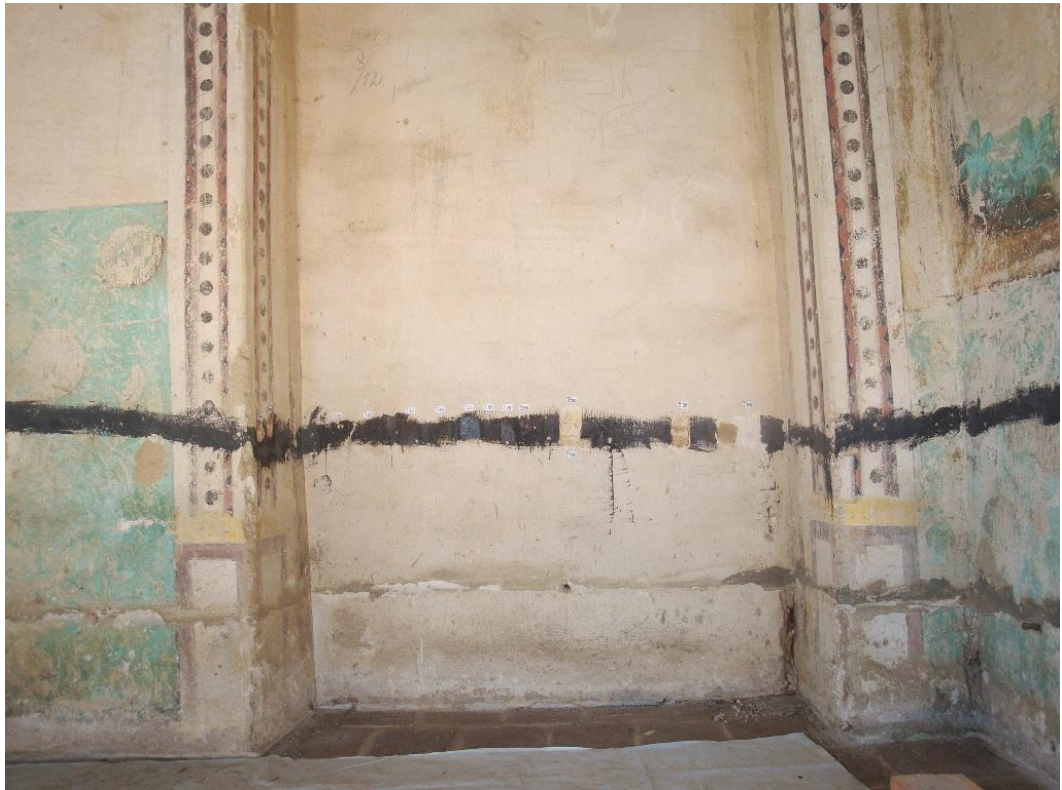
Obr. 38: Dveřní zazděný otvor před odstraněním černého pruhu.
