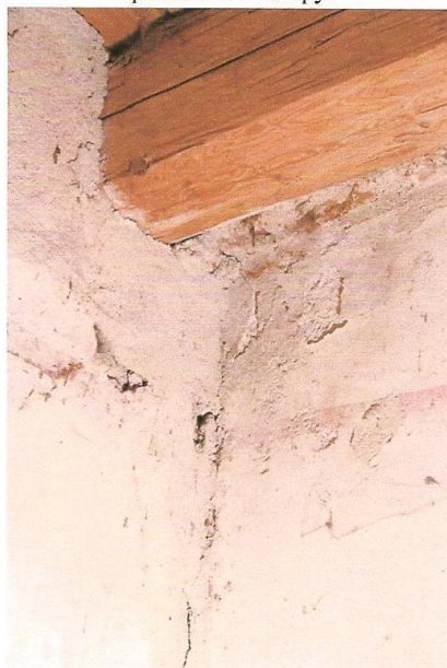
Obr. č. 29: Fotografie levého horního rohu jižní části západní stěny.
