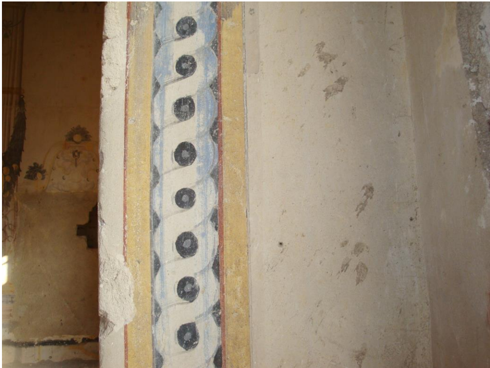
Obr. 5: Pohled na pletenec v okenní špaletě na jižní stěně Velkého sálu v tvrzi v Křepenicích. Objevují se zde pásové dekory pletenců, které jsou obdobně řešené, jako na zámku Kratochvíle. (Viz také obr. č. 30, 32 – Obrazová příloha 2)
