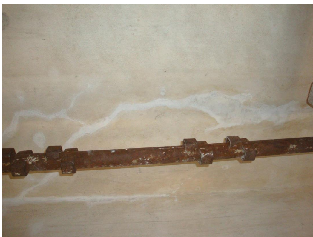
Obr. 70, 71: Jihozápadní kout místnosti – stav po tmelení a pačokování.
