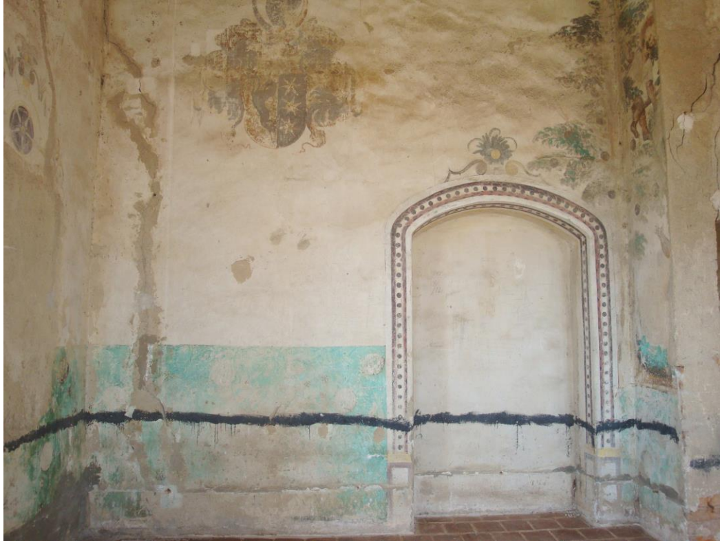
Obr. 20: Spodní část malby před odstraněním vápenných, cementových nánosů a černého pruhu na bázi bitumenu ze soklové části.
