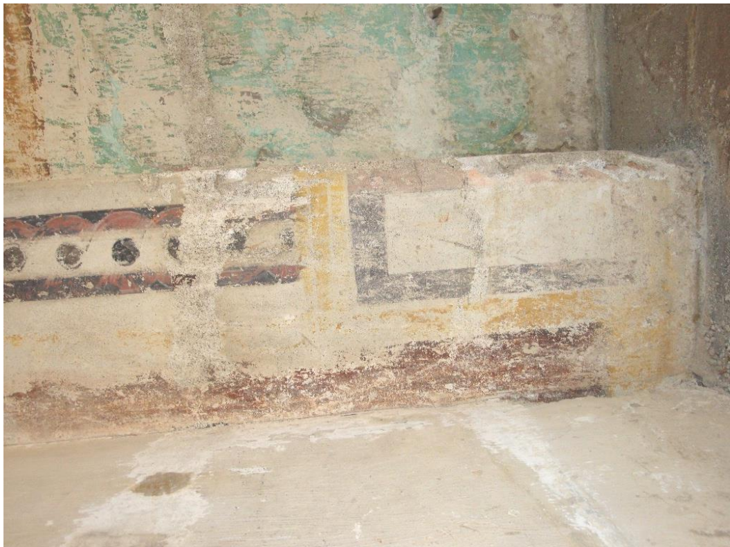
Obr. 60, 61: Jižní a severní část dveřní špalety, stav po čištění.
