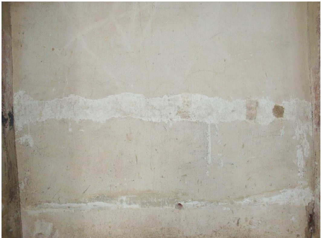
Obr. 39: Po odstranění černého pruhu, vápenných a cementových vysprávek.
