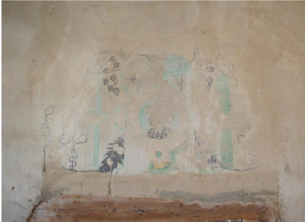
Obr. 13: Východní část jižní stěny s portálovou výzdobou nad levým dveřním otvorem. Zavíjený dekor doplňuje ve středové části fragmentárně dochovaný portrét vousatého muže v klobouku, který je otočen k východní straně.
