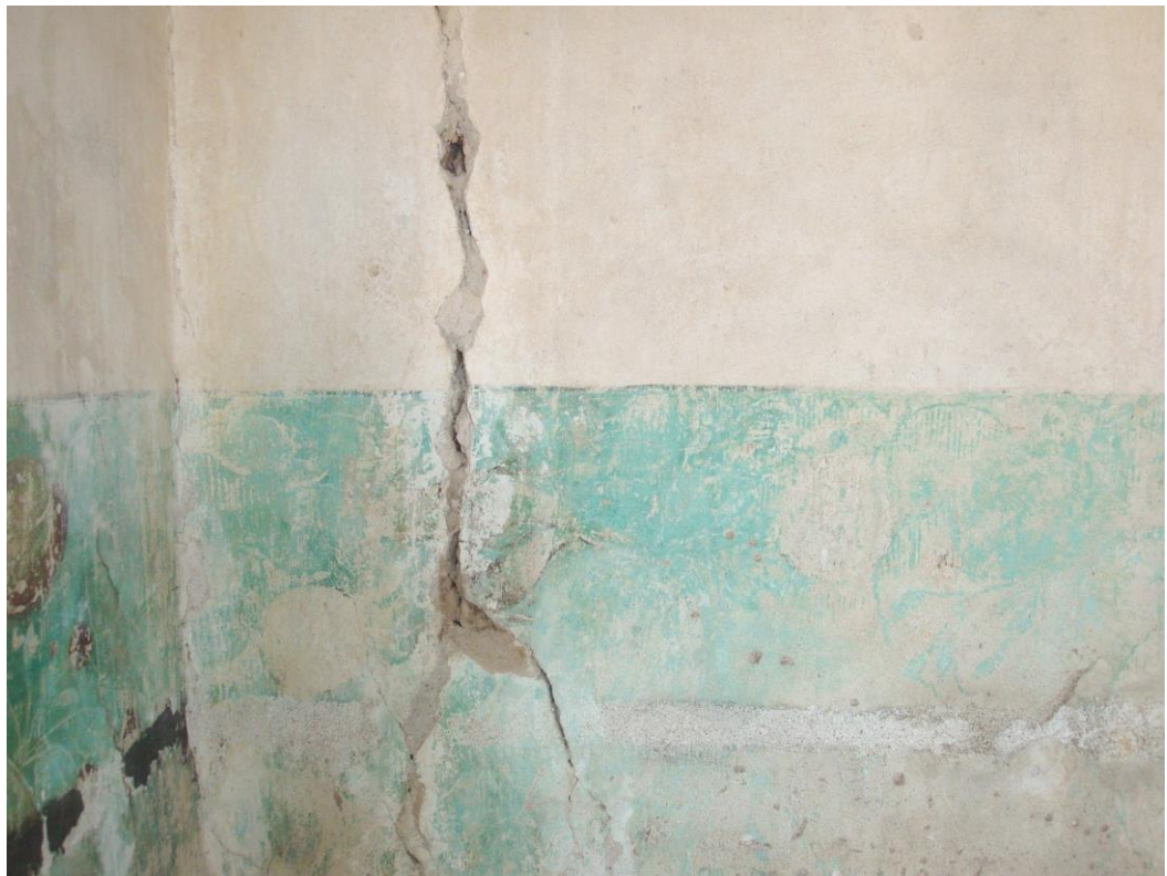
Obr. 45: Spodní část jihozápadního koutu místnosti – stav po čištění.
