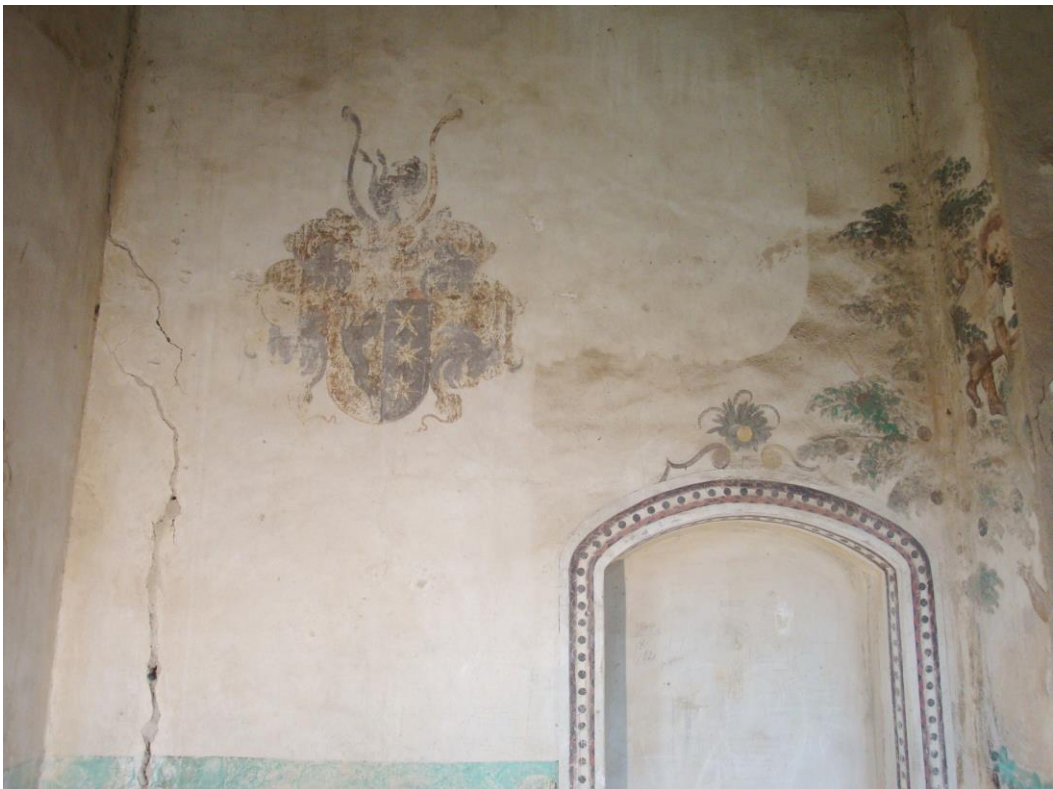
Obr. 17: Stav v průběhu čištění od prachových nánosů a vápenných vysrávek.
