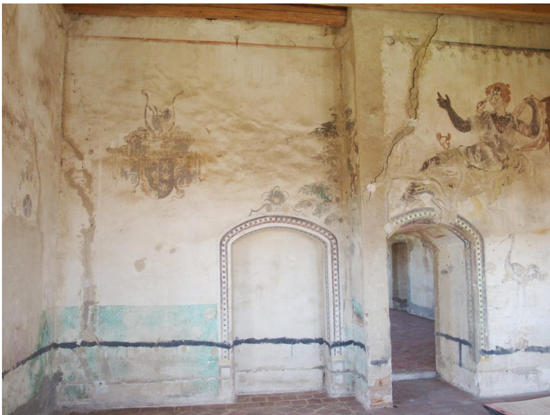
Obr. 1: Celkový pohled na jižní část západní stěny – úsek určený k restaurování.
