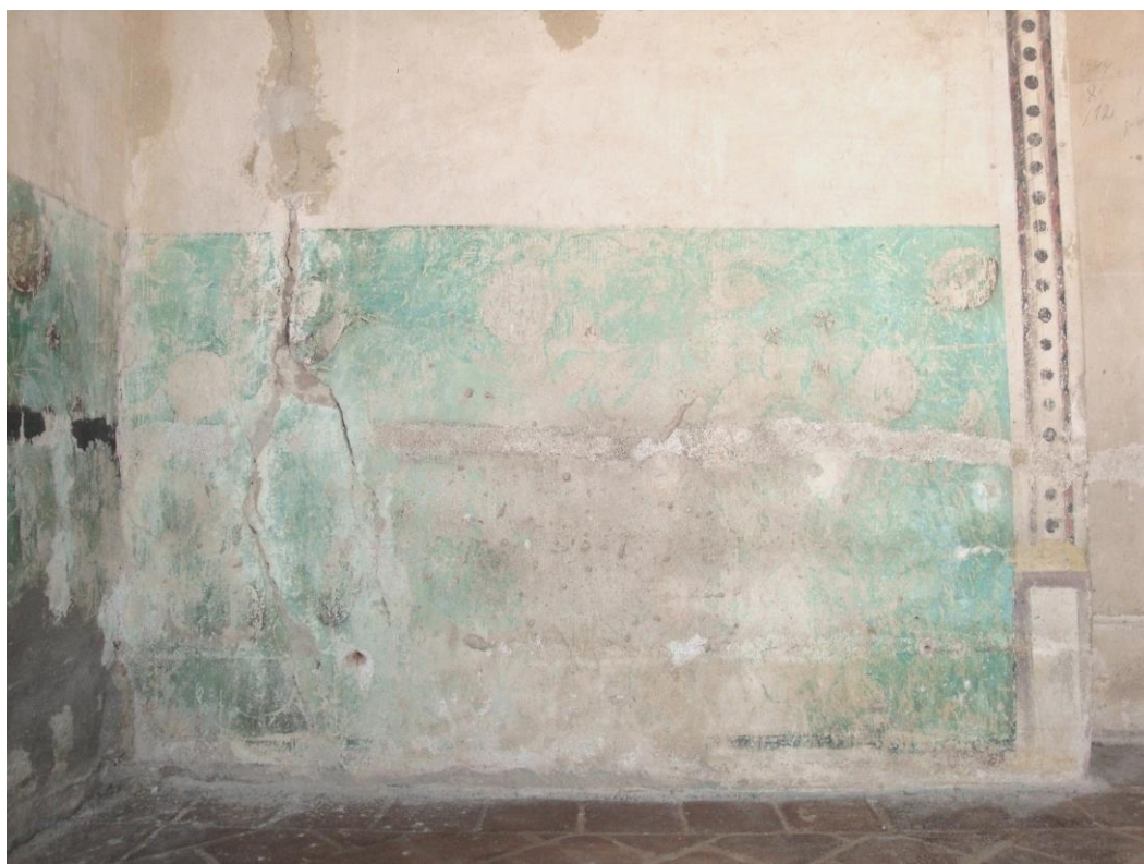
Obr. 37: Soklová část po odstranění černého pruhu, vápenných a cementových vysprávek.
