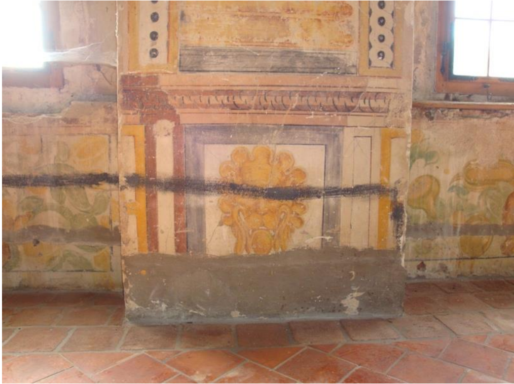
Obr. 35: Detail soklové části 1. sloupu zprava na jižní stěně. Přes hlavu maskarona vede novodobý černý dehtový nátěr, který měl určovat výšku nasypaného zrna.
