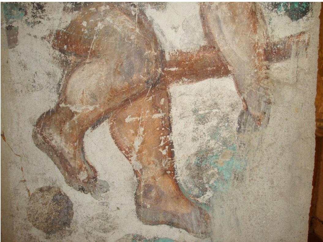
Obr. 19: Detail úseku severní stěny v místě ubourané příčky napravo od spodní části stromu. Štukové nánosy nedbale překrývají povrch malby směrem od nároží stěny.
