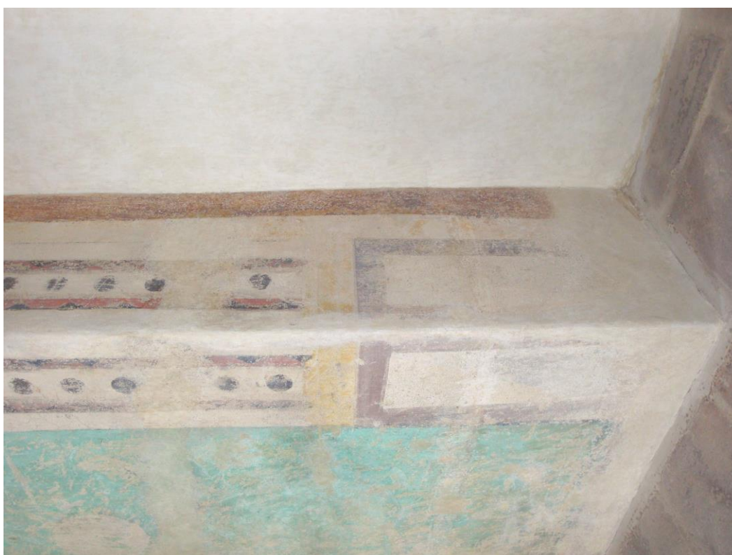
Obr. 89, 90: Boční špalety zazděného dveřního otvoru – stav po restaurování.
