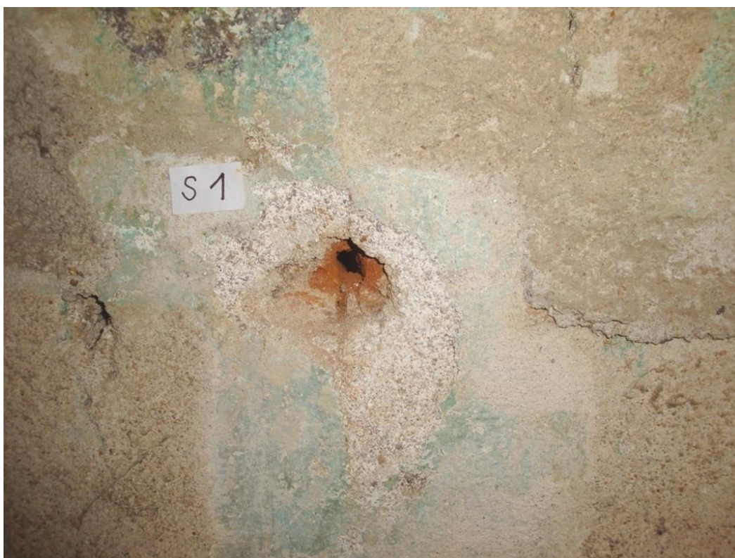
Obr. 13: Sonda S1 ve spodní části soklu prokazuje jednovrstvou omítku na cihlovém zdivu. Spodní část soklu v okolí sondy – barevný povrch malby místy překrývají cementové a vápenné nánosy.
