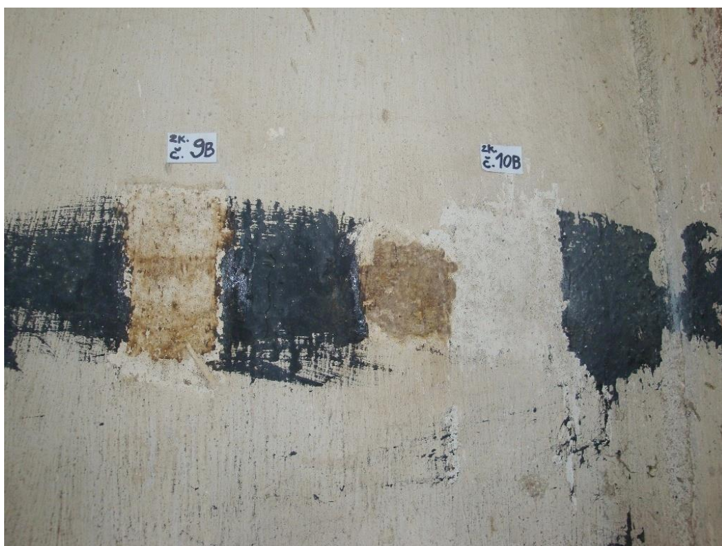
Obr. 25: Zkouška chemického čištění zk. č. 9B – odstraňovač starých nátěrů P05, zk.č.10B – mechanické čištění pomocí horkovzdušné pistole.
