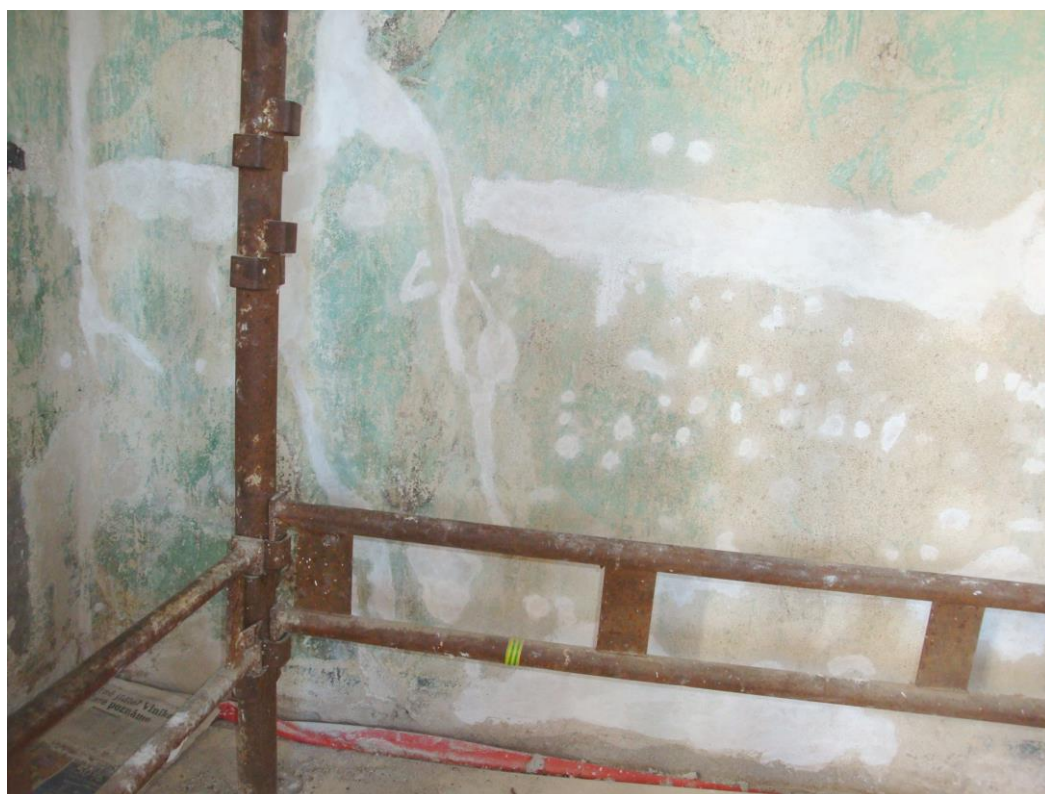
Obr. 72, 73: Jižní polovina restaurovaného úseku – stav po tmelení a pačokování.
