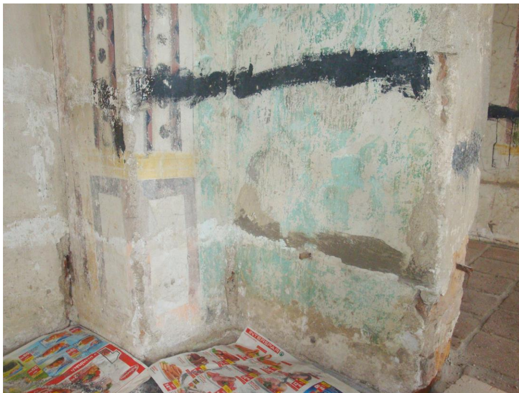
Obr. 42: Soklová část v průběhu odstraňování černého pruhu.
