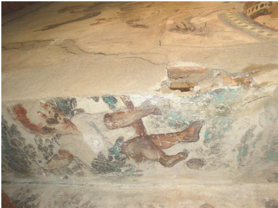
Obr. 52, 53: Stav během čištění a v průběhu hloubkové konsolidace.
