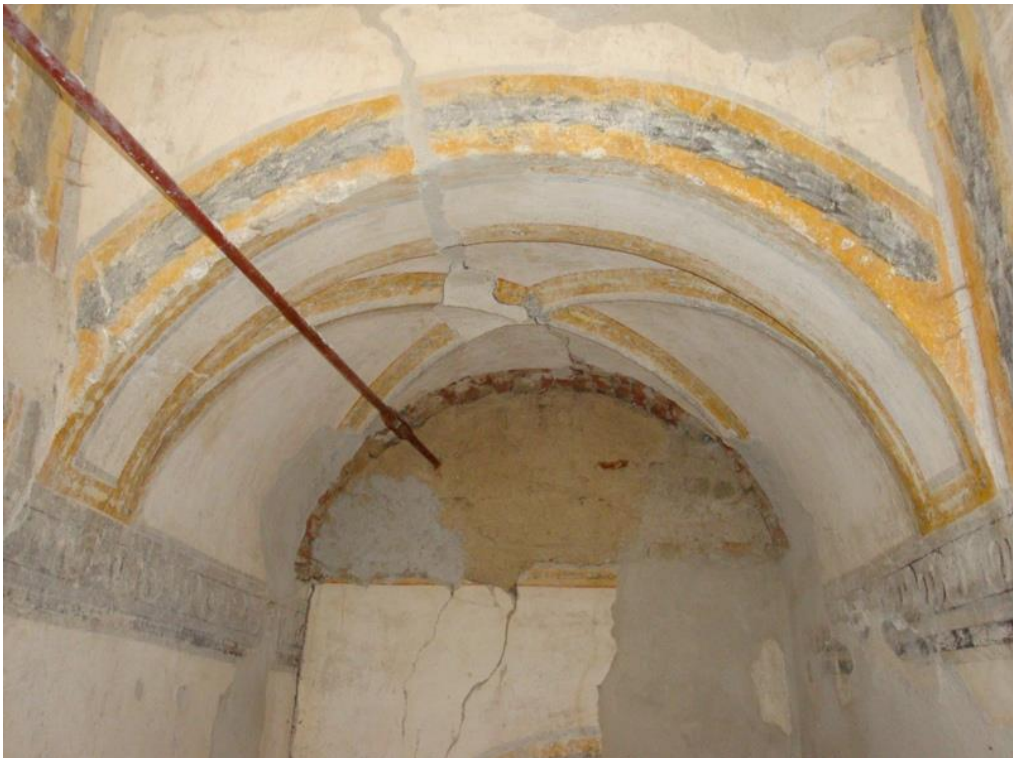
Obr. 42: Pohled na schodiště s šedým pásovým dekorem. Hřebínková klenba s dekorativní výzdobou završuje podestu schodiště, kterou se vstupuje do přízemí.
