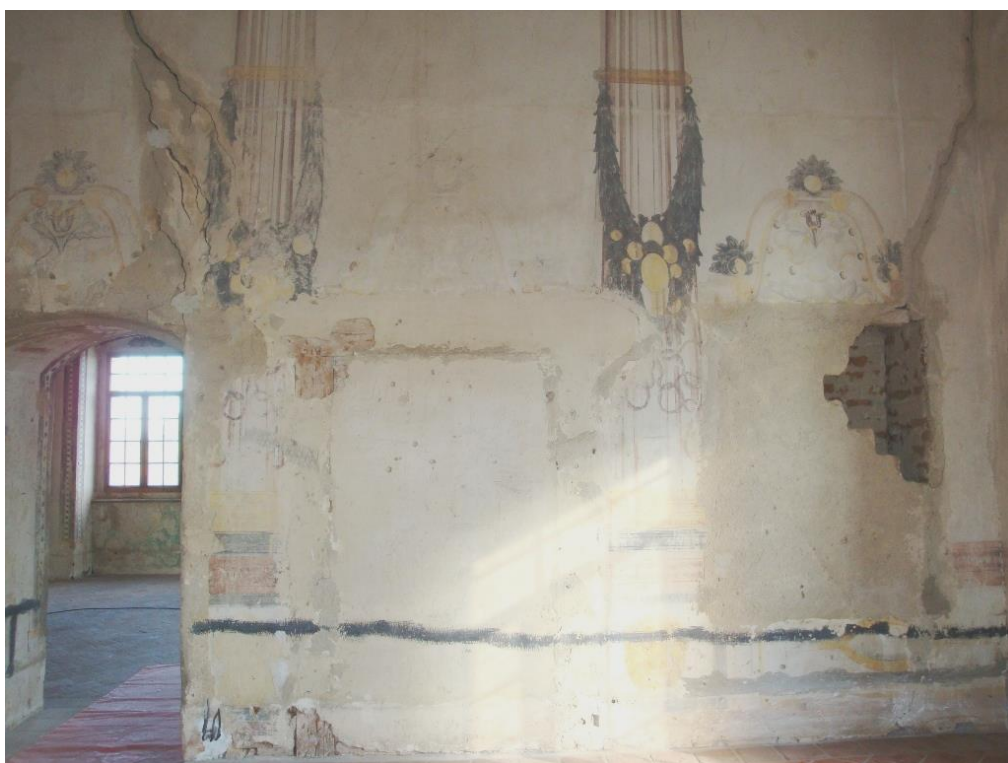
Obr. 28: Východní stěna s druhotně zazděným dveřním otvorem uprostřed a s výklenkem vestavěné skřínky napravo vedle jižního koutu. Díky kanelovaným sloupům zdobí vavřínové festony s ovocem. Portálové části malby zdobí opakující se dekory zavíjeného ornamentu s volutami, které jsou doplněné rostlinnými motivy.
