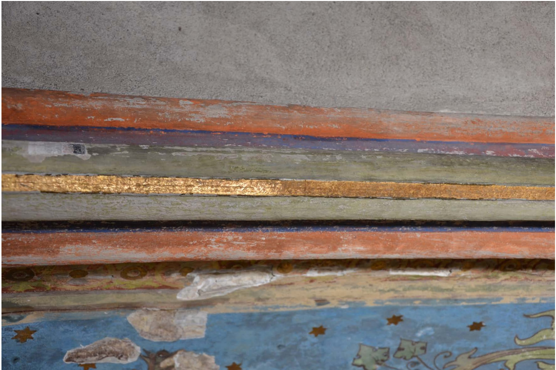
92. Průběh čištění. Detail zlacení na hřebínku žebra.
