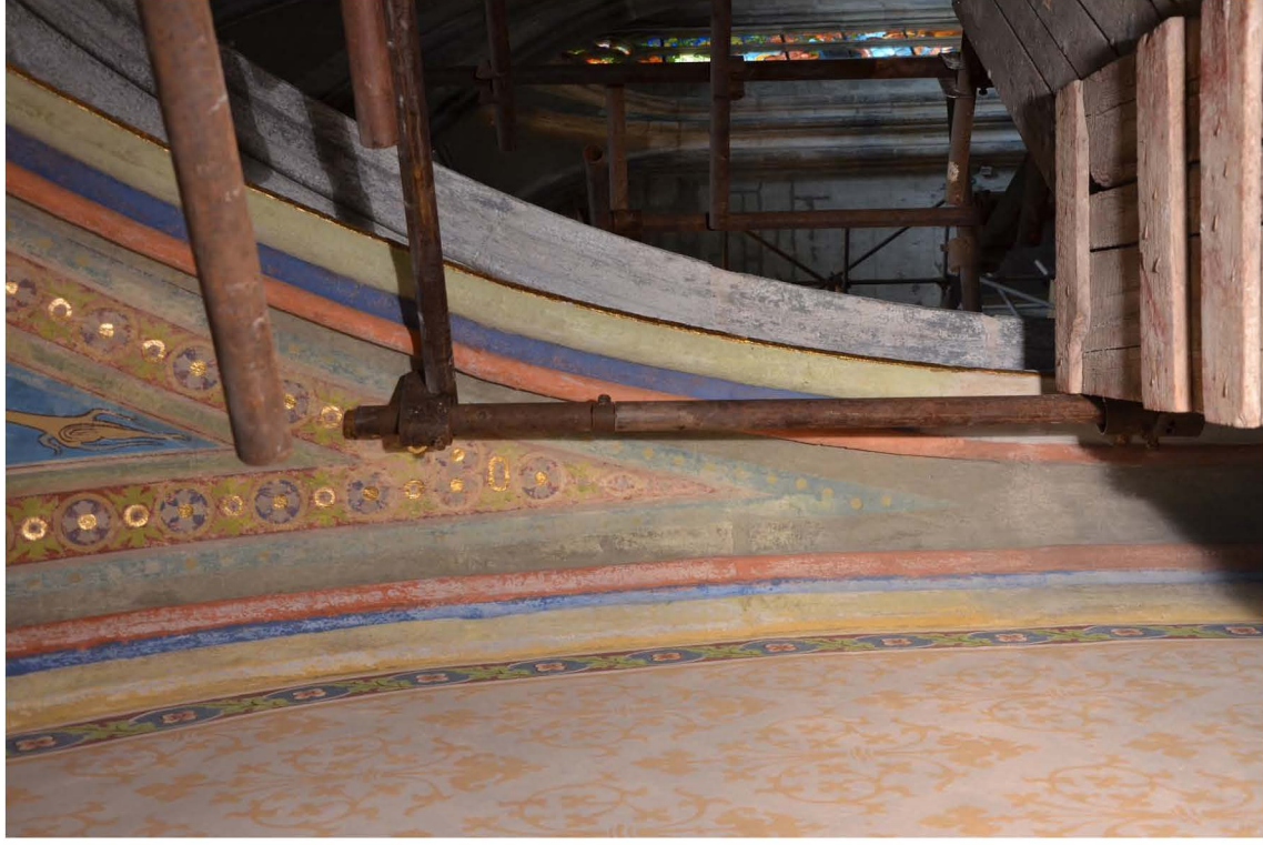
119. Právý náběh klenby. Stav po tmelení.
