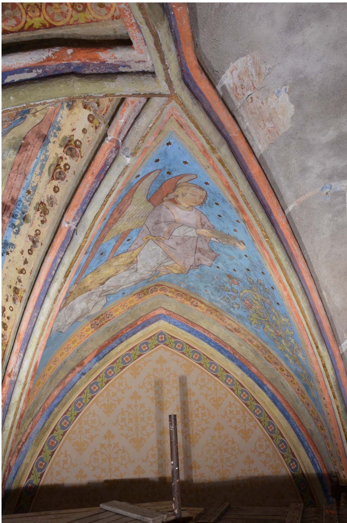
113. Celkový pohled. Stav po restaurování.
