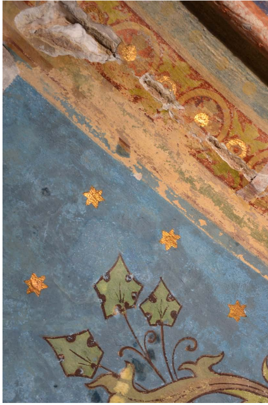
72. Stav po odstranění zábalu. Nedošlo k téměř žádným viditelným změnám v místě zkoušky.
