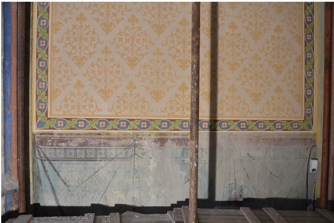
27. Část jižní stěny Řeznické kaple. V dolní části dochovaná část malované suknice, v horní části rekonstrukce šablonové výmalby z roku 2012.
