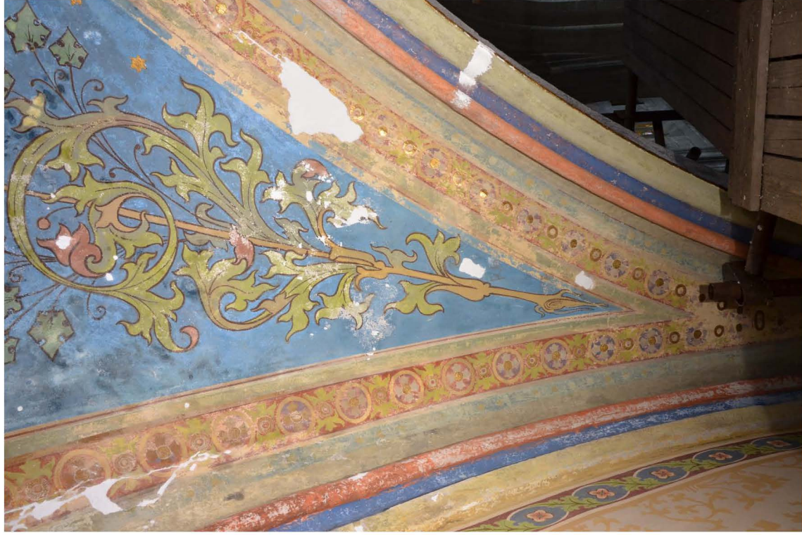
110. Pravý spodní kout klenby. Stav po tmelení.
