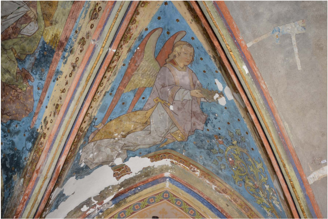
104. Celkový pohled. Stav po tmelení.
