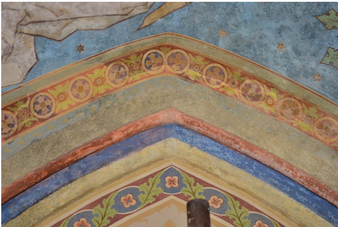
124. Detail bordury a přístěnných žeber. Stav po restaurování.
