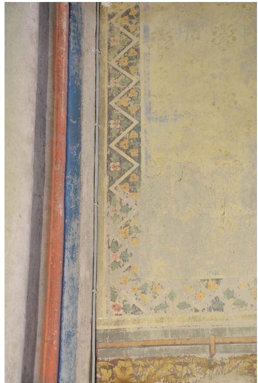
20. Detail dochované dekorativní výmalby stěny.
