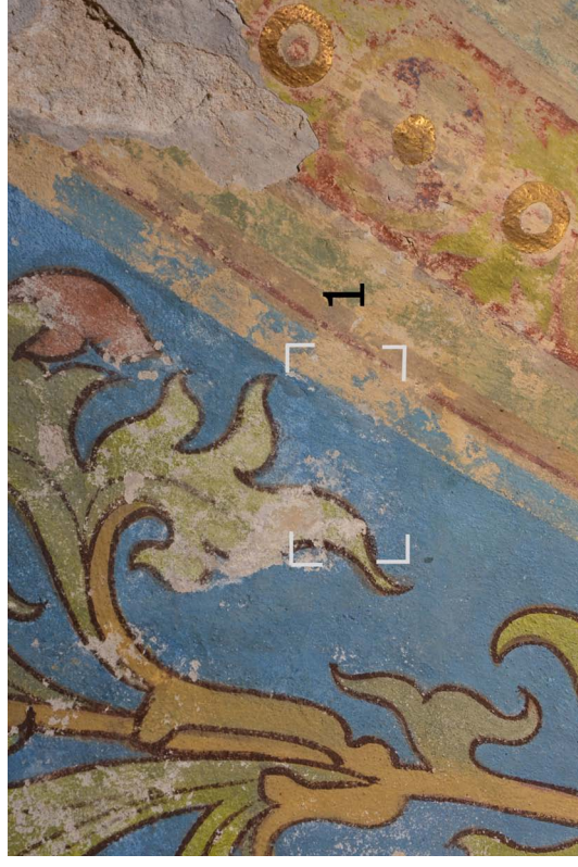
75. Místo zkoušky stabilizace síranu vápenatého nanospenzí hydroxidů barnatého. Po aplikaci. V místě zkoušky nedošlo k žádné viditelné změně.
