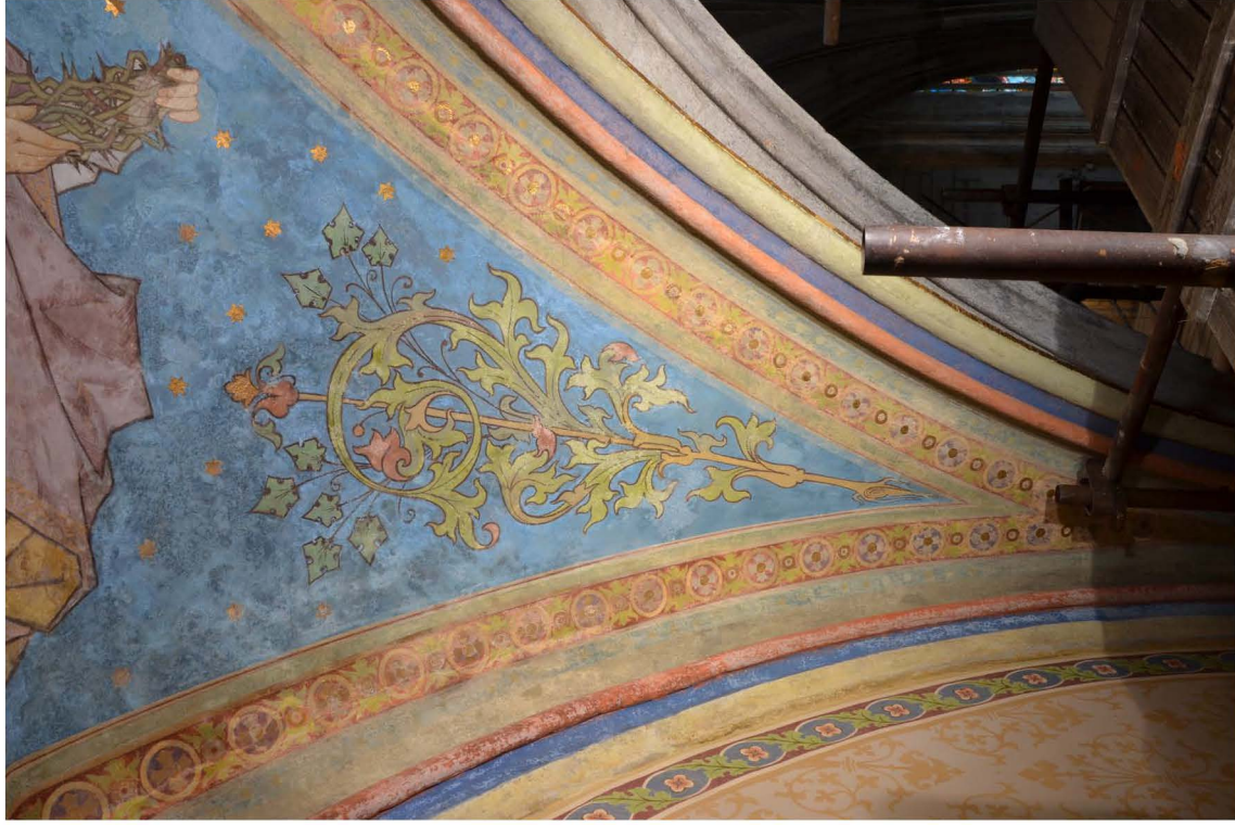
118. Právý spodní kout klenby. Stav po restaurování.
