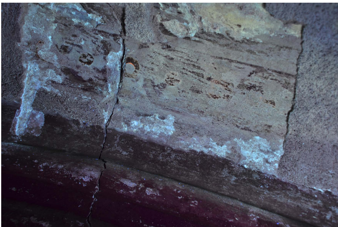
45. Průzkum v UV světle. Detail žebra a sondy v sousedním výjevu zakrytém omítkou. Přemalba se nachází pouze na žebře.
