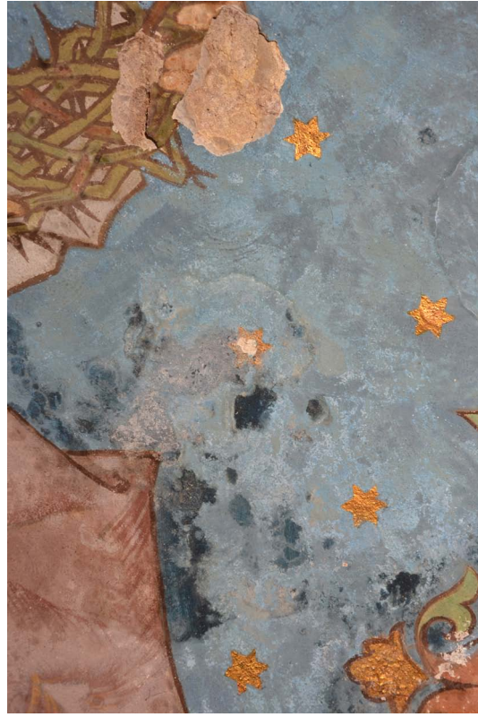
65. Stav po vyschnutí a odstranění odsolovacího zábalu. Zřetelný bílý povlak na místě zábalu a v okolí.
