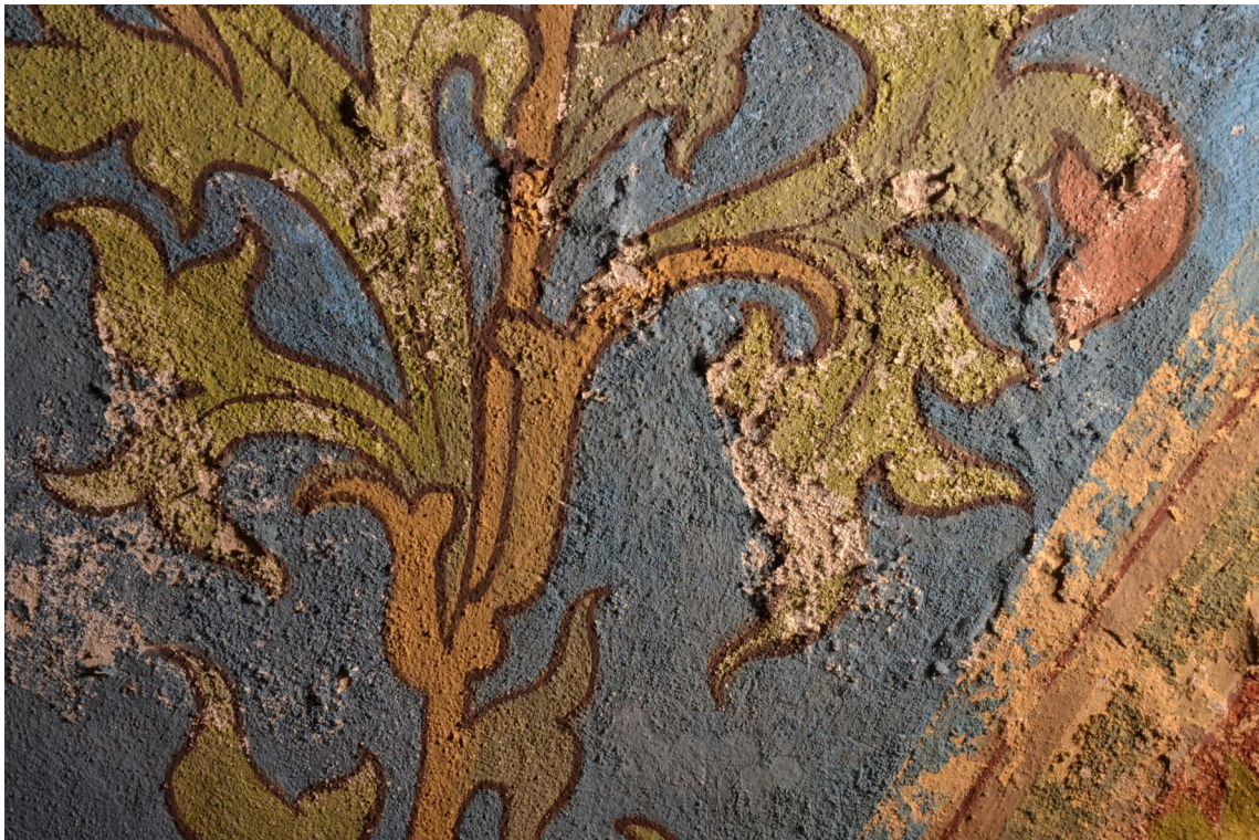
88. Detail zpráškovatělé a uvolněné barevné vrstvy. Stav před restaurováním. Foto v bočním světle.
