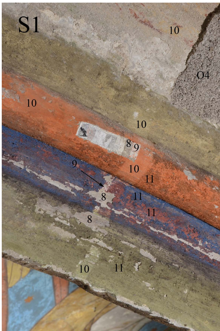
30, 31. Sonda S1, celek a detail, polychromie žebra v návaznosti na klenební pole zakryté omítkou.
