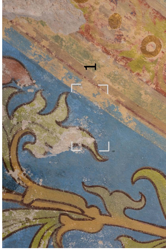
74. Místo zkoušky stabilizace síranu vápenatého nanospenzí hydroxidů barnatého. Před aplikací.
