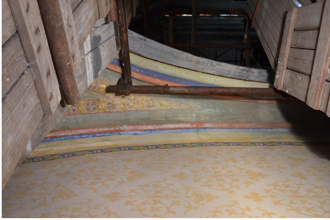
111. Pravý náběh klenby. Stav po tmelení.
