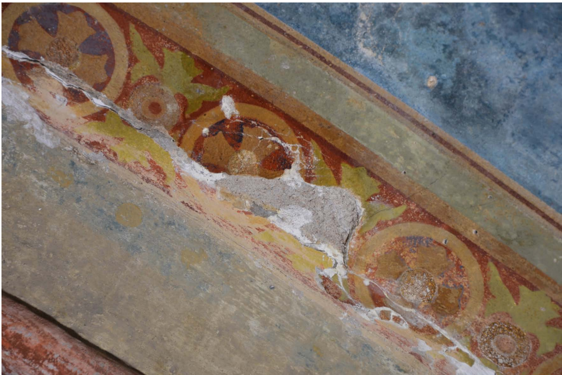
83. Průběh hloubkové konsolidace rozvolněných omítek v místě podélné praskliny mezi žebry a plochou klenby. Příliš uvolněné části byly sejmuty a omítka pod nimi zpevněna. Místo je vytmeleno a připraveno na osazení sejmutých částí. Ve spodní části fotografie jsou již některé části osazeny.
