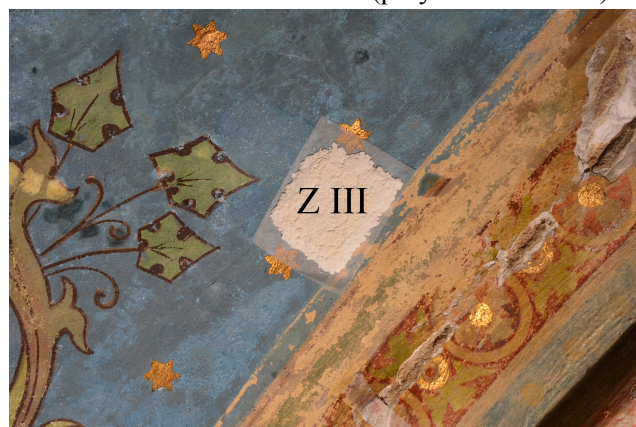
Umístění zkoušky odsolovacího zábalu III.
