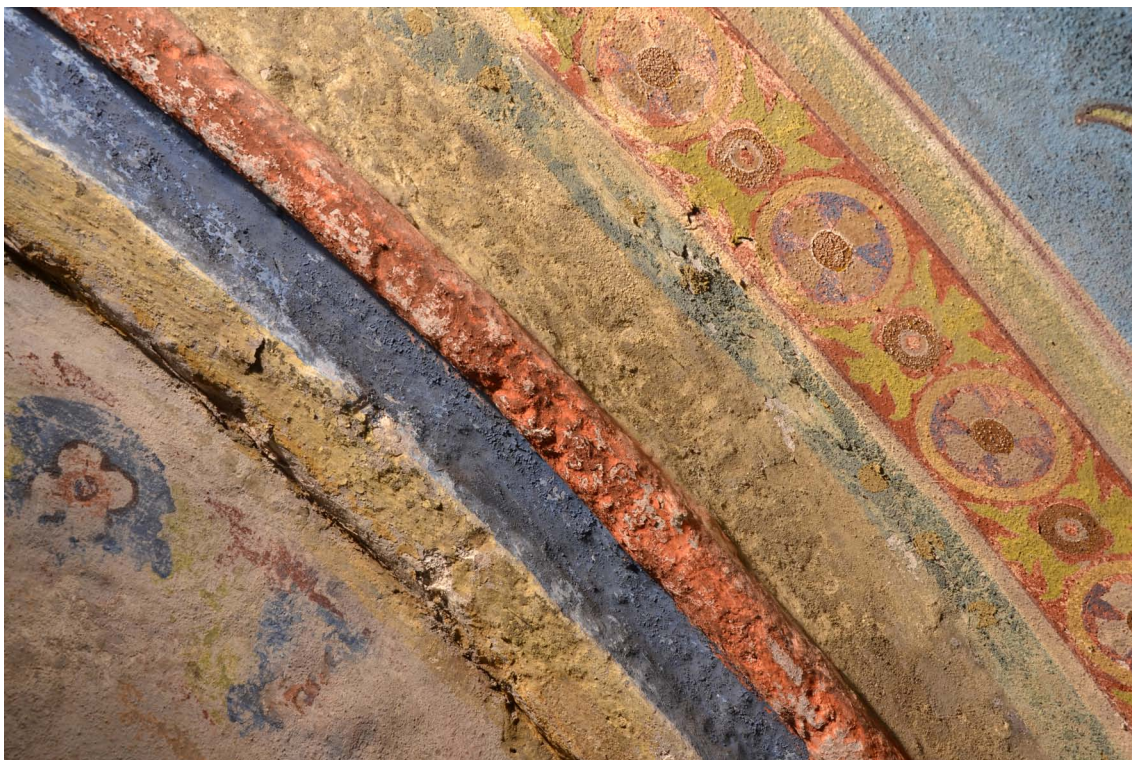
28. Průzkum v bočním světle. Detail poškozených profilů přístěnného žebra, na které byla provedena polychromie. Stav před restaurováním.
