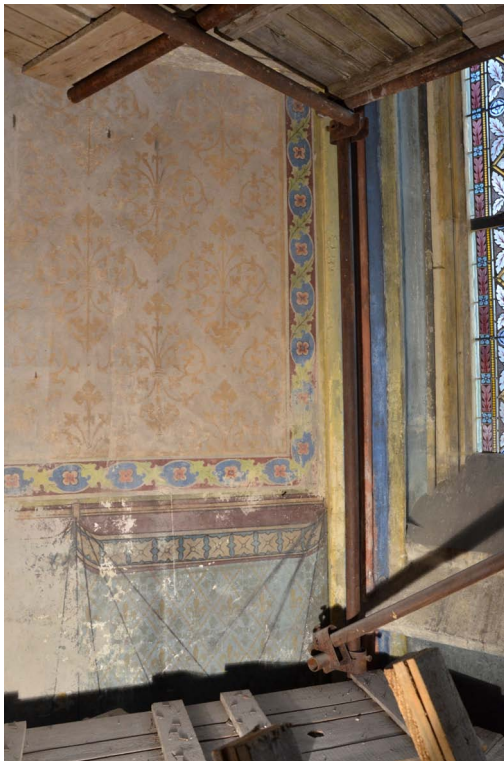
25. Detail dochovaného dekoru a malované suknice na severovýchodní stěně Řeznické kaple.
