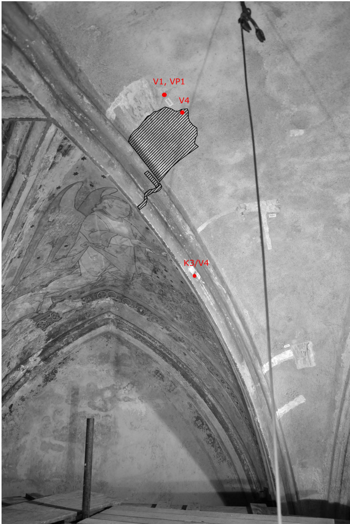
12. Zákres vlastního zásahu, sousední klenební pole zakryté omítkou.
