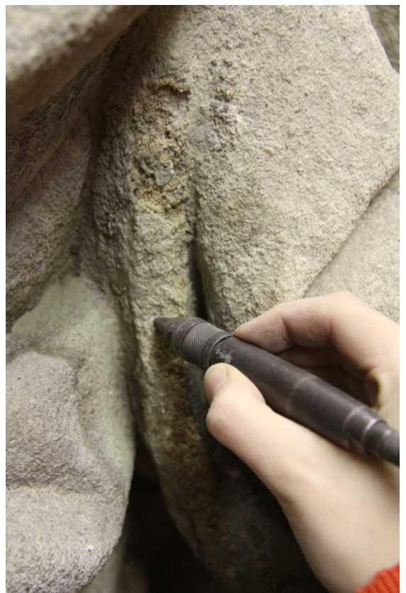
Obr. č. 20 – jemné odstraňování tmelů mikrotužkou
