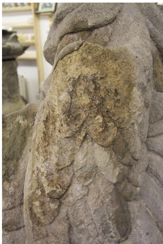
Obr. č. 30 - Konsolidace obnažených a drolicích se míst
