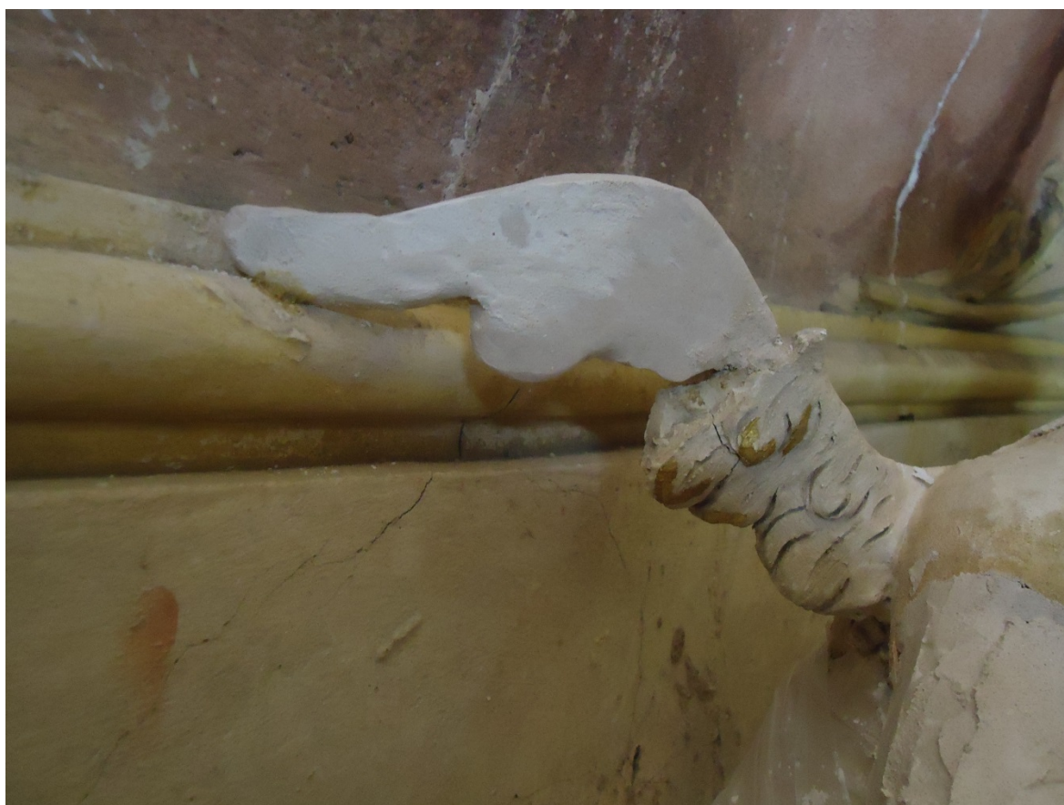
Obr. č. 111 - Připevněný podklad pro nanášení štukového křídla
