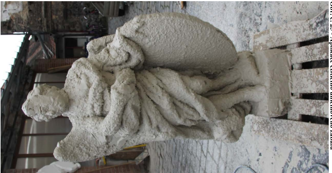
Obr. č. 25 - Aplikace čistícího uničnového zábalu
