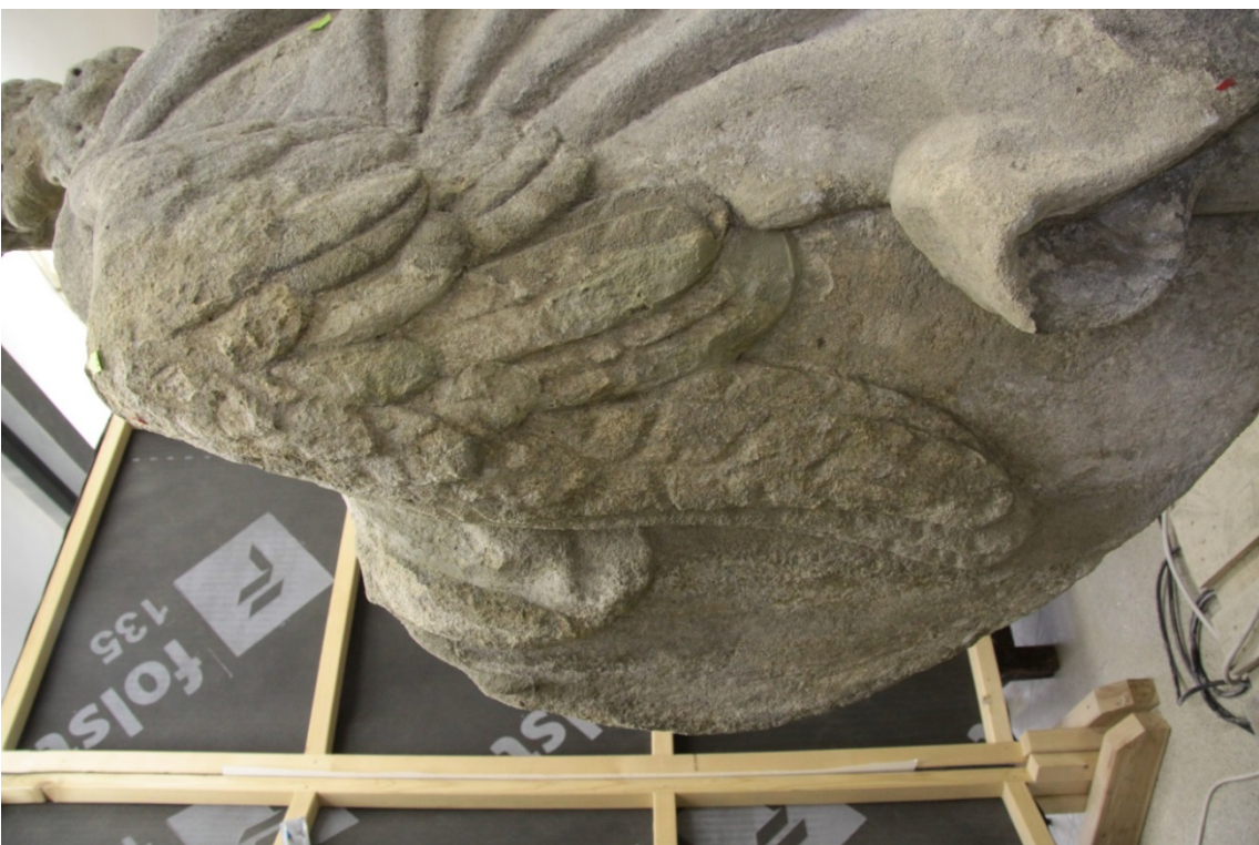
Obr. č. 22 - Stav zadní části levého křídla po očištění laserem
