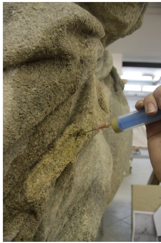
Obr. č. 28 - Injektáž prasklin
