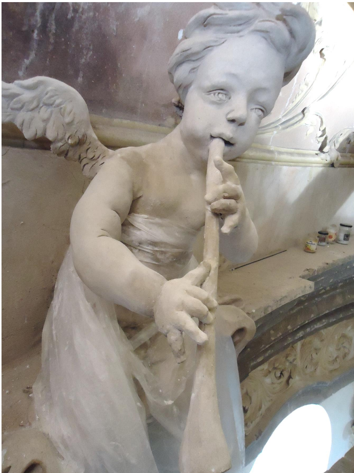
Obr. č. 116 - Namodelované chybějící prvky
