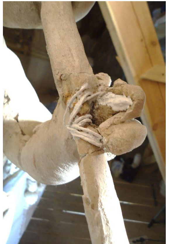
Obr. č. 104 - Ošetření obnažených drátů antikoročním nátěrem
