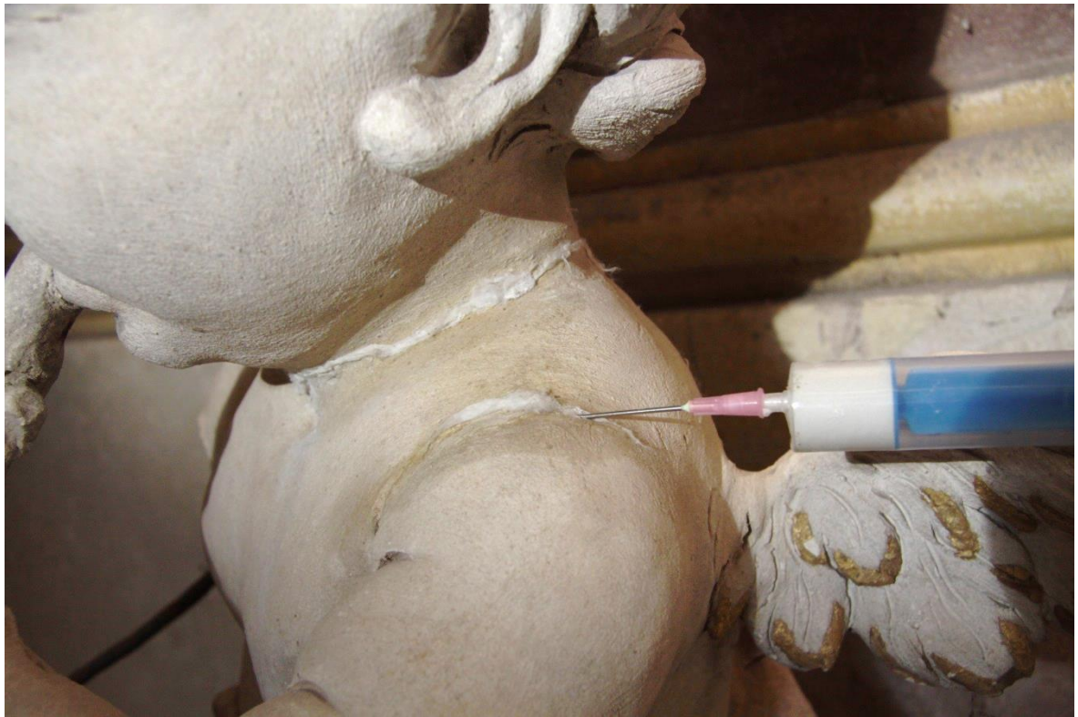
Obr. č. 100 - Injektáž prasklin krku a ramene
