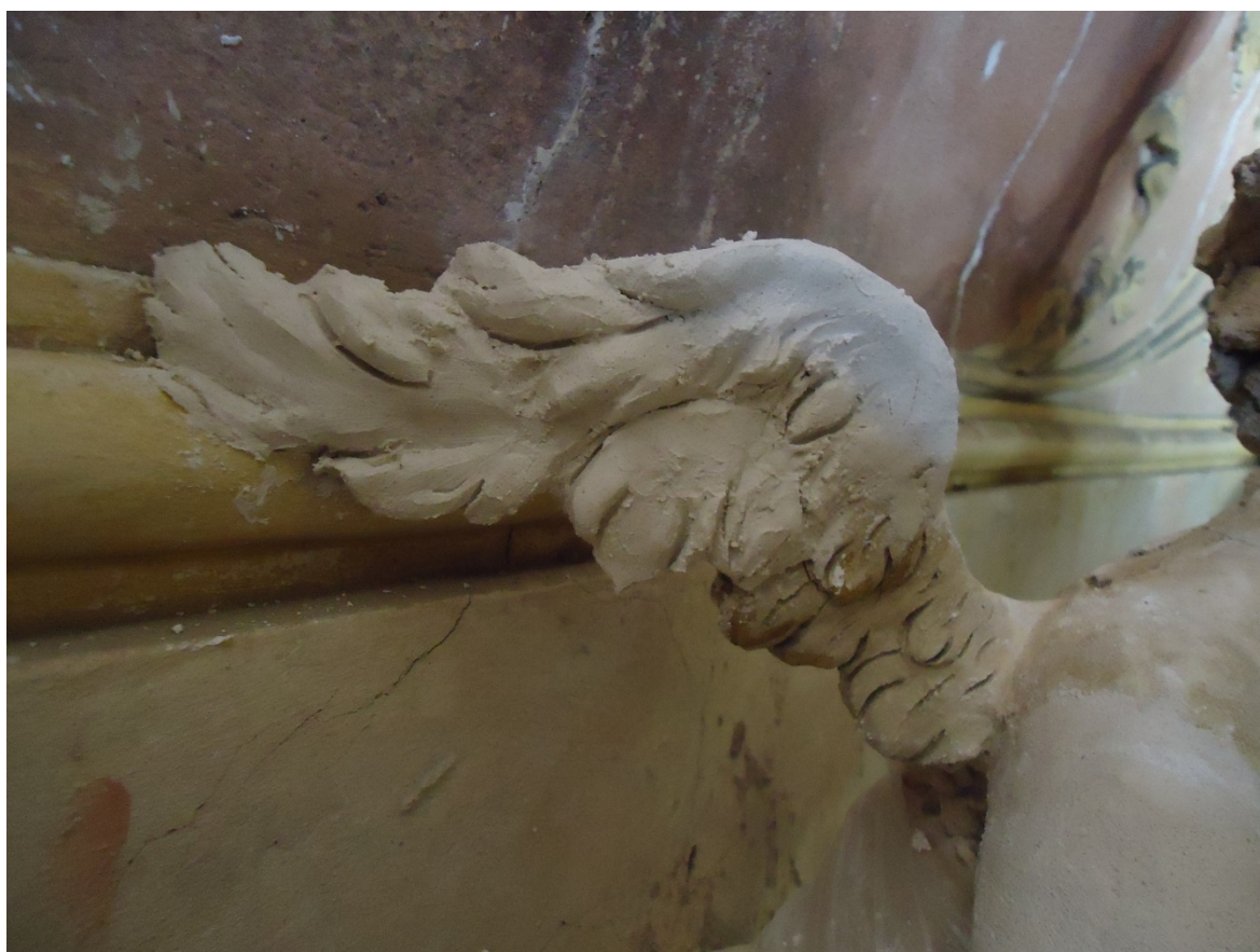
Obr. č. 115 - Nanášení a modelování štukového křídla
