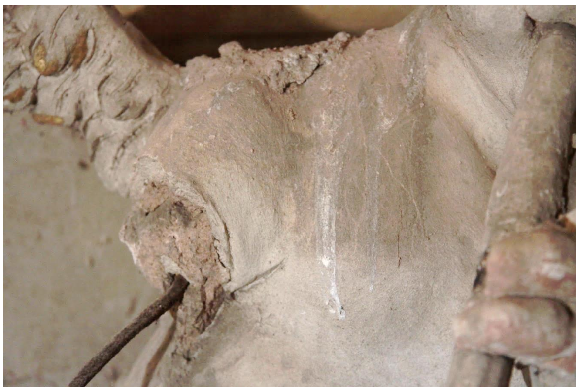
Obr. č. 97 - Čištění prachových depozitů
