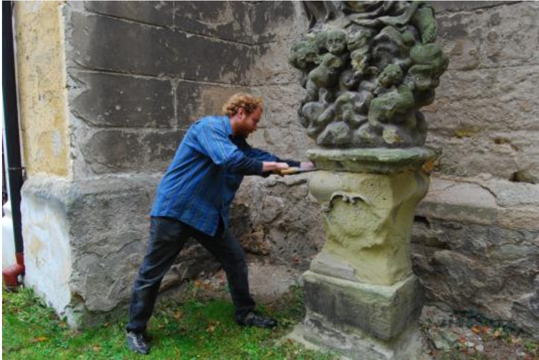
Obr. 58 Prořezávání ložné spáry (Foto Havlíčková Ivana)
