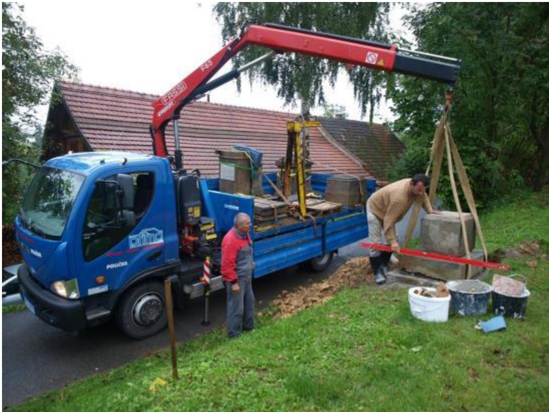
Obr. 66 Upevnění více částí na korbě nákladního auta, osazování kříže na nový betonový základ Janov u Litomyšle 2001 (Foto Müller)
