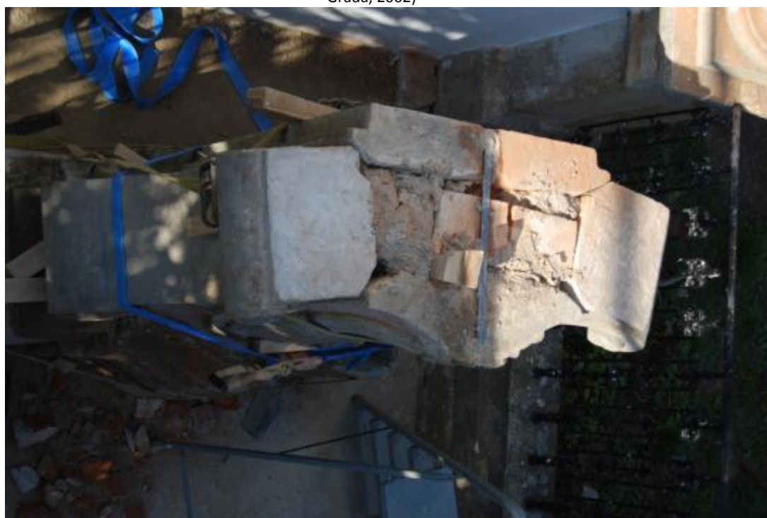
Obr. 38 Podstavec pod sochu Jana Nepomuckého ve Sloupnici, sokl dělený ve vertikálním směru, osazování na původní místo, použití kramle
