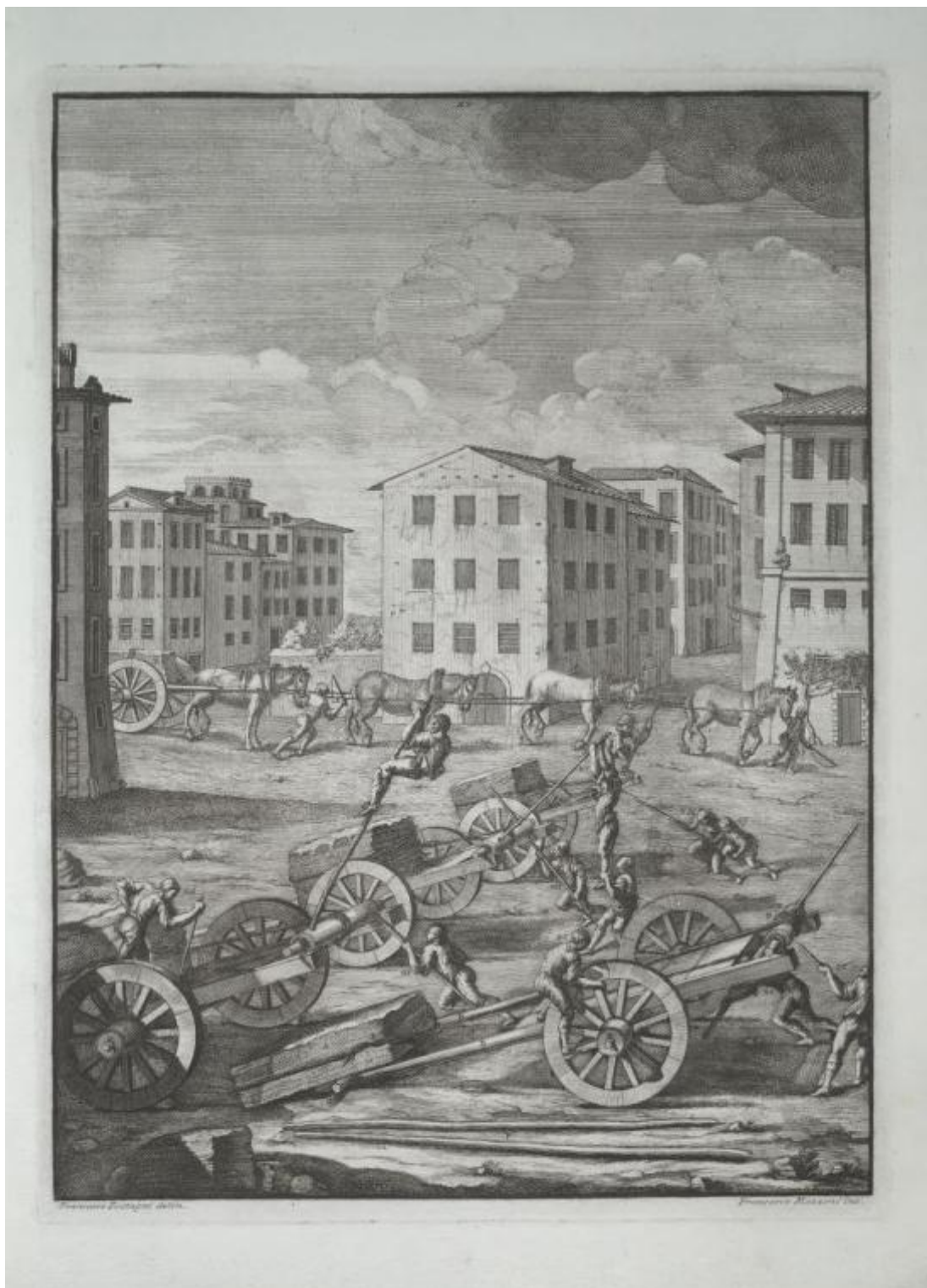
Obr. 51 Ukázka nakládání kamenných bloků na dvoukolové vozy, pomocí rumpálu (Marino Angela: Sapere e saper fare nella fabbrica di San Pietro. «Castelli e ponti» di maestro Niccola Zabaglia 1743, Roma )
