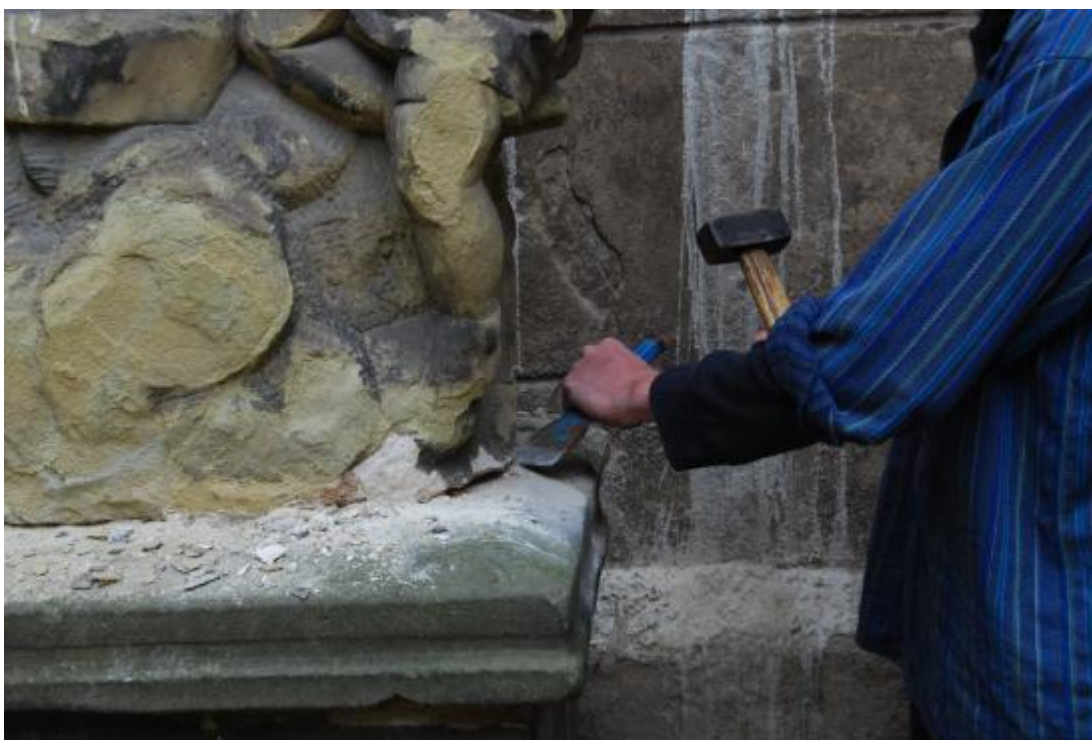
Obr. 57 Uvolňování ložné spáry (Foto Havlíčková Ivana)
