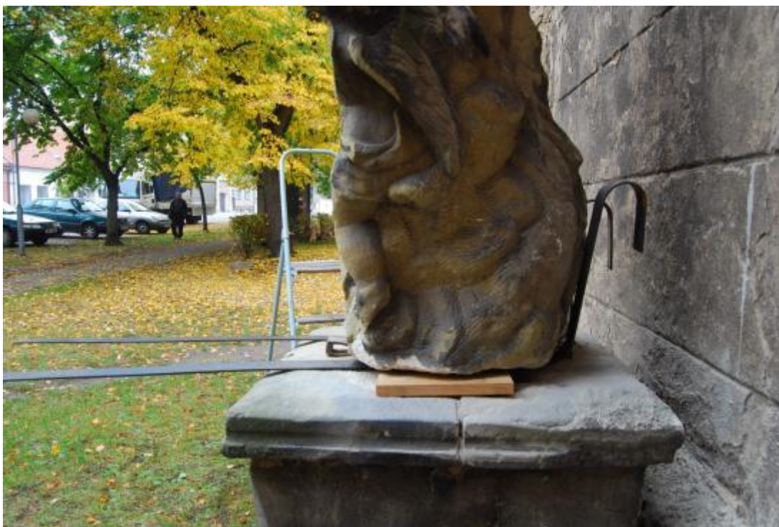
Obr. 60 Instalace pomocné konstrukce (Foto Havlíčková Ivana)
