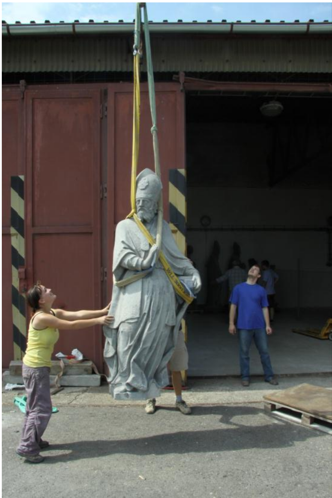
Obr. 53 Uvázání díla pod těžištěm, při osazení na kamenný podstavec Obr. 54 Uvázání sochy při změně polohy z vodorovné do svislé
