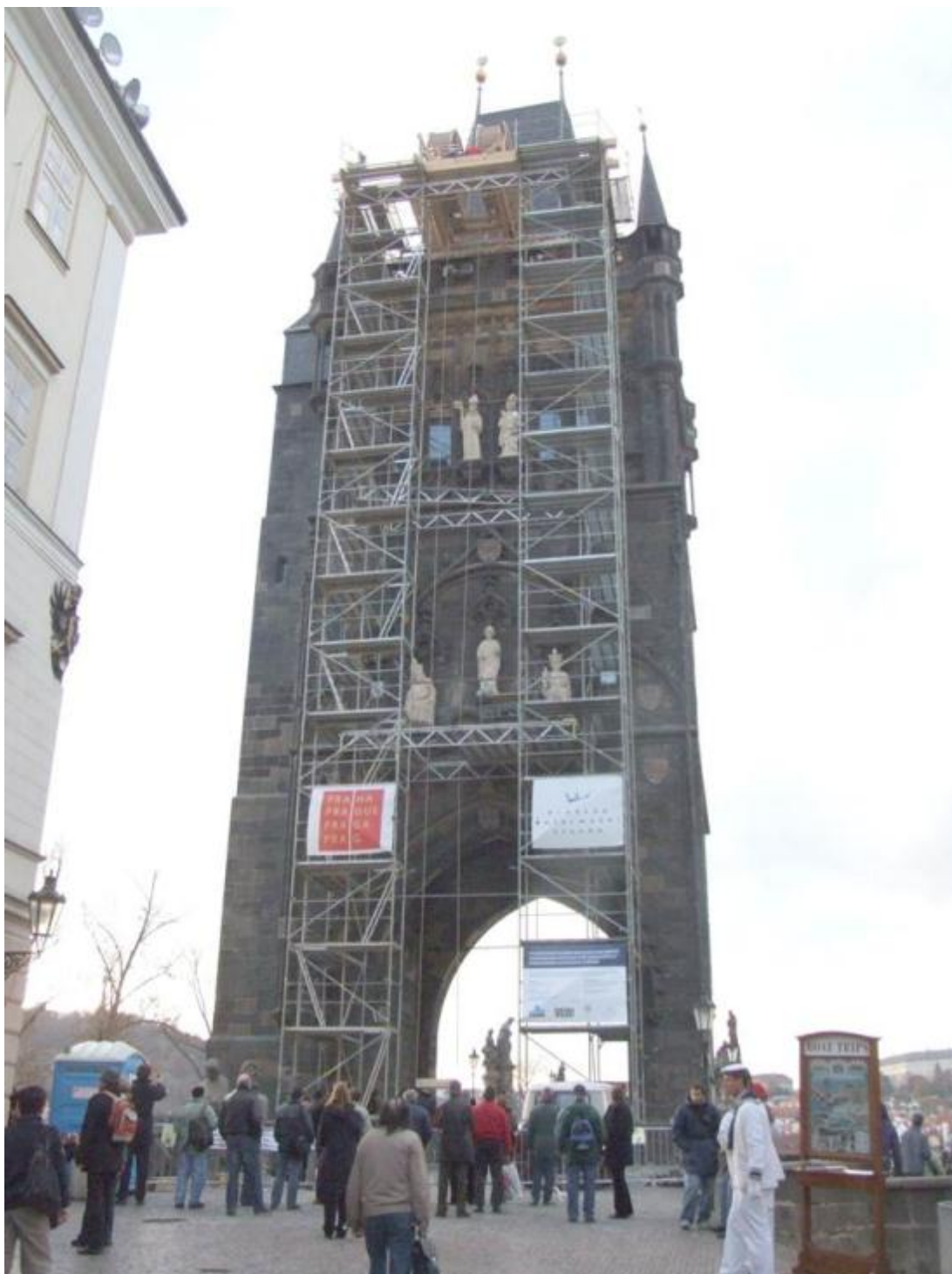
Obr. 29 Osazování sekaných kopií na průčelí Staroměstské mostecké věže, pomocí repliky šlapacího jeřábu (Foto Jakub Dóubal)
