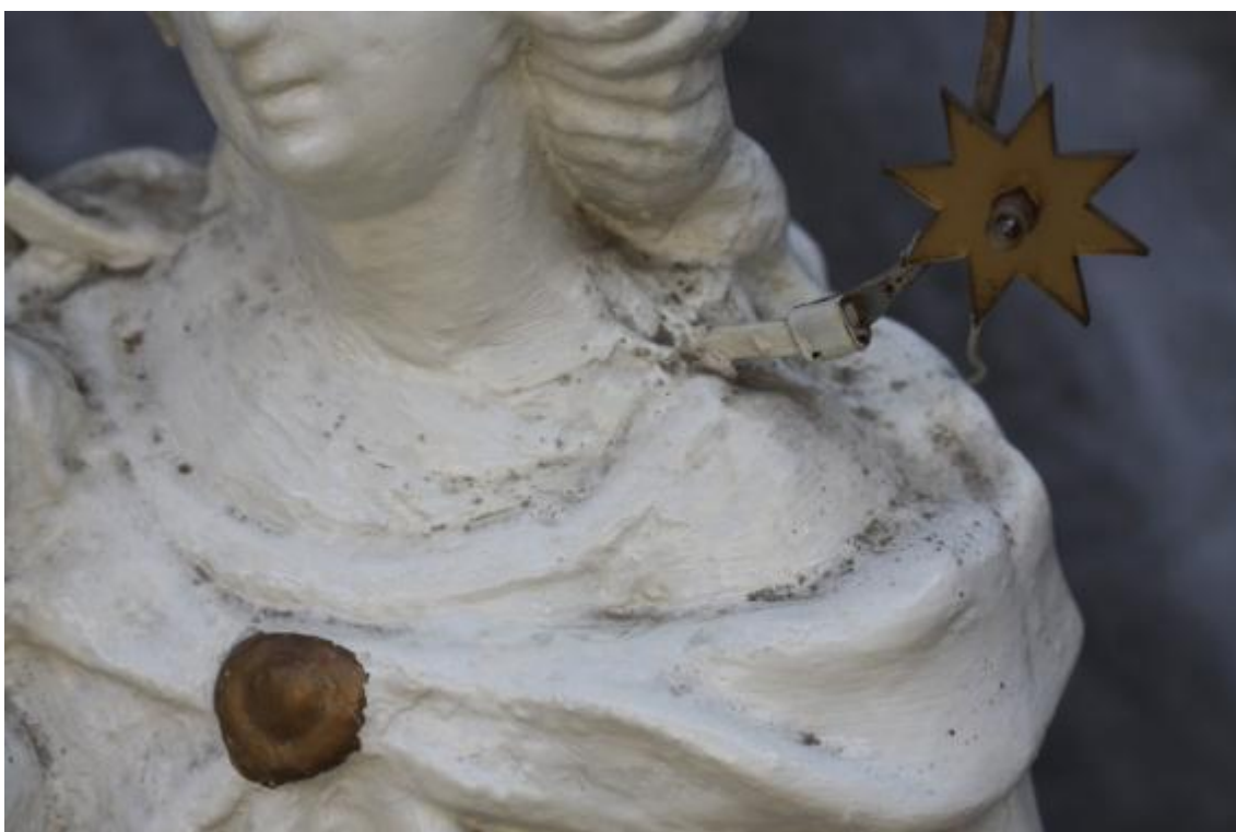
Obr. 92 Pod nátěrem patrné tmely ze syntetické pryskyřice v místech přilepení krku k trupu, nevhodná imitace zlacení spony pláště, kotvení a připevnění novodobé svatozáře, detail hvězdičky se žárovkou
