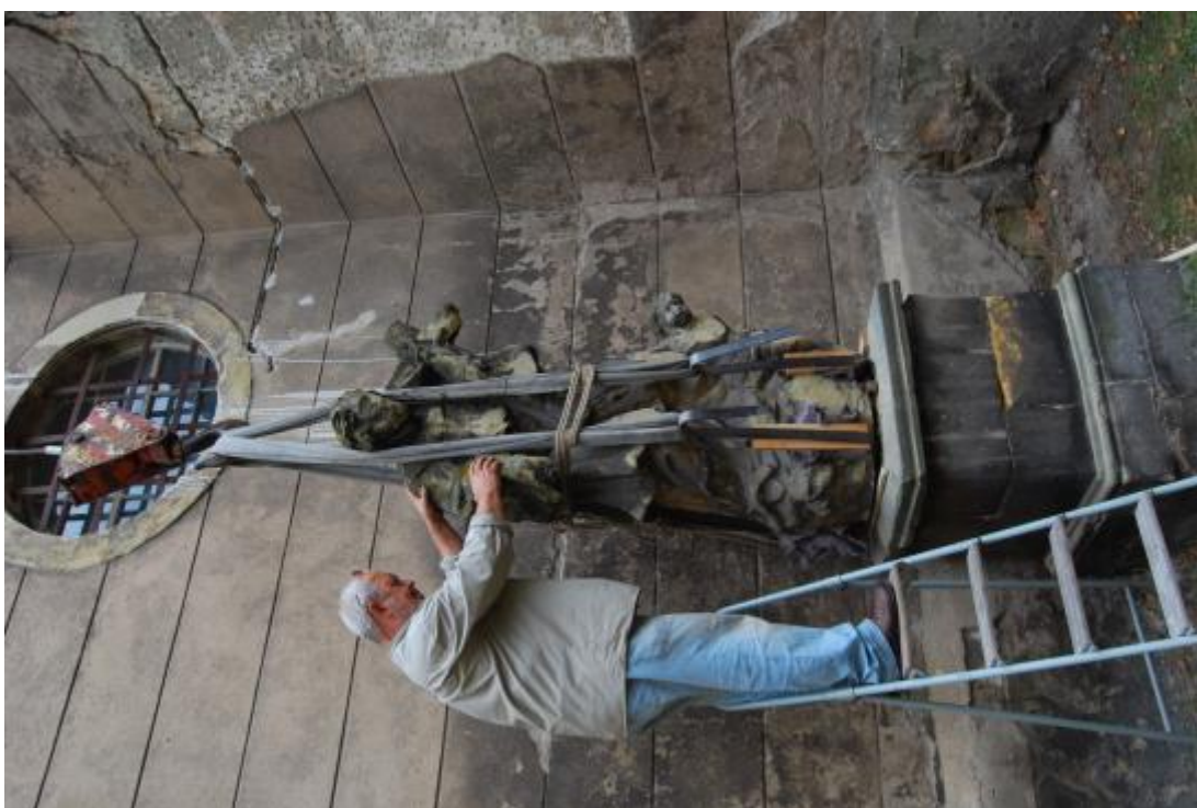
Obr. 61 Demontáž díla pomocí na míru vytvořené podpůrné konstrukce, syntetických úvazů a konopného lana (Foto Havlíčková Ivana)
