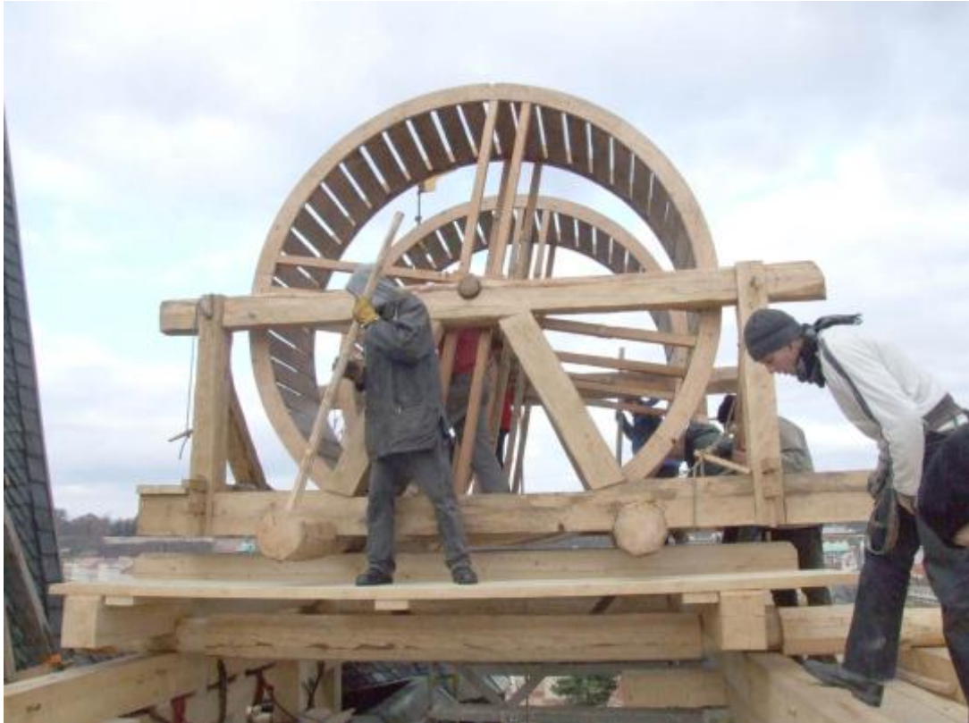
Obr. 30 Obsluha šlapacího jeřábu, zapůjčený z pražského hradu při osazování soch na Staroměstskou mosteckou věž, s jeho pomocí jeden člověk zvedne až 600 kg (Foto Jakub Ďoubal)
