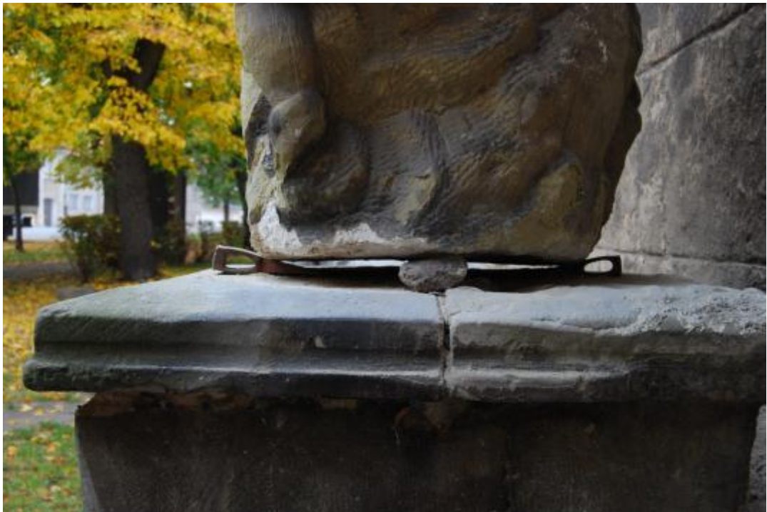
Obr. 59 Nadzvednutí sochy vyklínováním (Foto Havlíčková Ivana)
