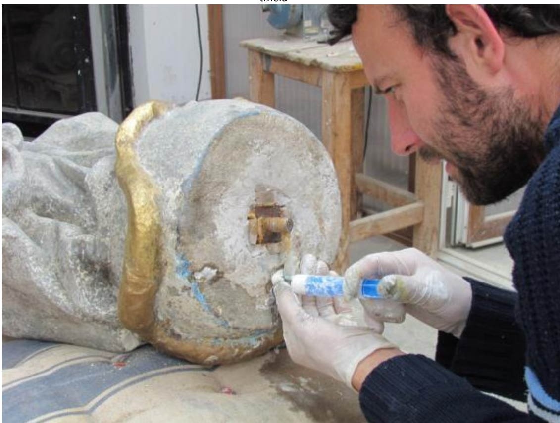
Obr. 114 Injektáž prasklin na ložné ploše.
