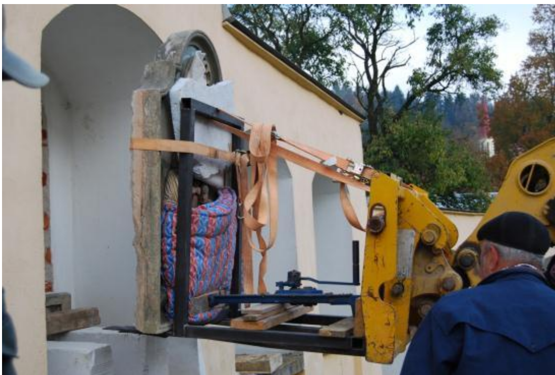
Obr. 64 Osazování pískovcového reliéfu do těsné a hluboké niky, upevněný do speciální konstrukce, pomocí manipulátoru s teleskopickým ramenem (Foto Havlíčková Ivana)
