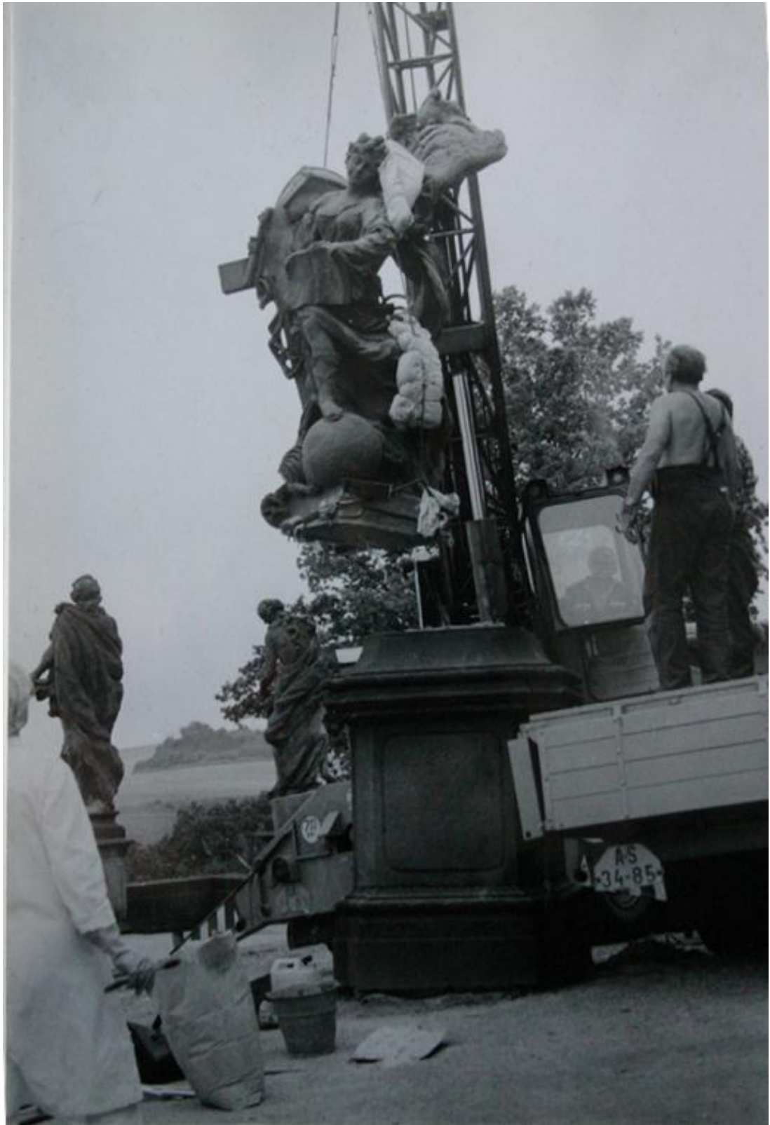
Obr. 25 Osazení sochy Náboženství na Kuksu (Hlavatý V., Vajchr M., Viškovská A., Vitvar J.: Restaurátorská zpráva o restaurování podstavce pod sochu náboženství, instalaci originálu sochy náboženství na podstavec a jejich restaurování v galerii M. B. Brauna v areálu st. Zámku Kuksu, Praha, 15. března 1984)
