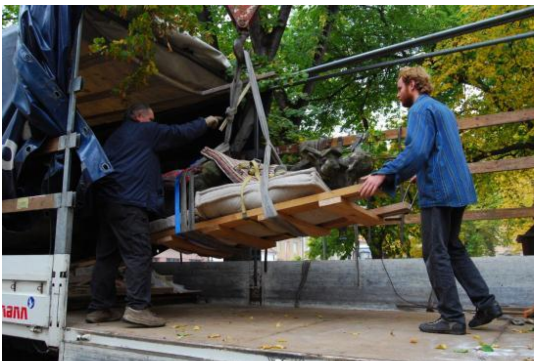
Obr. 63 Ukládání sochy na korbu, pomocná konstrukce a matrace přenesou vibrace během cesty a zabrání převalování sochy (Foto Havlíčková Ivana)
