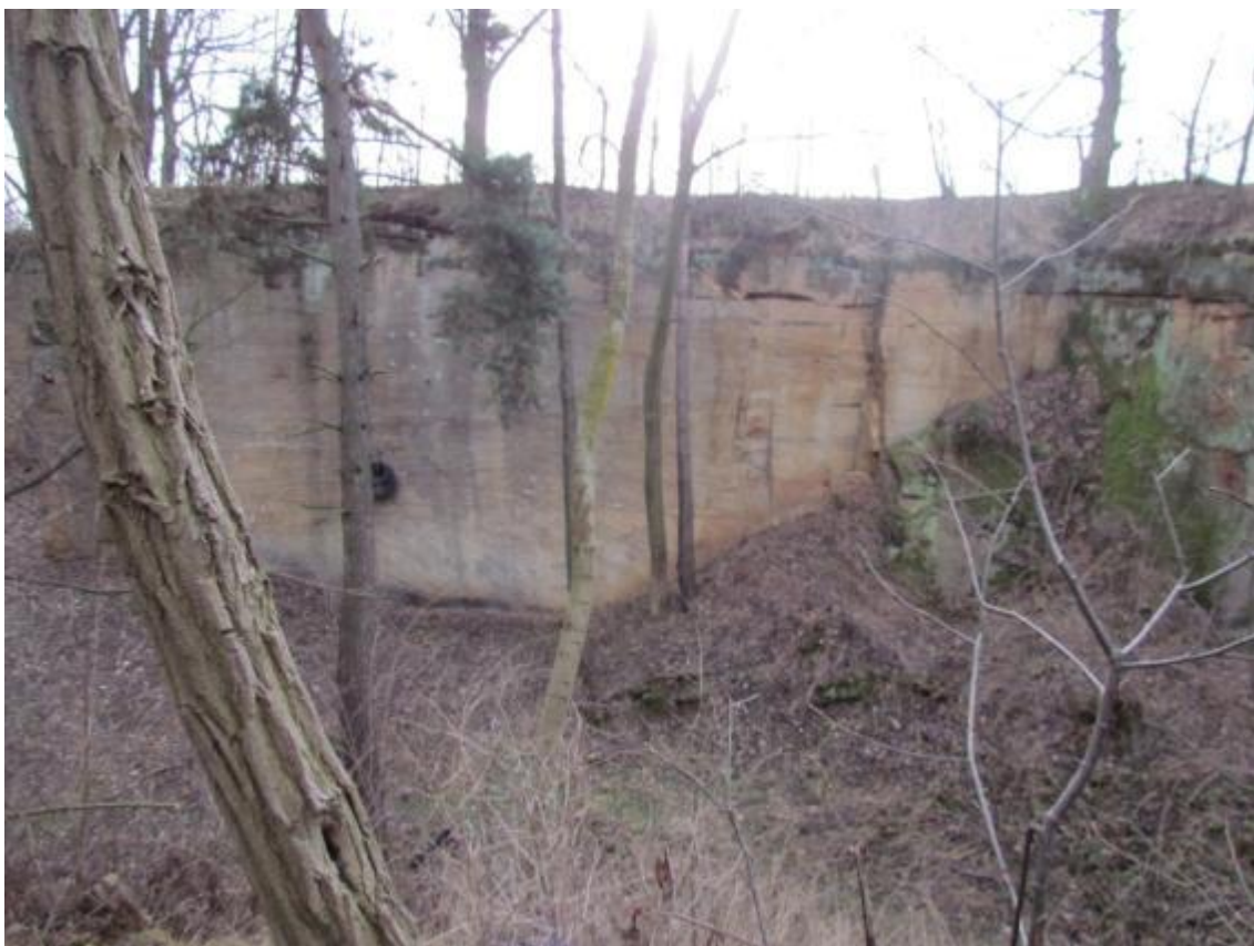
Obr. 79 Pohled na jednu ze stěn lomu v lokalitě Škrovád
