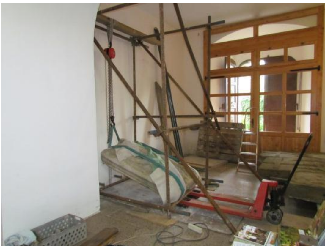
Obr. 65 Instalace 1 t pískovcového reliéfu v interiéru kostela v Písečné
