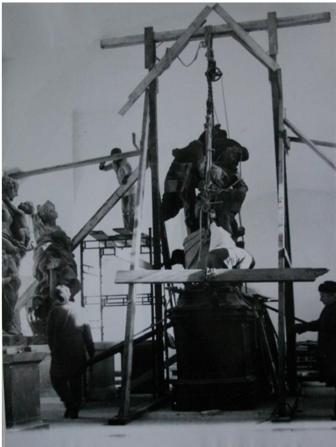
Obr. 23 Instalace sochy Náboženství v interiéru galerie na Kuksu (Hlavatý V., Vajchr M., Viškovská A., Vitvar J.: Restaurátorská zpráva o restaurování podstavce pod sochu náboženství, instalaci originálu sochy Náboženství na podstavec a jejich restaurování v galerii M. B. Brauna v areálu st. Zámku Kuksu, Praha, 15. března 1984)
