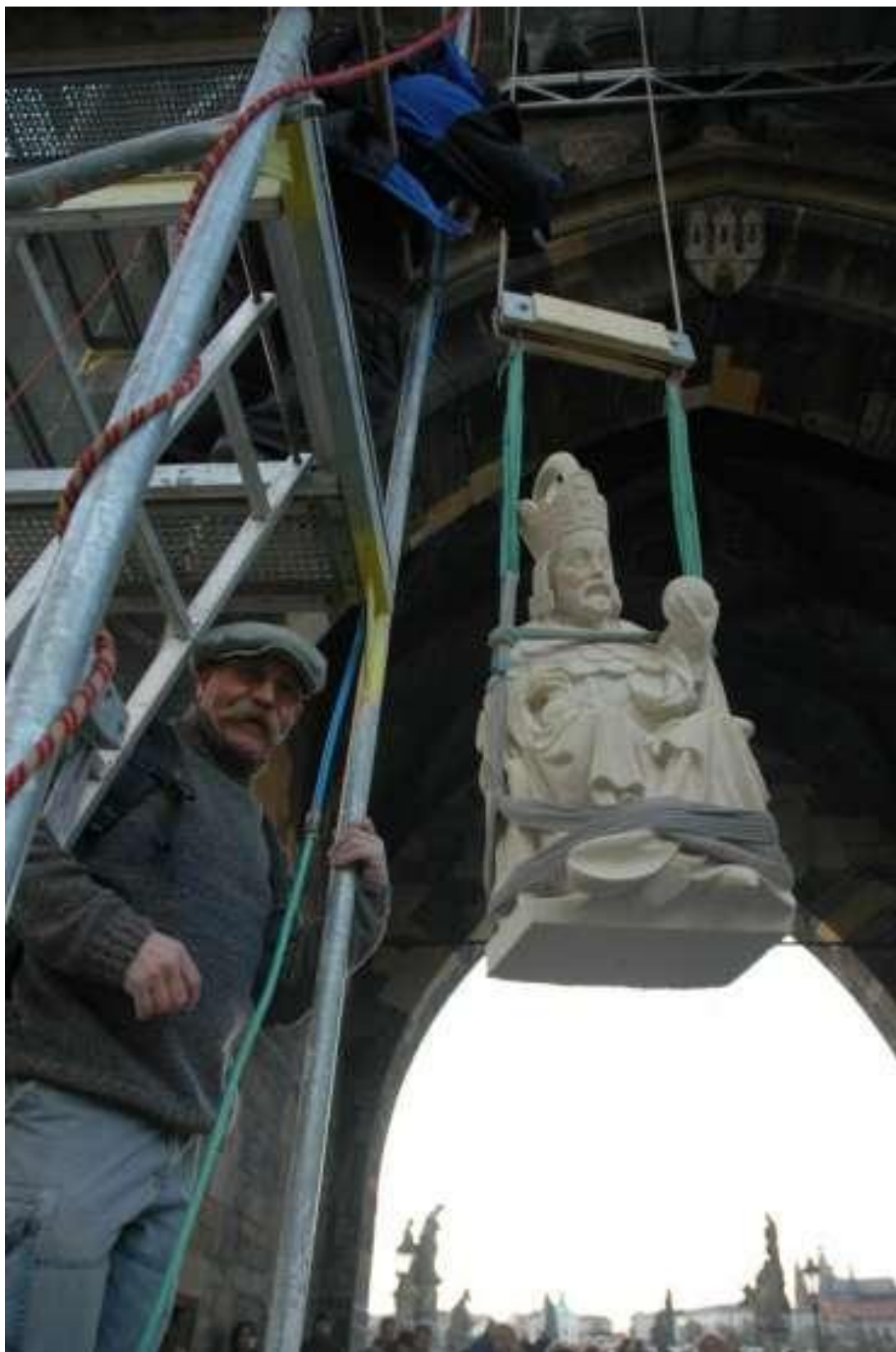
Obr. 32 Uvázání materiálové kopie Karla IV, při osazování na průčelí Staroměstské mostecké věže, pomocí repliky kolového jeřábu ( http://aktualne.centrum.cz/veda/fotogalerie/2006/11/07/staromestska-vez-na-karlove-moste-svati-sestupuji-na-zem-a-stoupaji-zpatky-k/ )
