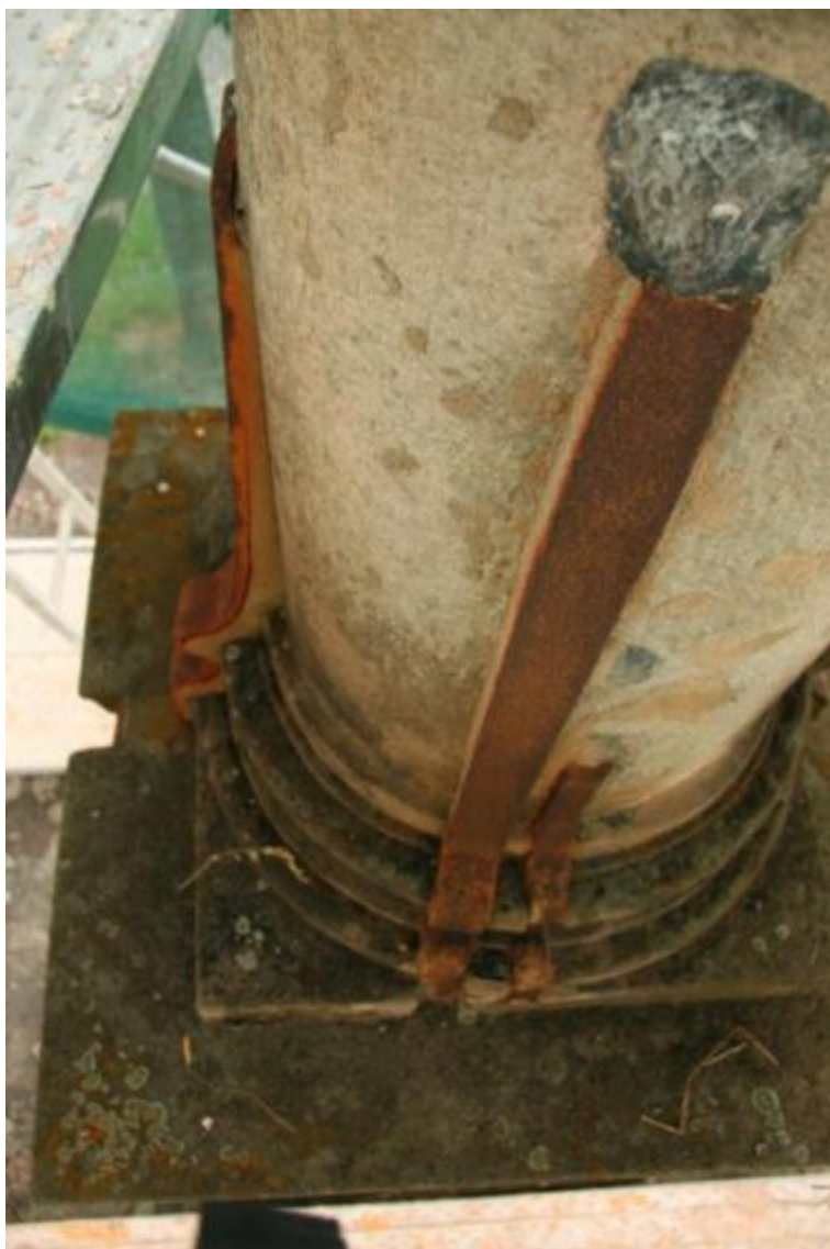
Obr. 39 Nalévací otvor pro olovo a profilované kovové kramle (Zdeněk Šmahel: Absolventská práce, Restaurování sochy sv. Jana Nepomuckého , Univerzita Pardubice, Fakulta restaurování, Litomyšl, 2010, foto č. 10)
