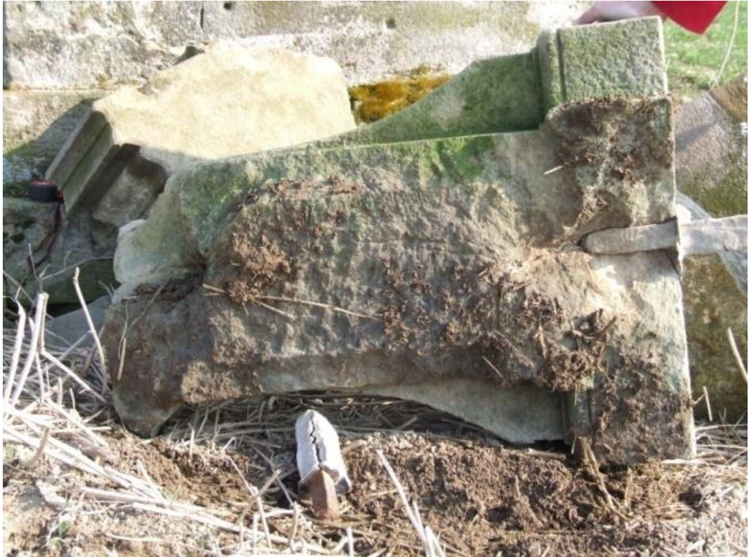
Obr. 35 Kamenný podstavce poškozený úderem blesku, kovové čepy zalité na olovo
