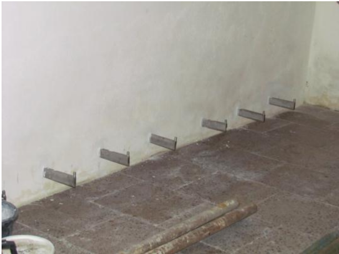
Obr. 40 Nerezové konzole pro osazení pískovcových reliéfů v kostele v Písečné (Foto Marek Běťák)
