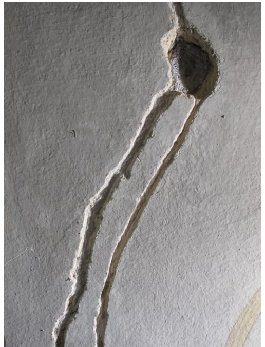
obr. 50: Stav po očištění v bočním nasvícení.
