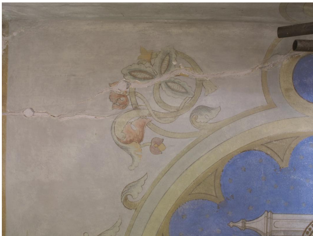
obr. 11: Pohled na pravou část iluzivního okna s rostlinným dekorem po očištění.
