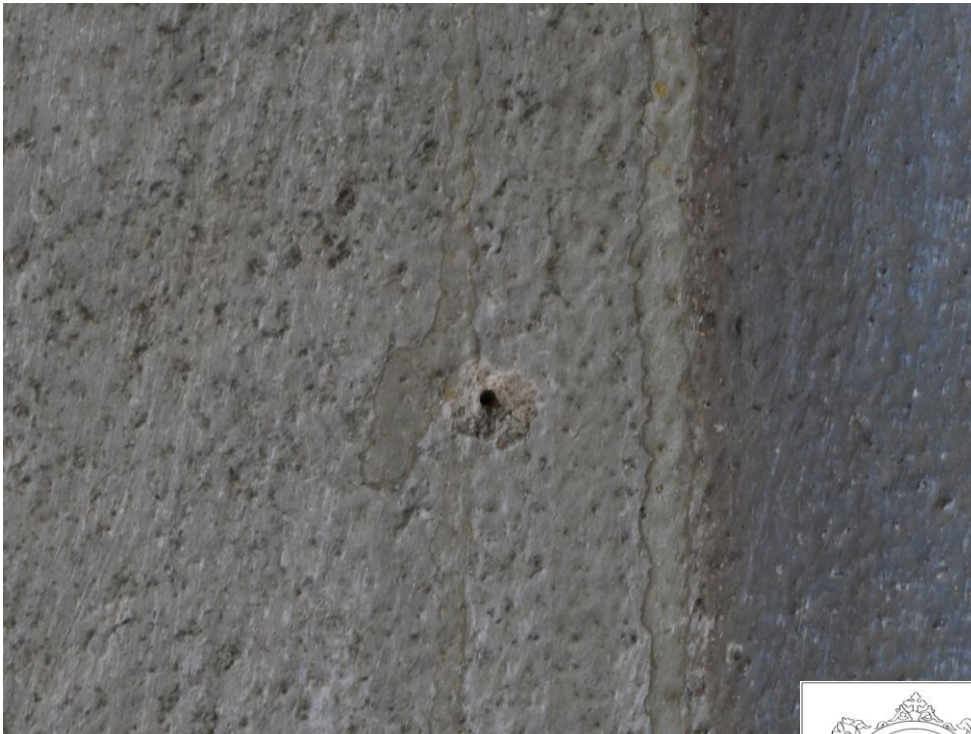
obr. 16: Na tomto snímku je zobrazen defekt po hřebíku, který sloužil, jako středový bod pro vytváření pomocné kružnice, podle které byl vytvořen oblouk iluzivního okna.
