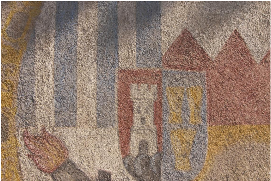
obr. 98: Detail zrestaurované nástěnné malby.
