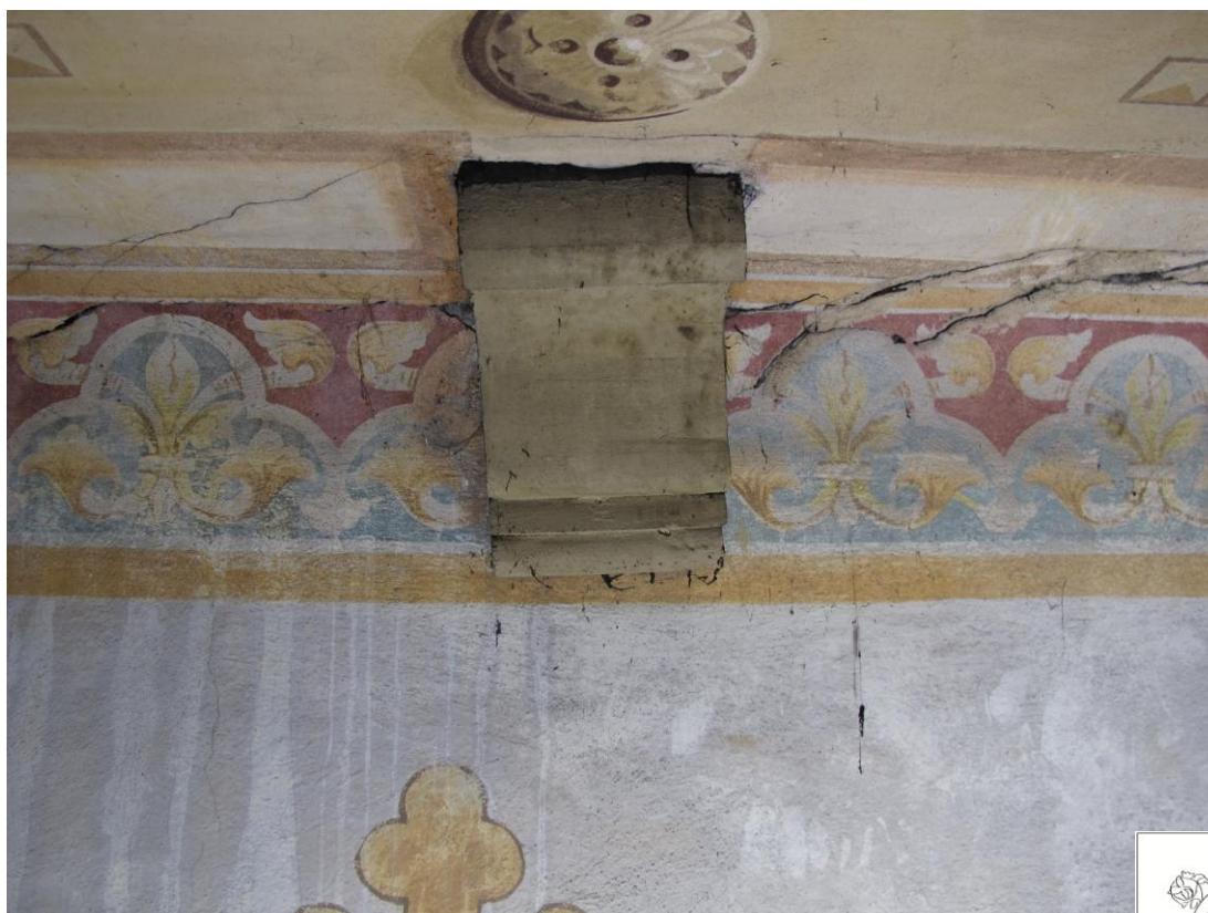
obr. 14: Pohled na dřevěnou konzoli pod stropem, po jejíchž stranách jsou patrné statické trhliny, kterými v některých místech zatékalo.
