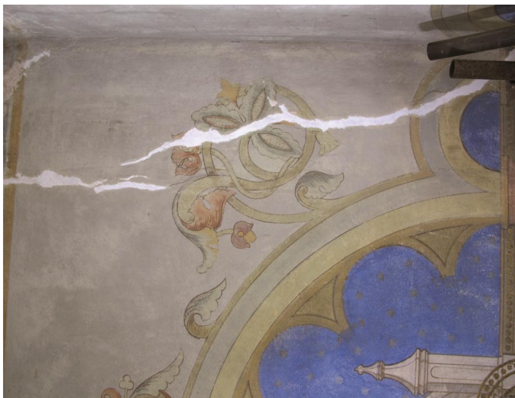
obr. 12: Pohled na pravou část iluzivního okna s rostlinným dekorem po vřtmelení.
