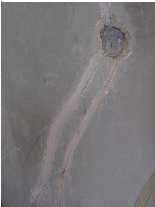
obr. 49: Stav po očištění.
