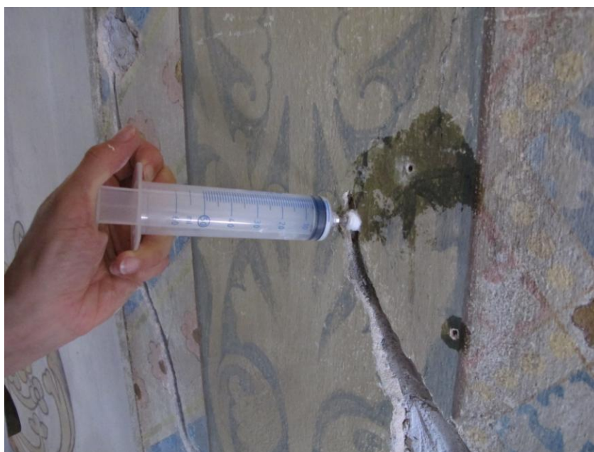
obr. 46: Injektáž dutin kolem statické trhliny.
