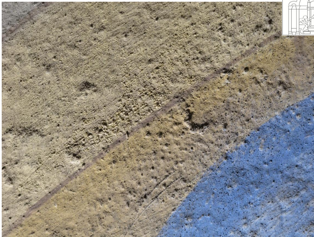
obr. 20: Pohled v bočním nasvícení, ve kterém jsou dobře viditelné šupinky uvolňující se barevné vrstvy, je také patrné její zpráškovatění a struktura povrchu omítky, na které je malba provedena.
