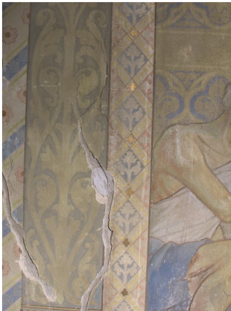
obr. 45: Na detailu malby je vidět otevřená statická trhлина vyplněná injektážní směsí, dále mechanická poškození – vrypy, opadaná barevná vrstva a místa po zatékání.
