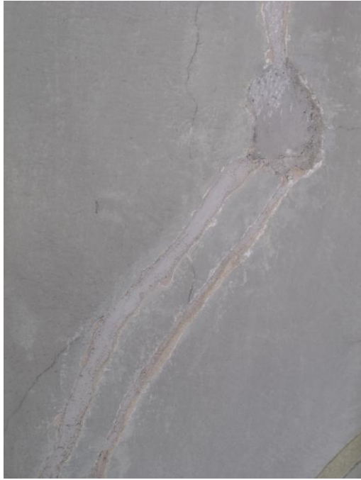
obr. 47: Detail se statickou trhlinou vyplněnou injektážní směsí.
