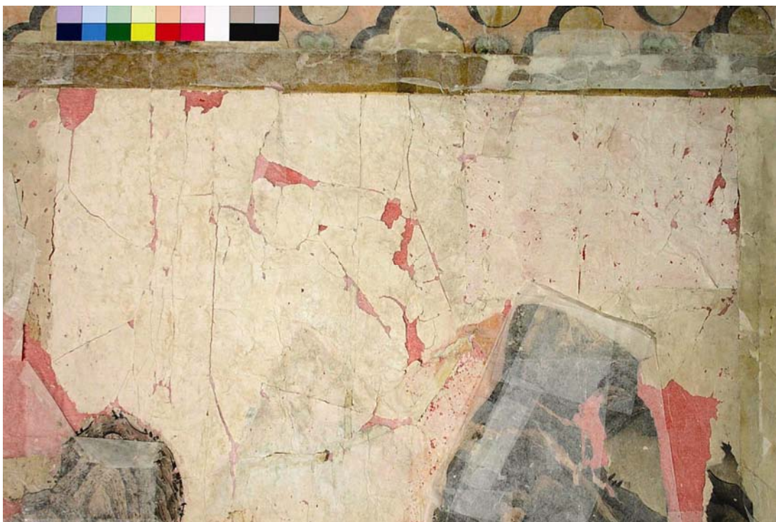
Obr. 19 Horní část tapety, líc, stav po odstranění doplňků (podloženo červeným papírem)
