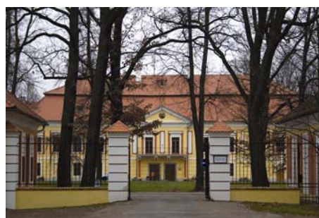
Obr. 6 Vstupní průčelí zámku
