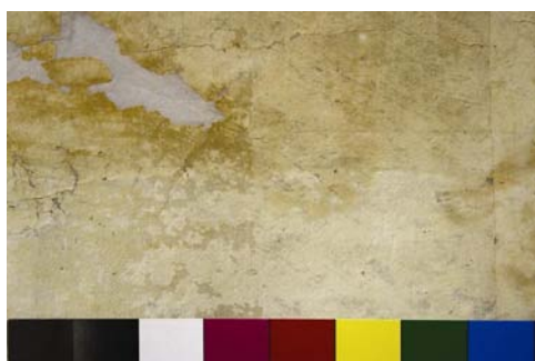
Obr. 51 Snímání podlepových vrstev – vlevo před, vpravo po očištění
