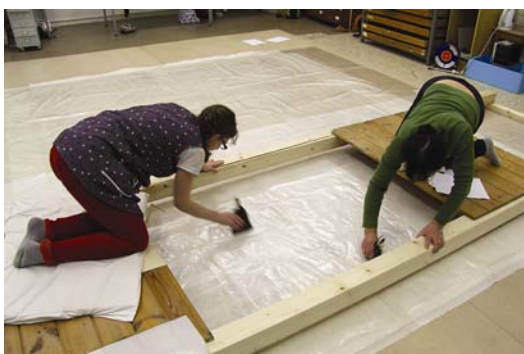
Obr. 65 Závěrečné přitupování první vrstvy přes fólii
