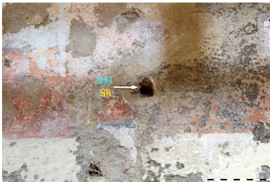
Obr. 7. Vz. S8 – středověká překrytá omítka. Vz. S11 – překryvná omítka, (výška odběru 213 cm).
