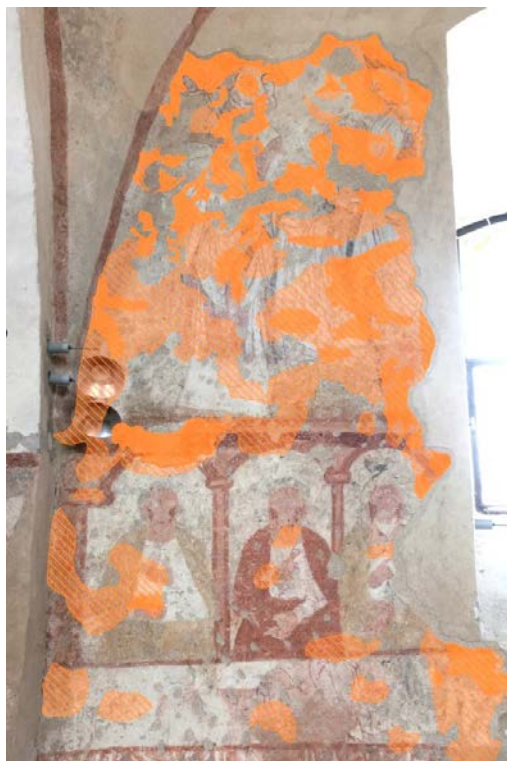
Obr. 55. Nástěnné malby určené k restaurování – grafický zakres pohyblivě uvolněných omítkových a nátěrových vrstev.
