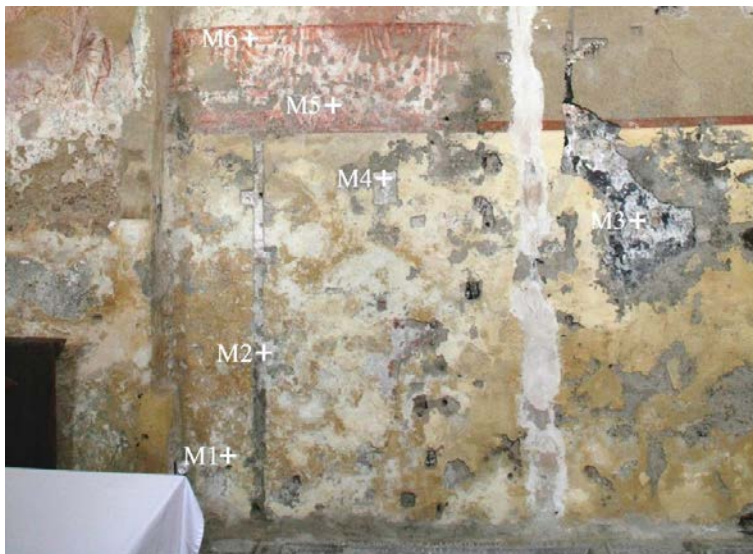
Obr. 37. Přízemní partie západní části severní stěny – grafický zákres míst odběrů vzorků pro zkoušky mikrobiologického napadení středověkých vrstev.
