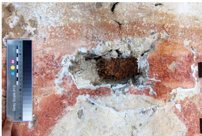
Obr. 36. Detail arkády – po odstranění nepůvodních vrstev a konsolidaci.
