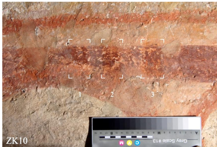
Obr. 104. ZK10 – zkouška čištění a ztenčení retuší a přemaleb, arkáda. Je patrné, jakým způsobem povrchové nečistoty v kombinaci s lazurními přemalbami zaslepily povrch malby a ztupily její barevnost. Barevnost a charakter vyčištěných míst odpovídají nepřemalované malbě nalezené ve fragmentech v rámci sondážního průzkumu.
