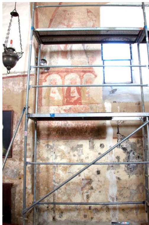
Obr. 20. Levá část severní stěny presbytáře – před restaurováním [srov. Obr. 19].
