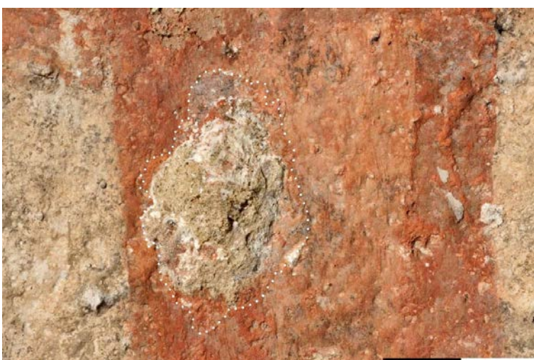
Obr. 83. Sonda pod tmel z r. 1956, arkáda – před restaurováním. V okolí odstraněného tmelu nebyly přemalby ani přesahující retuše provedeny.
