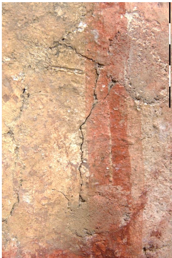
Obr. 38. Detail – před restaurováním. *
