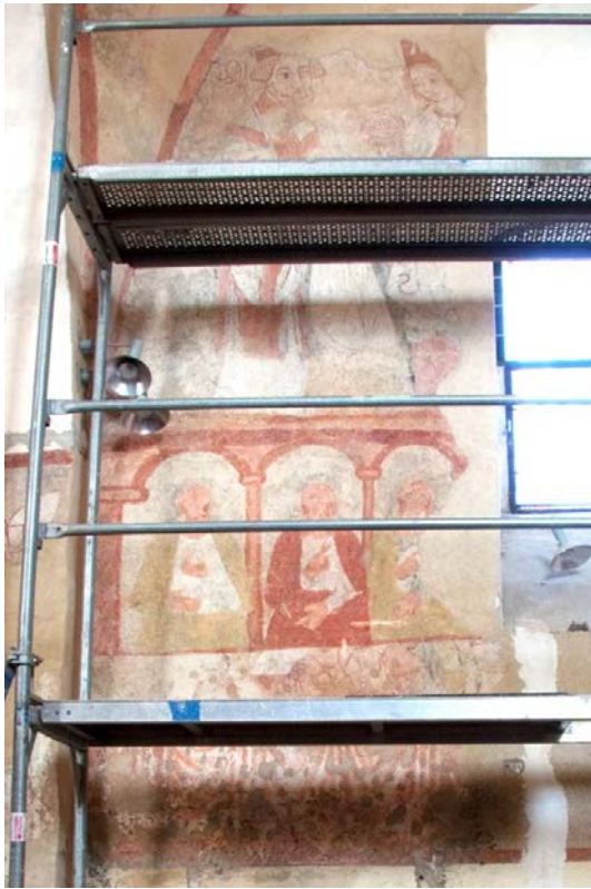
Obr. 139. Levá část severní stěny presbytáře – před restaurováním [srov. Obr. 140.].
