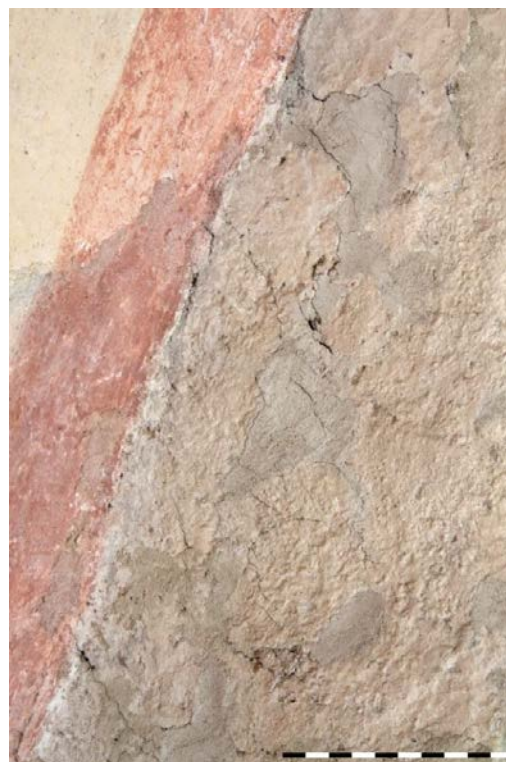
Obr. 54. Detail pozadí za sv. biskupem – před restaurováním. Destruované a uvolněné jsou nejen středověké vrstvy, ale také novodobé tmely.
