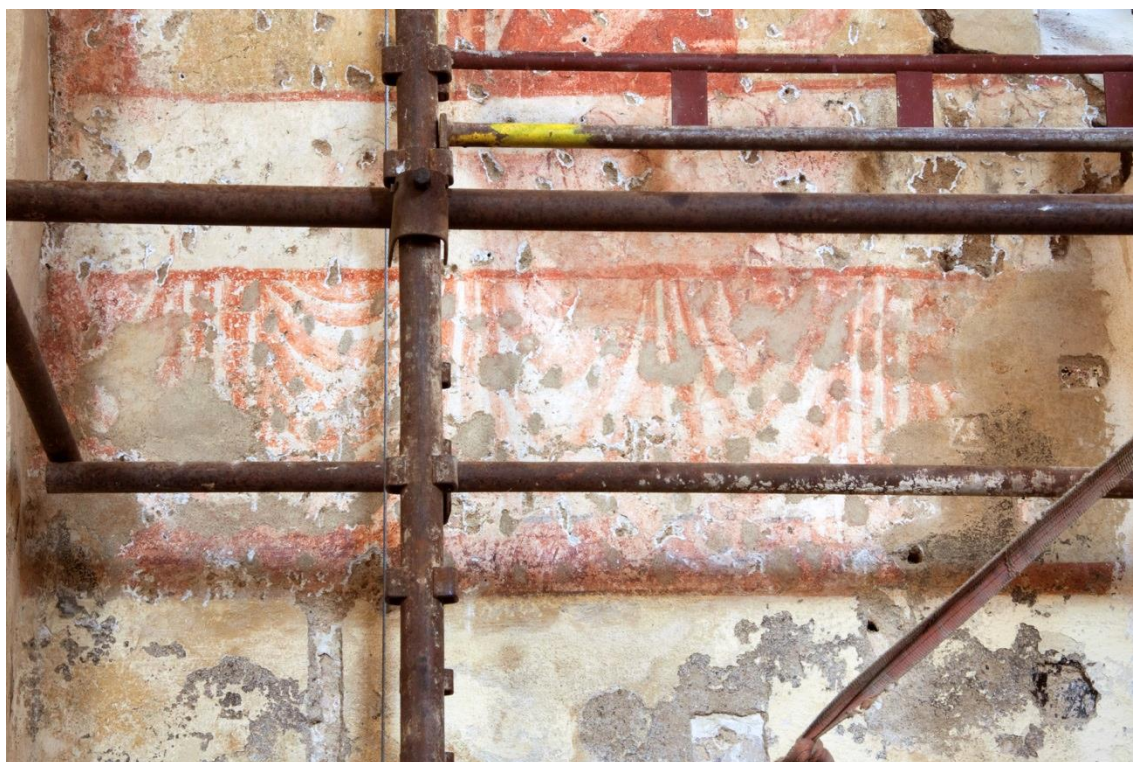
Obr. 55. Stůl se splývavou draperií. Partie stolu jsou ve stavu po odstranění nepůvodních vrstev a konsolidaci. Splývavá draperie stolu je ve stavu po preventivní konsolidaci havarijních míst.
