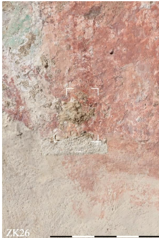
Obr. 125. ZK26 – zkouška hloubkové konsolidace vápenných nátěrů s barevnou vrstvou, šat sv. biskupa.
