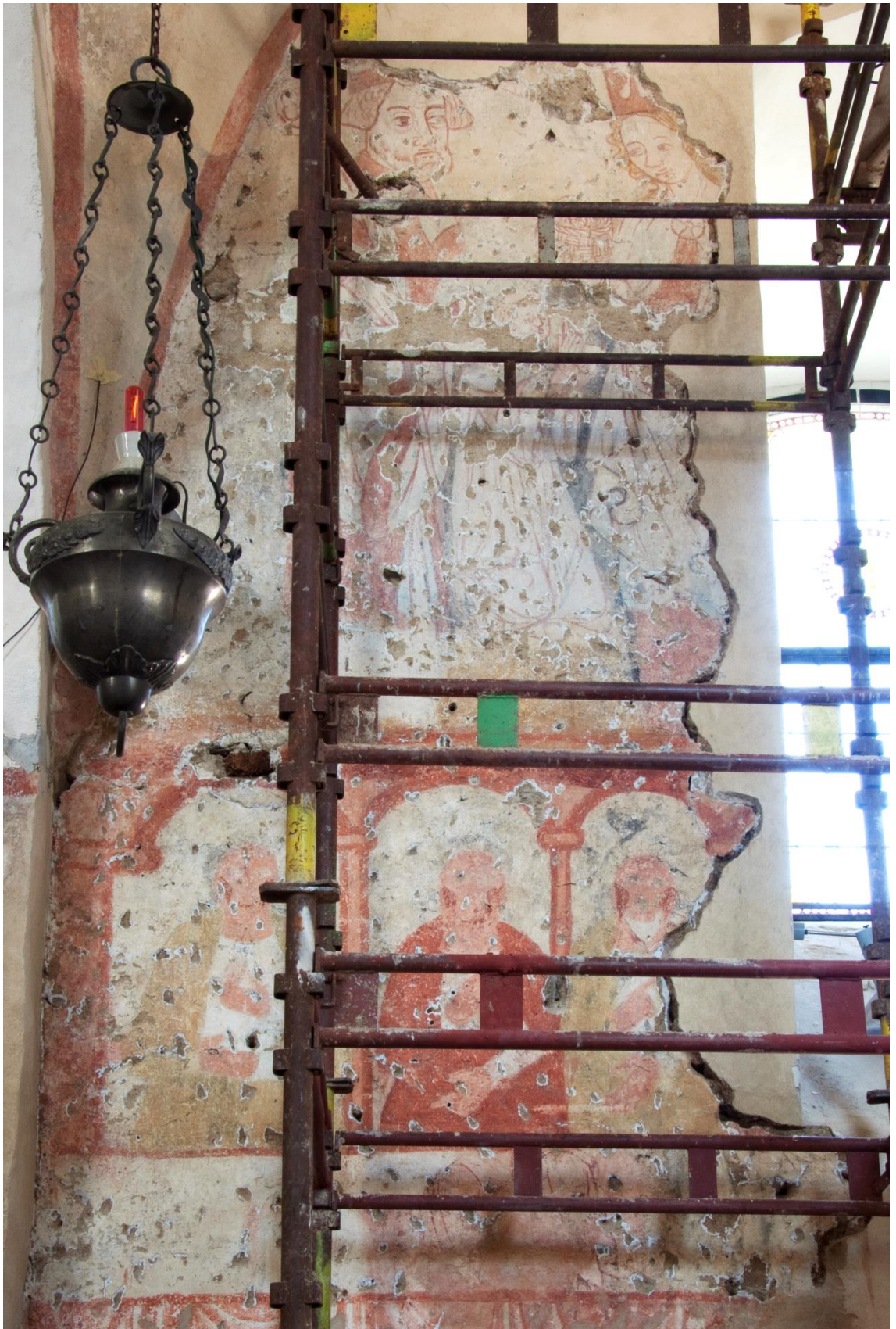
Obr. 3. Nástěnné malby určené k samostatnému restaurování – po odstranění nepůvodních vrstev a konsolidaci.
