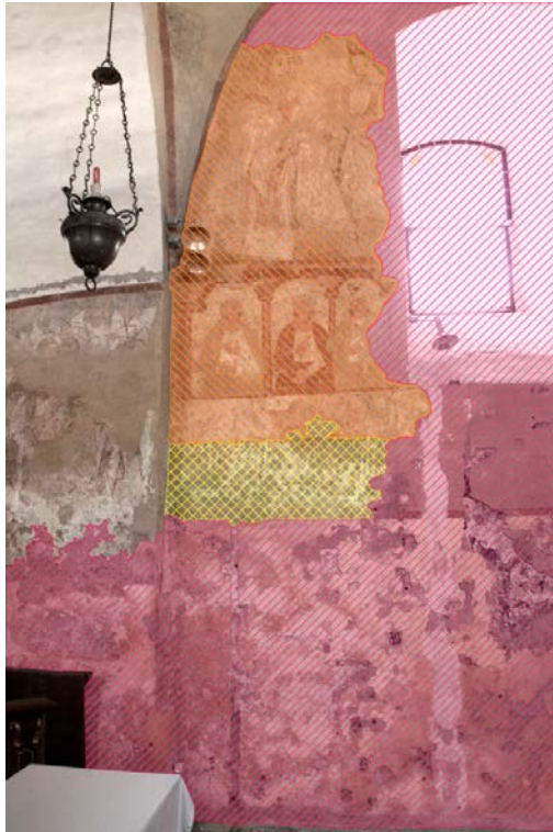
Obr. 2. Levá část severní stěny – grafický zákres vymezení úseku k samostatnému průzkumu a restaurování.
