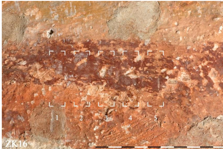
Obr. 113. ZK16 – zkouška povrchové konsolidace barevné vrstvy, arkáda.
