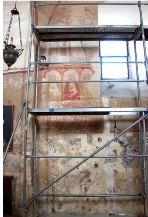
Obr. 3. Levá část severní stěny presbytáře – před restaurováním [srov. Obr. 2].
