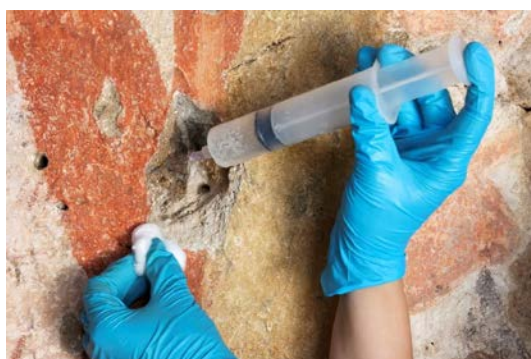
Obr. 143. Detail rozhraní prostřední a pravé polofigury – v průběhu strukturální konsolidace odhalených nesoudržných omítek po odstranění tmelů.
