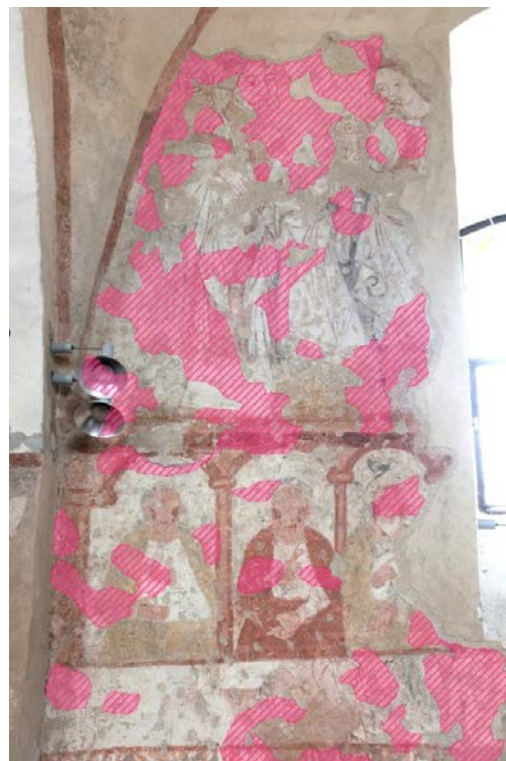
Obr. 56. Nástěnné malby určené k restaurování – grafický zakres dutin pod omítkou. Omítkové vrstvy jsou pohyblivé pouze v síti prasklin.
