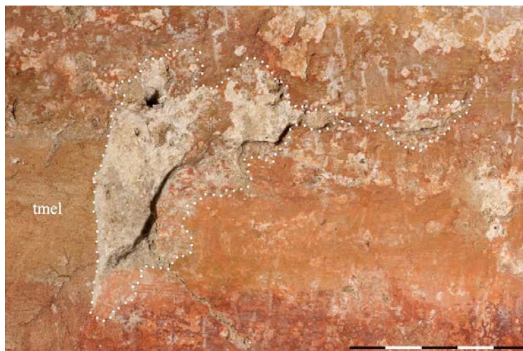
Obr. 86. Sonda pod tmel z r. 1956, arkáda – před restaurováním. Nalezená barevná vrstva je narušená a oslabená. Přesahující retuše jsou hutnější, přemalby spíše lazurní. Obojí mírně ztmavlé.
