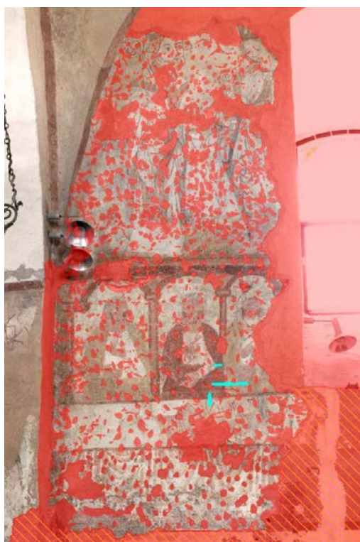
Obr. 62. Nástěnné malby na západní polovině severní stěny – grafický zakres novodobých vrstev a zásahů v partiích nástěnných maleb.
