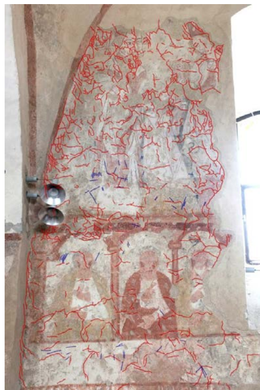
Obr. 57. Nástěnné malby určené k restaurování – grafický zakres prasklin a silnějších vrypů.
