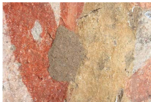
Obr. 147. Detail rozhraní prostřední a pravé polofigury – v průběhu tmelení. Postup tmelení svrchní finální vrstvy tmelu. Maltovina byla nanášena výškově nad úroveň povrchu malby a po mírném vyschnutí byla stržena.
