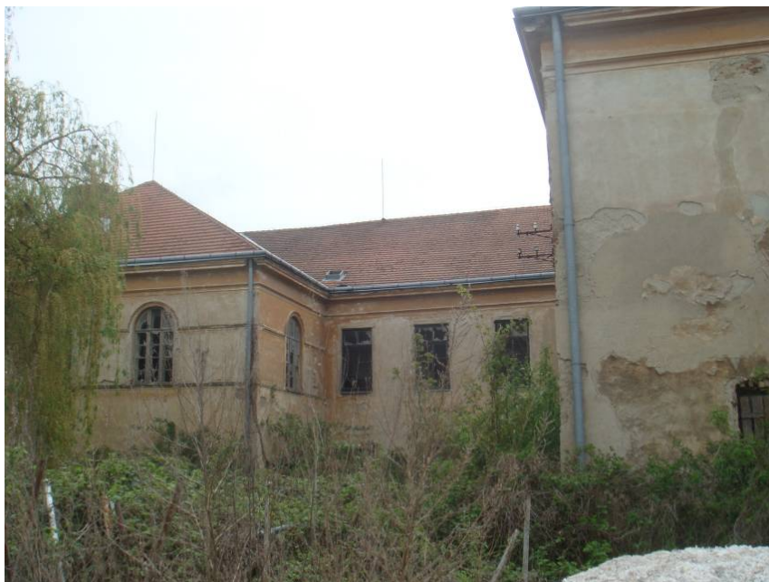
Obr.6/III Současný stav, pohled od severu (foto aut.)
