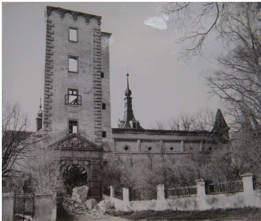
Obr. 4/IV Polozřícená vstupní věž (foto dle SHP, 1974)
