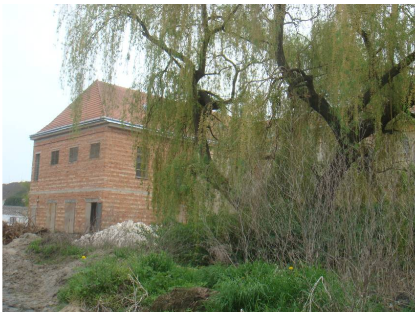
Obr.6/IV Současný stav, přístavba zříceného křídla, trafostanice (foto aut.)
