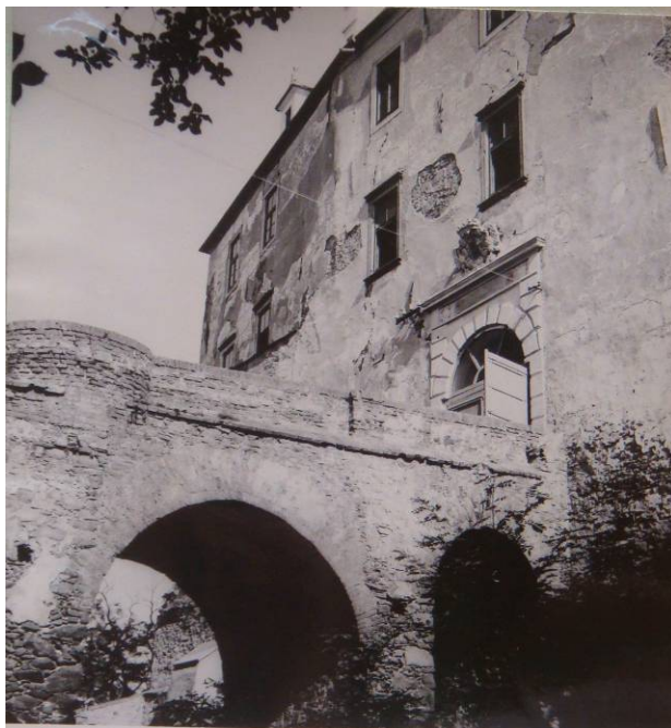
Obr.2/IV Východní strana zámku před opravou (foto dle SHP, 1966)
