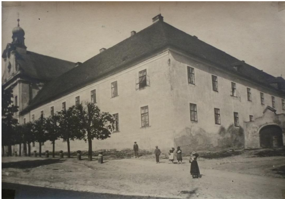
Obr. 7a: Původní stav jihozápadního nároží budovy kláštera (přelom 19. a 20 století)
