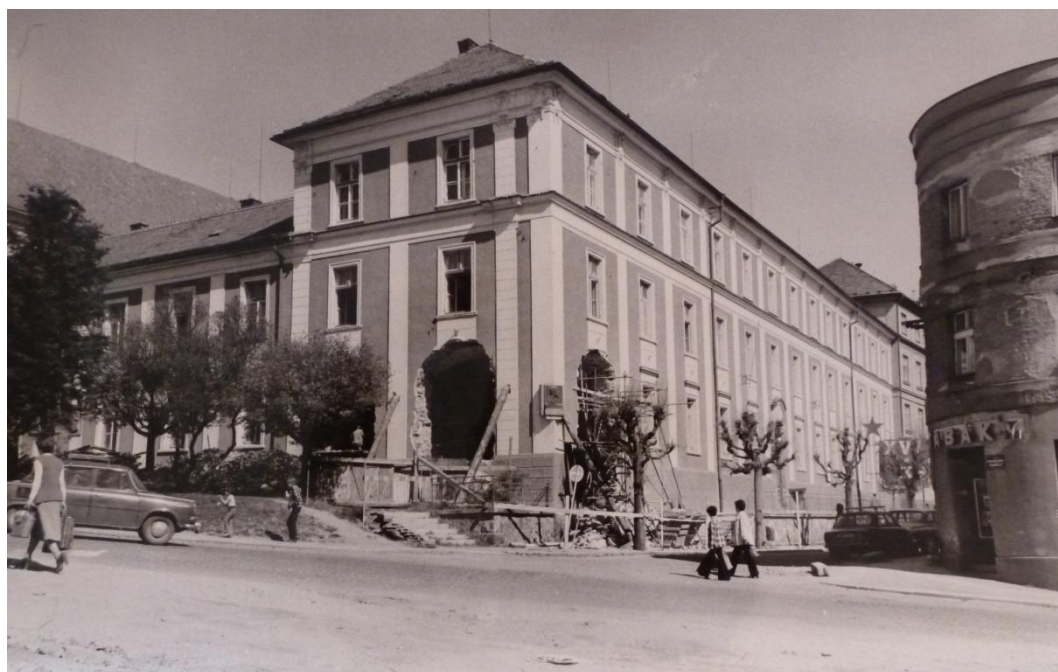
Obr. 7b: Výstavba nového vchodu do budovy kláštera
