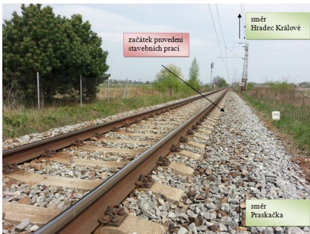
Obrázek 13: Trať k provedení stavebních prací
