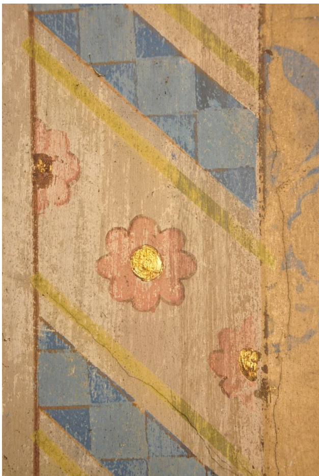
Obr. 46 Detail odpadané barevné vrstvy na levém bočním sloupu.
