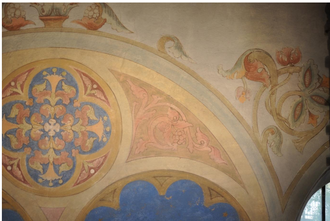
Obr. 75 Pravá část horního oblouku, stav po restaurování.
