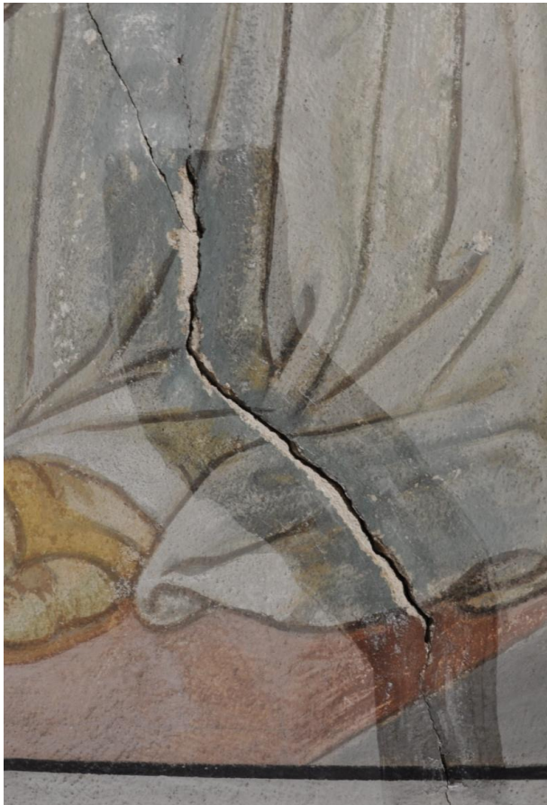
Obr. 53 Průběh prací, detail nanesené vrstvy cyklododekanu při okrajích trhliny v drapérii sv. Josefa.
