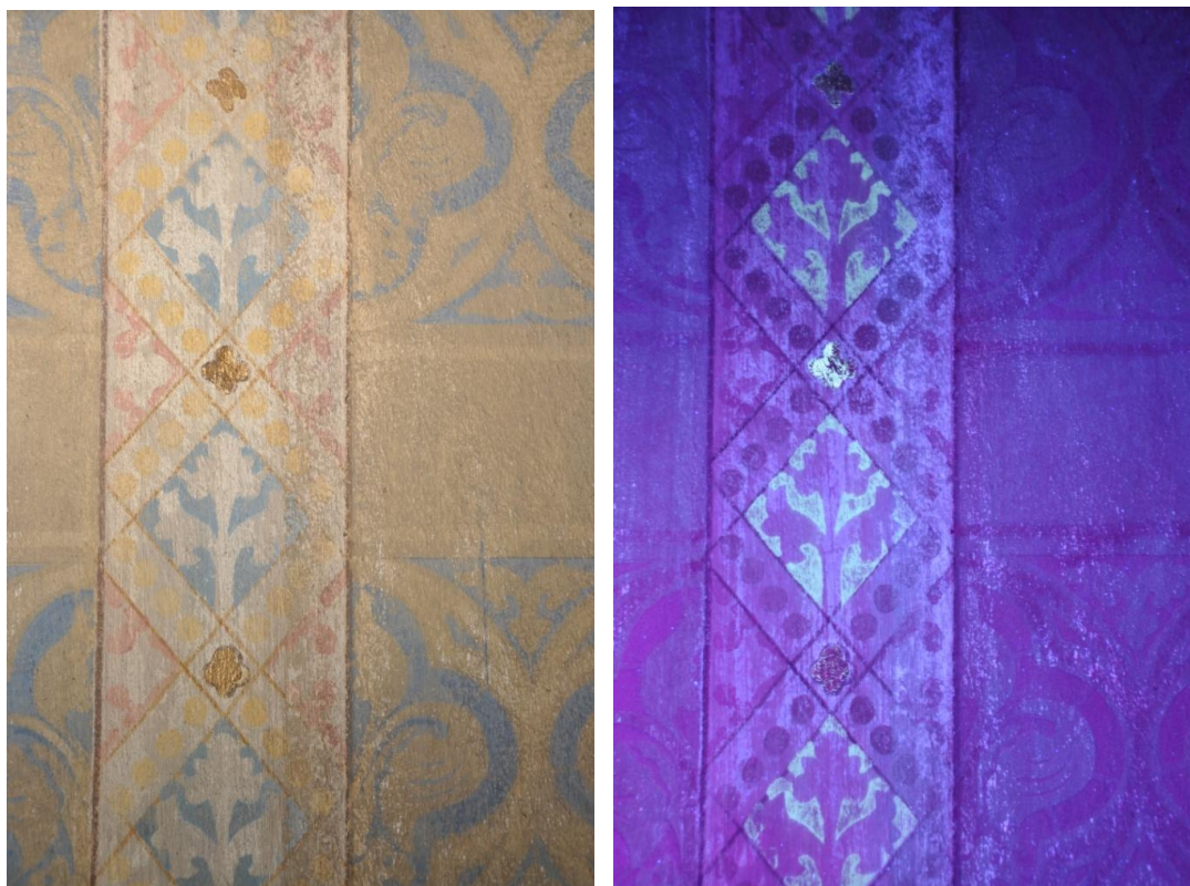
Obr. 24, 25 Část šablonového dekoru středového sloupu a pozadí, při nasvícení denním a Uv světlem.
