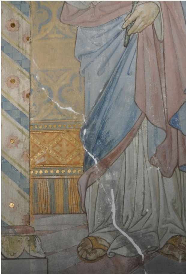
Obr. 57 Zatmelená trhlina v drapérii sv. Josefa.
