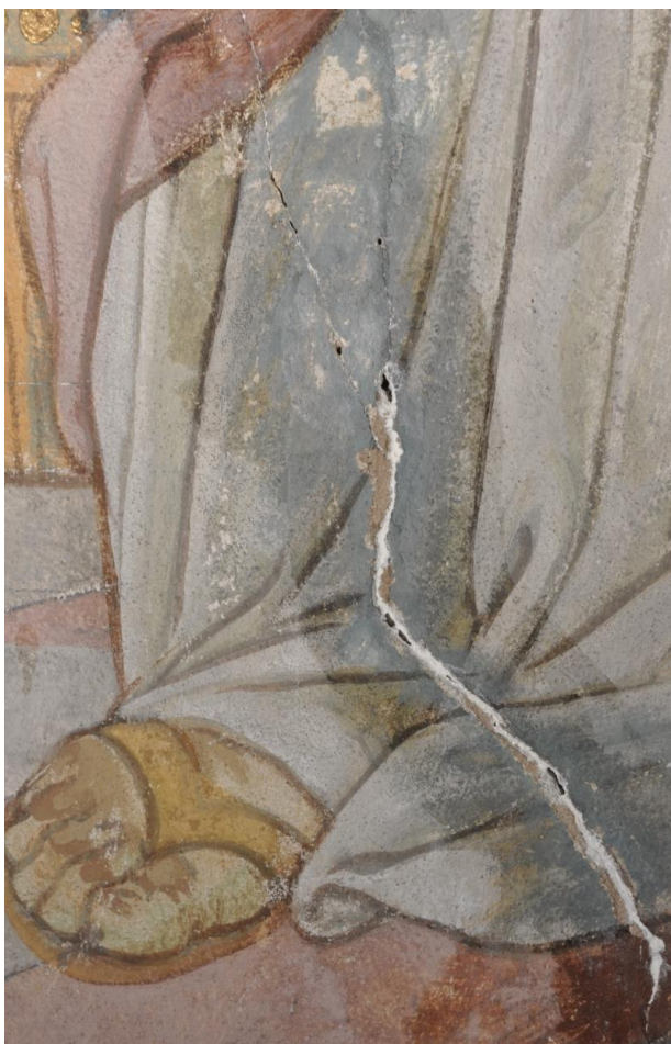
Obr. 55 Stav po zaplnění dutin a trhliny konsolidačním prostředkem Ledan B1.
