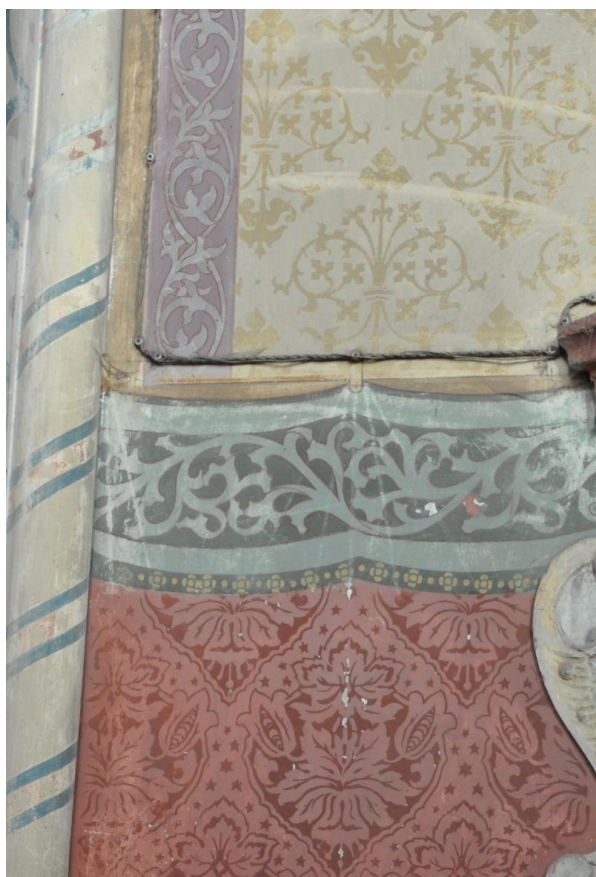
Obr. 20 Ornamentální šablonová výmalba presbytáře, vlevo část přípory ozdobené modrými pásky, spodní část šablonová malba zdobící iluzivní závěs, nahoře šablonový dekor pokrývající ostatní plochu (tataáž šablona byla použita v kostele sv. Bartoloměje v Kolíně).
