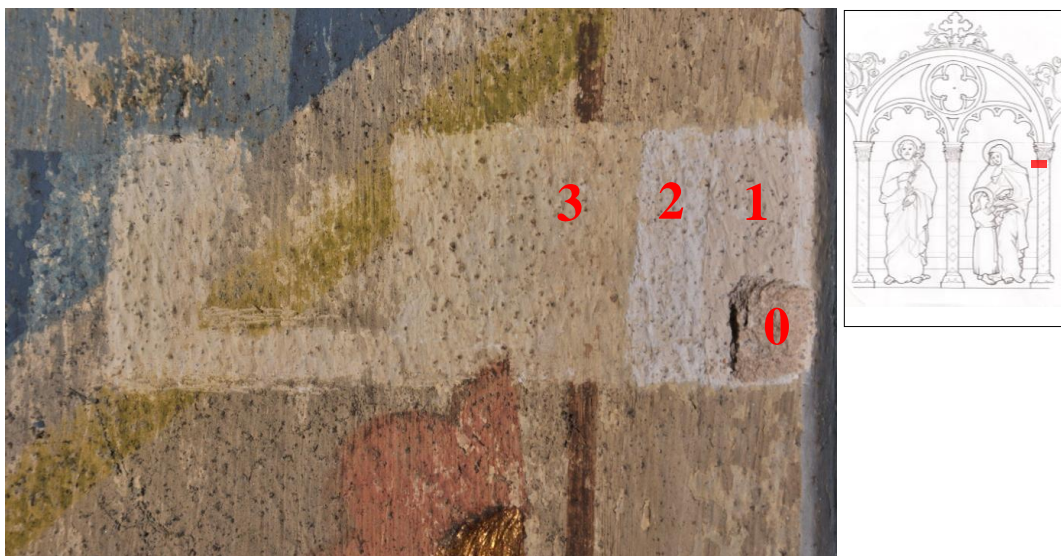
Obr. 27 Detail sondy S1: 0 – omítka, 1 – béžový podkladový vápenný nátěr, 2 – bílý vápenný nátěr, 3 – povrchový světle okrový nátěr.
