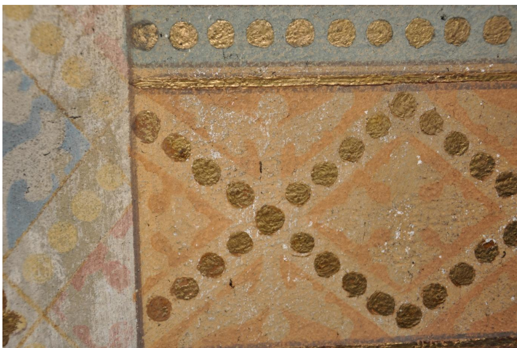
Obr. 45 Detail šablonového dekoru zdobeného plátkovým zlatem, místy odpadáním od organického podkladového nátěru.
