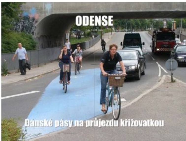
Obrázek č. 21: Křížení cyklopiktokoridoru s hlavní silnicí v Odense
