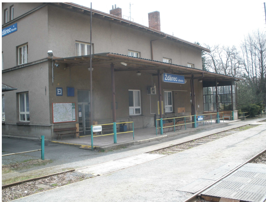
Obrázek č. 17 Výpravní budova
