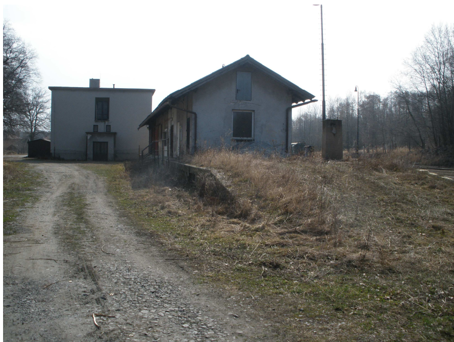
Obrázek č. 19 Nájezd na čelní rampu se skladištěm
