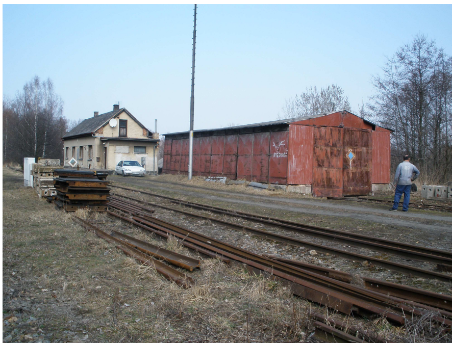
Obrázek č. 21 Garáž a drážní domek
