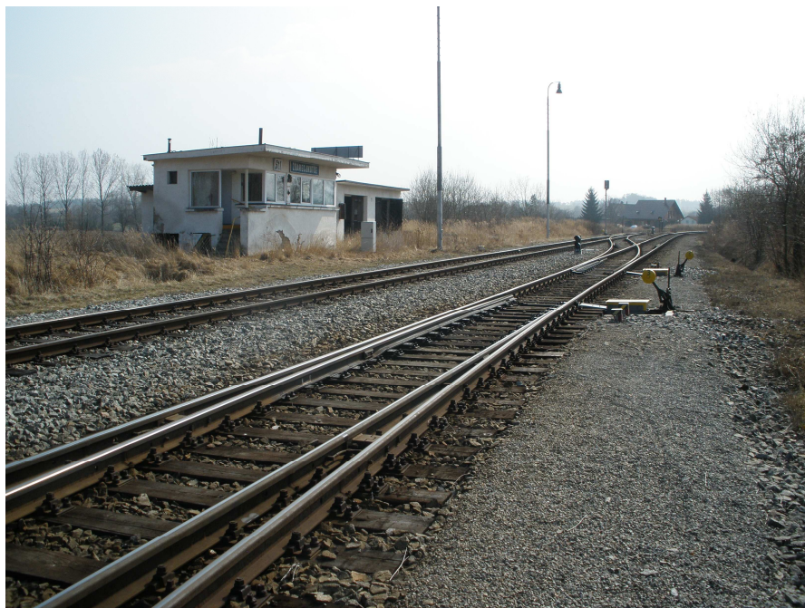
Obrázek č. 9 Hláska u Havlíčkobrodského zhlaví
