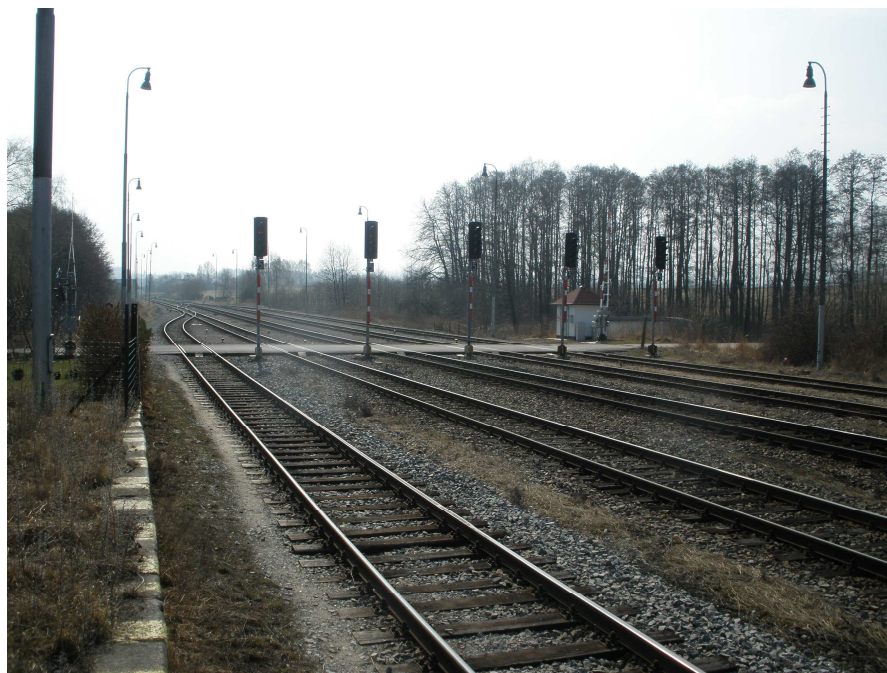
Obrázek č. 11 Železniční přejezd v Km 54, 862
