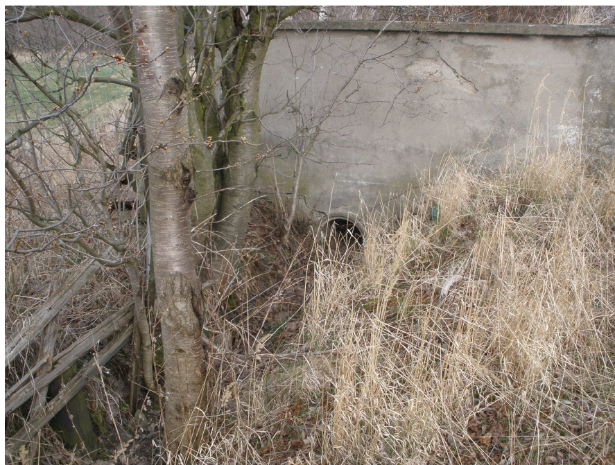
Obrázek č. 12 Propustek v Km 54, 836
