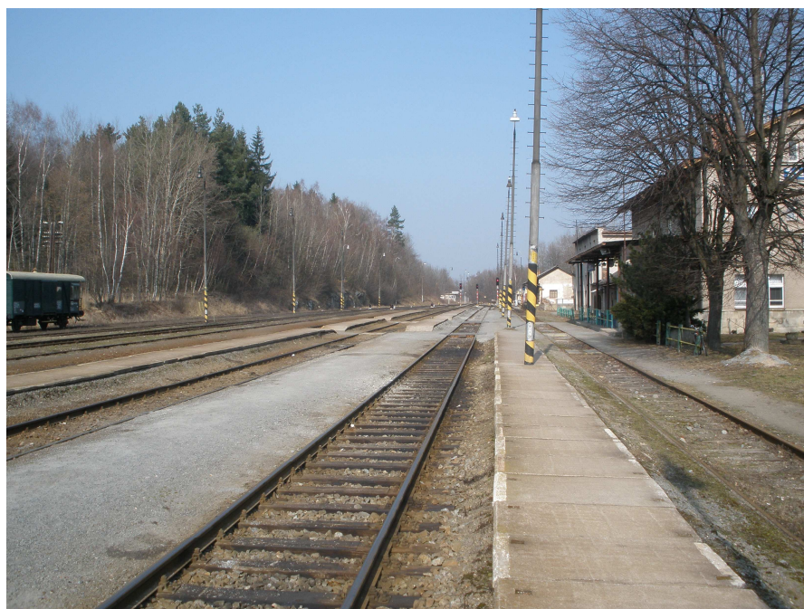
Obrázek č. 16 Pohled na jednotlivá nástupiště
