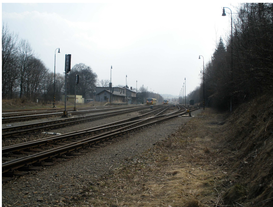
Obrázek č. 22 Železniční doprava ve stanici
