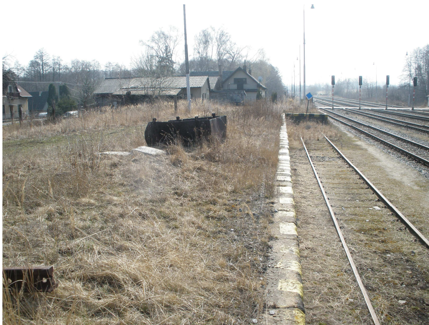
Obrázek č. 13 Boční a čelní rampa
