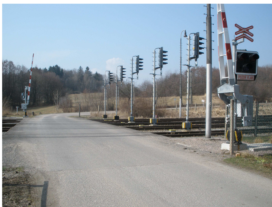
Obrázek č. 10 Železniční přejezd v Km 54, 862
