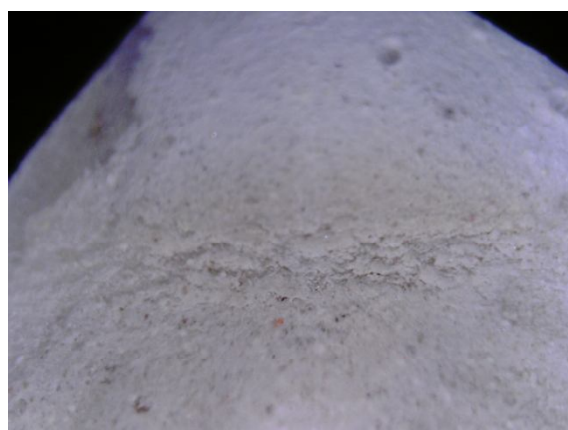
Detail poškození po umělém stárnutí v místě lomu
