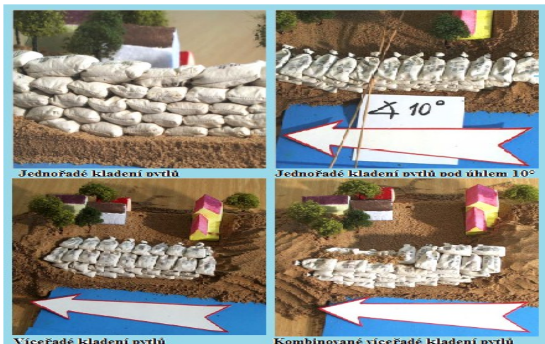
Obrázek 3 Stavba protipovodňových hrází pomocí pytlů s pískem
