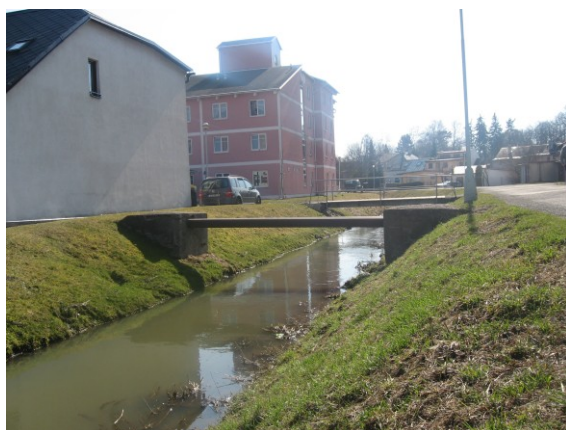
Obrázek 6 Nevhodně řešené křížení sítě s tokem
