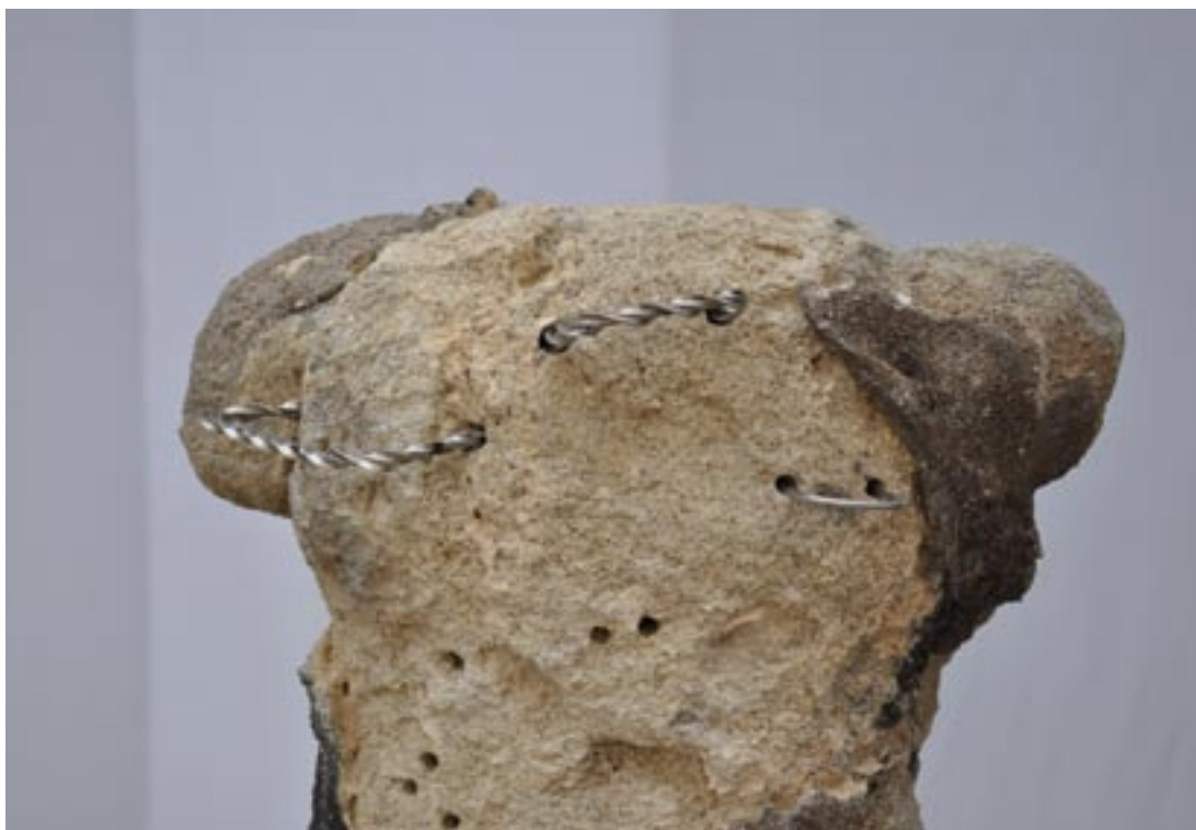
Obr. 81. Váza pravá- průběh prací- nerezové armatury- hlavice
