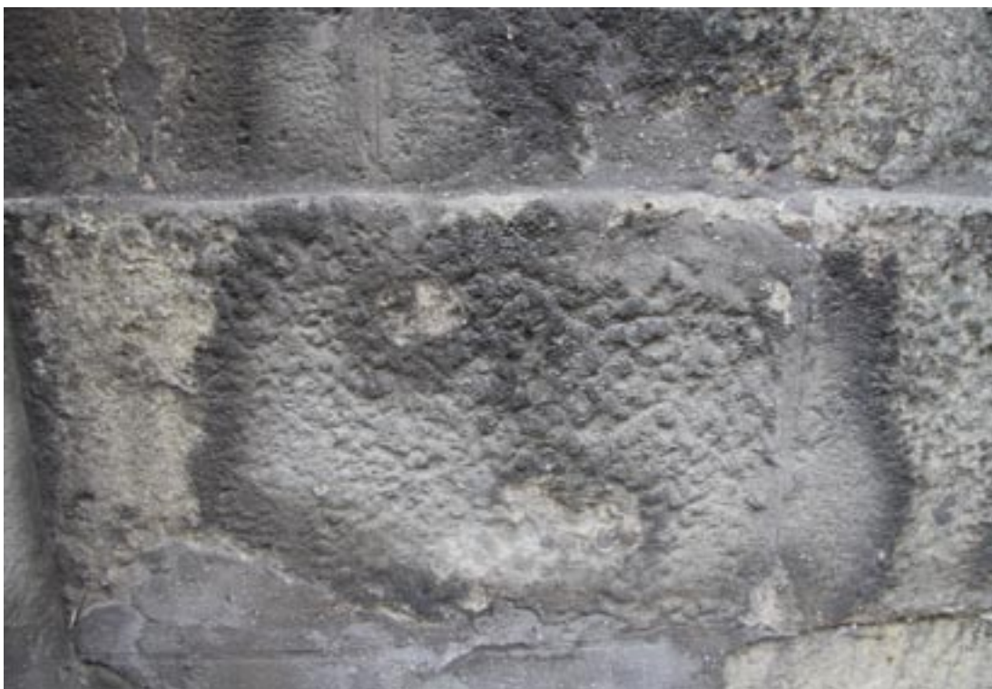
Obr. 106. Sokl- levá strana- detaily starých plastických vysprávek, černých krust a nečistot
