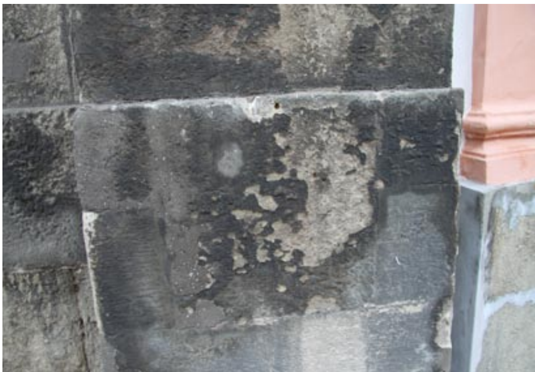
Obr. 104. Sokl- pravá strana- detaily starých plastických vysprávek, černých krust a nečistot
