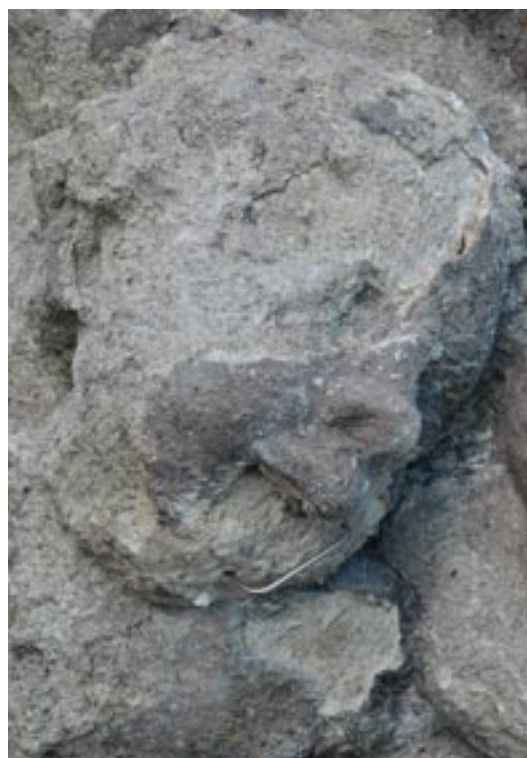
Obr. 36. Sv. Jan Nepomucký- detail hlavy andílka- průběh prací- nerezové armatury
