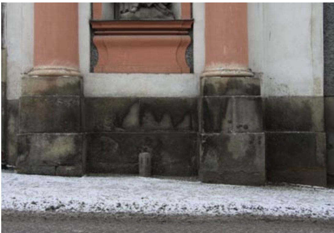
Obr. 98. Sokl kostela- levá strana
