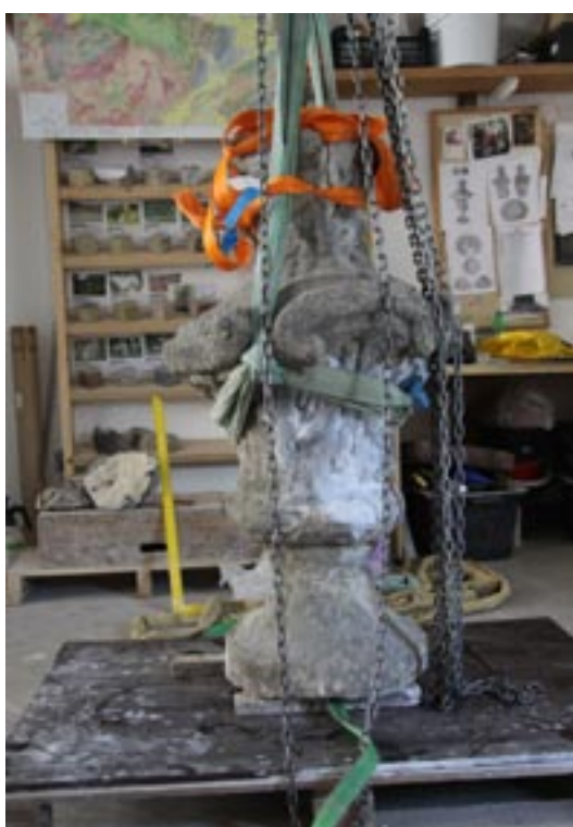
Obr. 61. Váza pravá- průběh prací- lepení- bílý zákal od zpevňovacího prostředku Calosil
