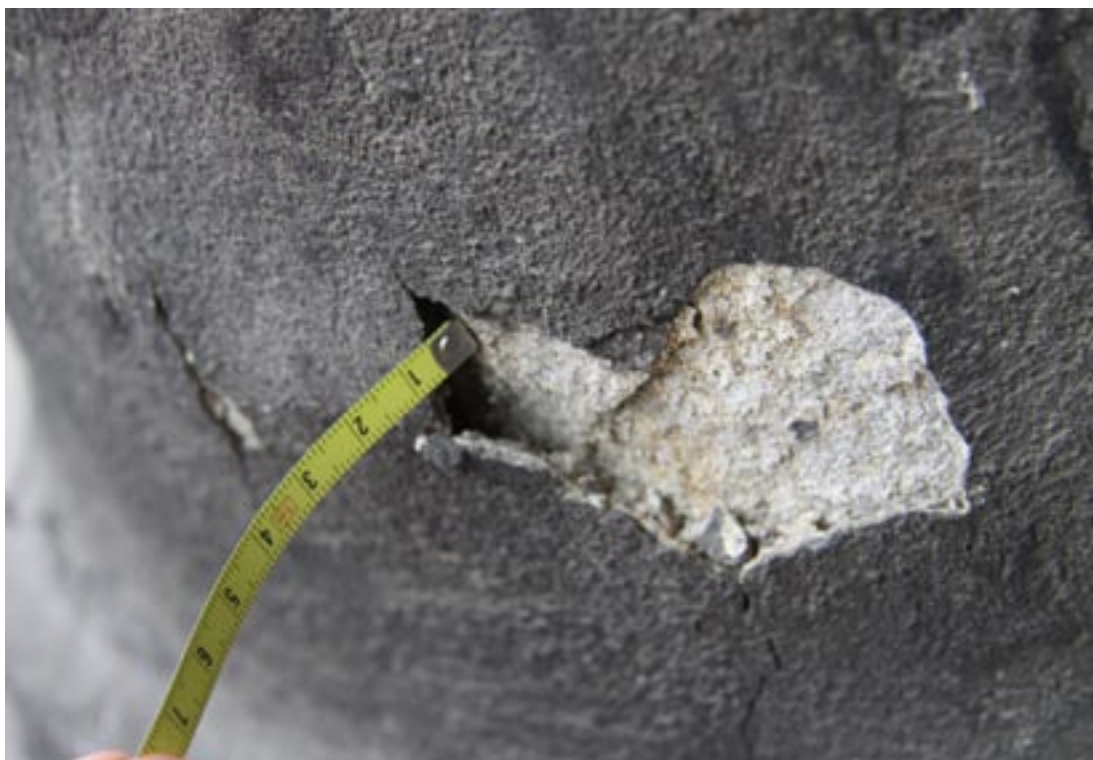
Obr. 108. Detail černých krust nesoudržných s podkladem
