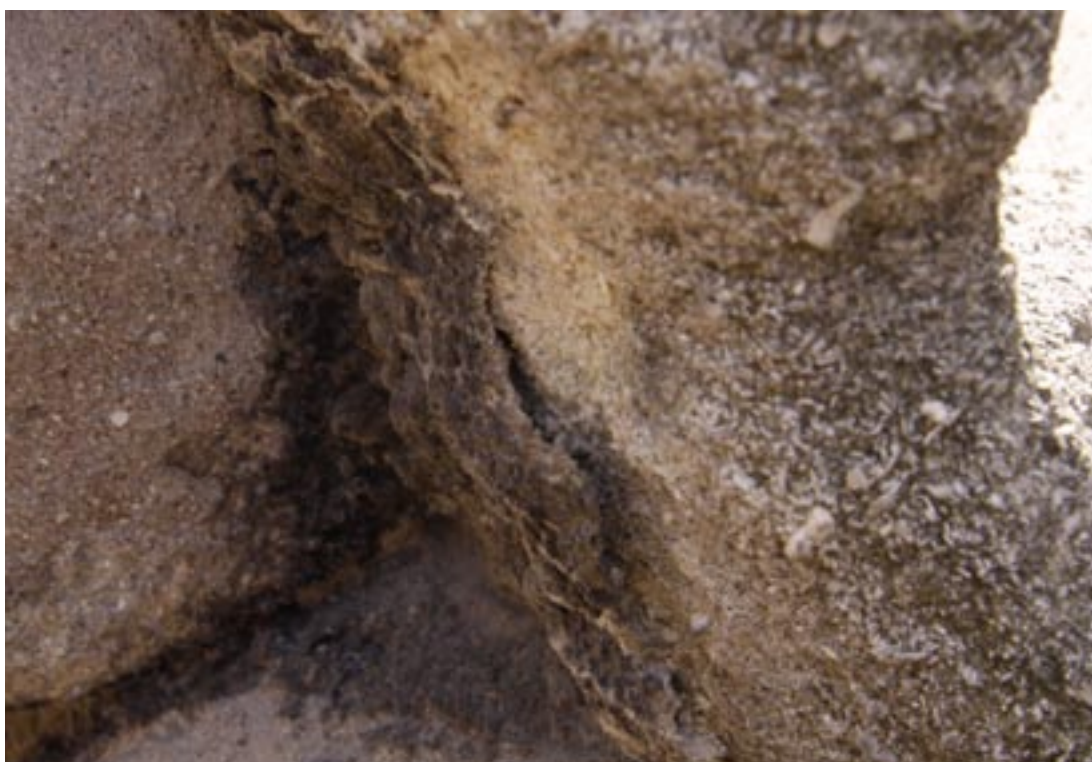
Obr. 59. Váza pravá- detail silně zdegradovaného partu- před restaurováním
