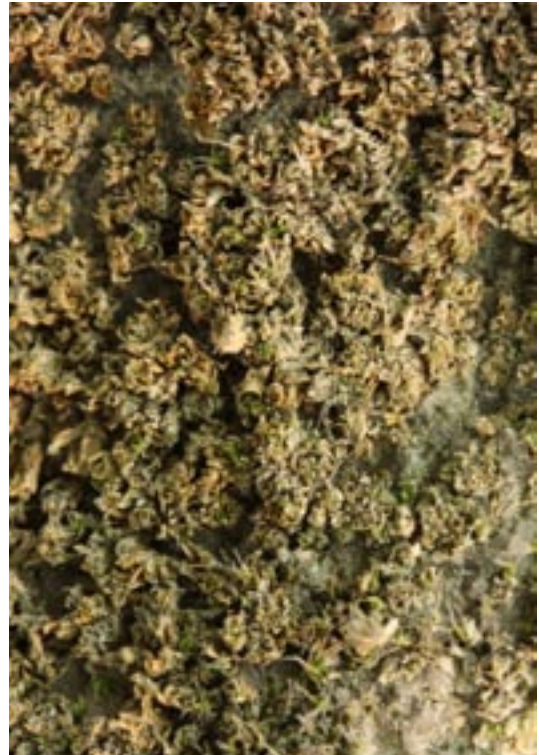
Obr. 8. Detail biologického napadení
