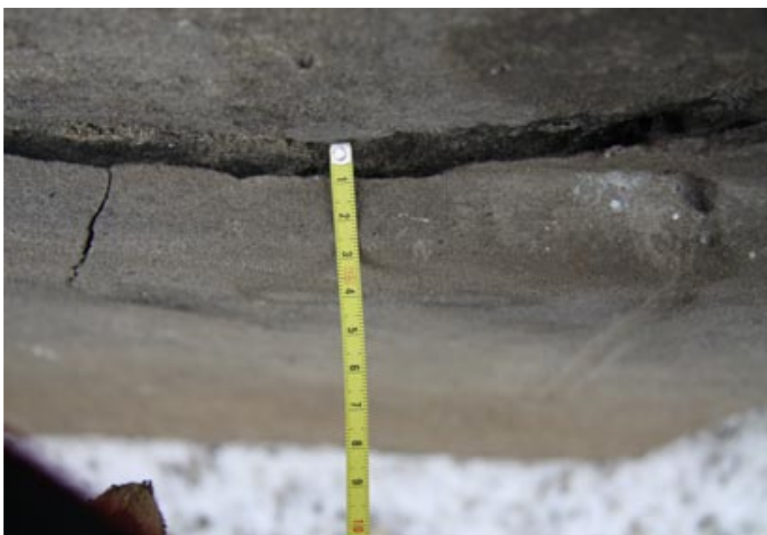
Obr. 109. Detail staré nesoudržné plastické vysrávky
