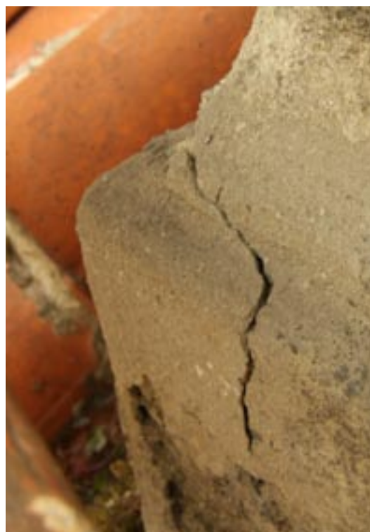
Obr. 51. Andílek levý- před restaurováním- detail parskliny tmelu- přední pohled
