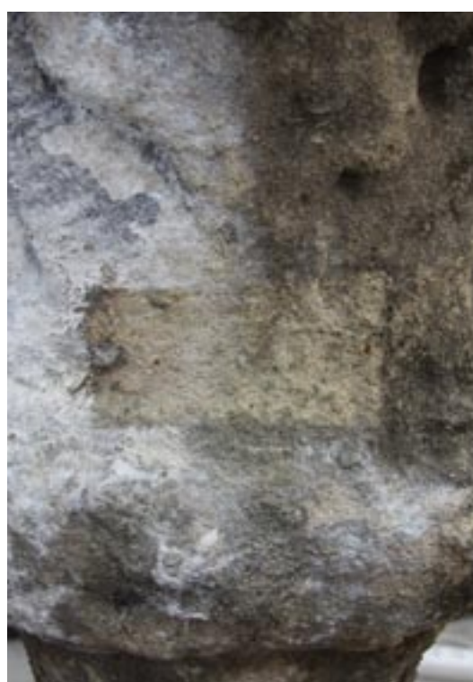
Obr. 62. Váza pravá- průběh prací- bílý zákal od zpevňovacího prostředku Calosil- zkouška čištění parním čištěm
