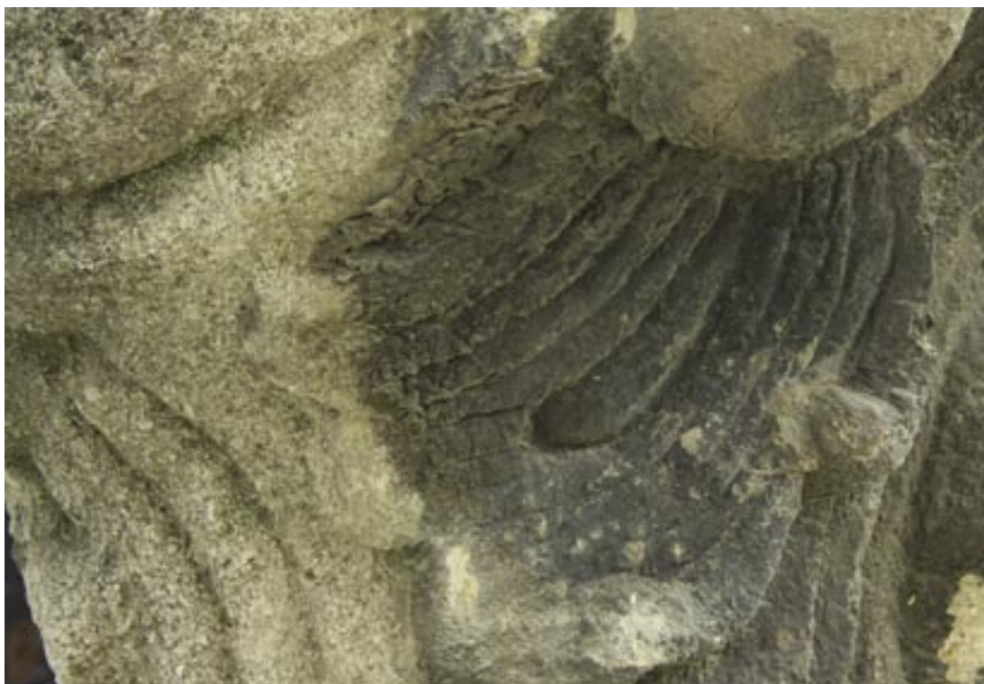
Obr. 92. Váza levá- před restaurováním- detail černé krusty
