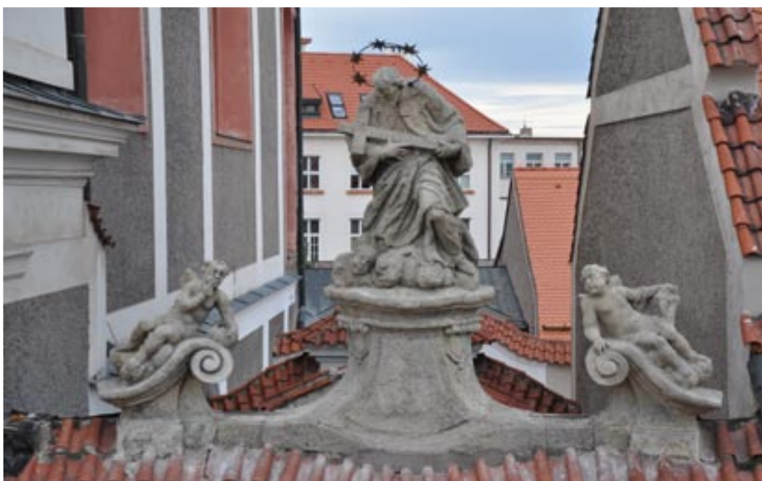
Obr. 3. Sochařská výzdoba boční brány kostela sv. Jana Nepomuckého- po restaurování- čelní pohled- foceno z protějšího domu
