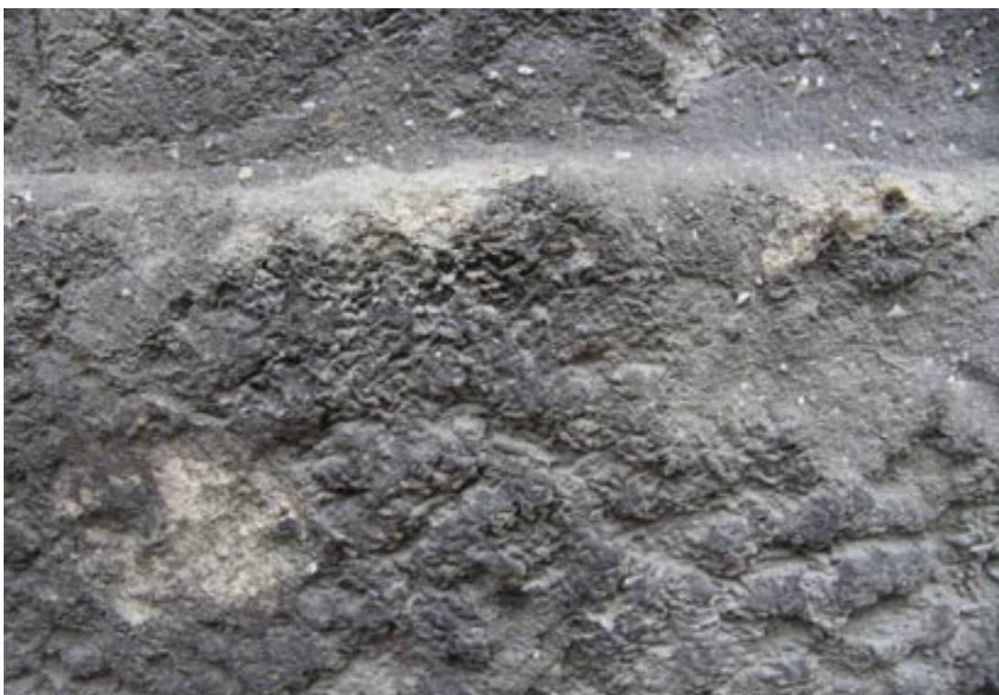
Obr. 105. Sokl- levá strana- detaily starých plastických vysprávek, černých krust a nečistot
