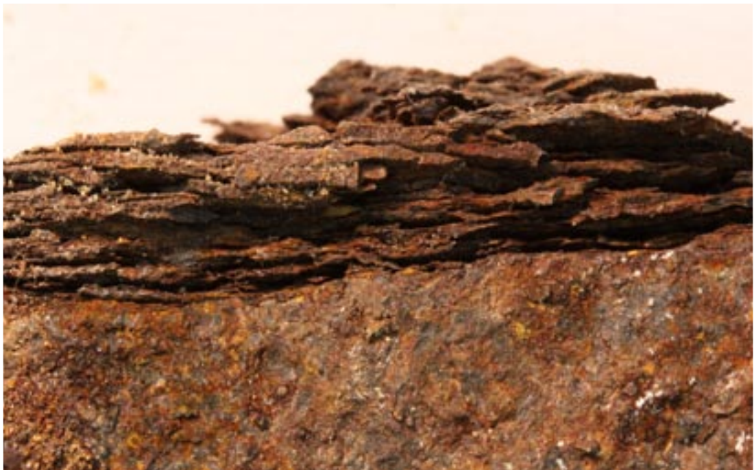
Obr. 9. Detail zkorodovaného železného čepu
