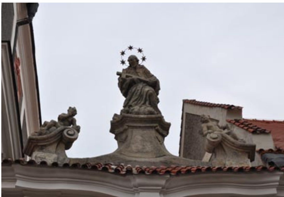
Obr. 11. Sochařská výzdoba boční brány- stav po restaurování- pohled z ulice
