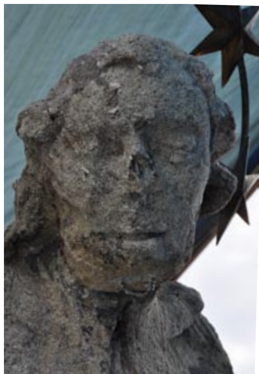
Obr. 28. Sv. Jan Nepomucký- průběh prací- nerezové armatury- detail hlavy- čelní pohled
