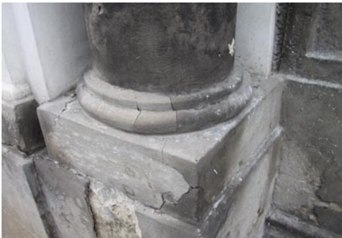
Obr. 110. Detaily starých nesoudržných plastických vysprávek, černých krust a nečistot na patce sloupu
