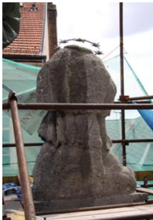
Obr. 16. Sv. Jan Nepomucký- průběh čištění(mikrotryskání)- zadní pohled
