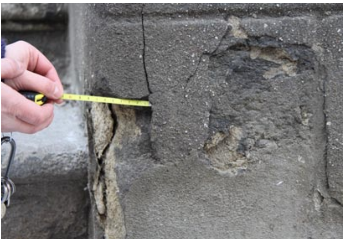
Obr. 107. Sokl- pravá strana- detaily starých nesoudržných plastických vysprávek, černých krust a nečistot
