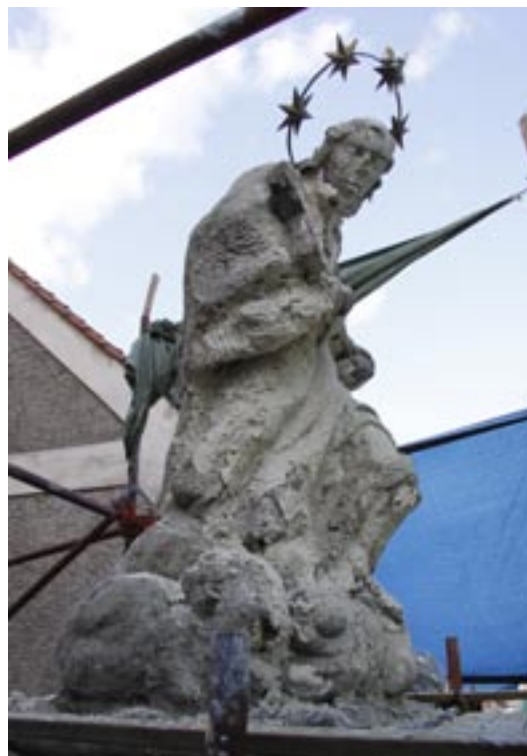
Obr. 20. Sv. Jan Nepomucký- průběh čištění(čistící zábal)- boční pohled
