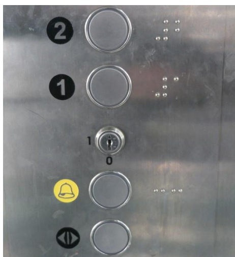
Obrázek 10: Ovládání výtahu s využitím Braillova písma
