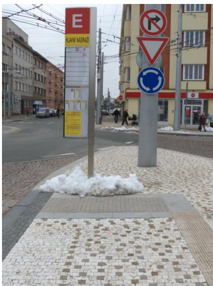
Obrázek 13: Na vodící linii navazuje signální pás, nástupiště E
