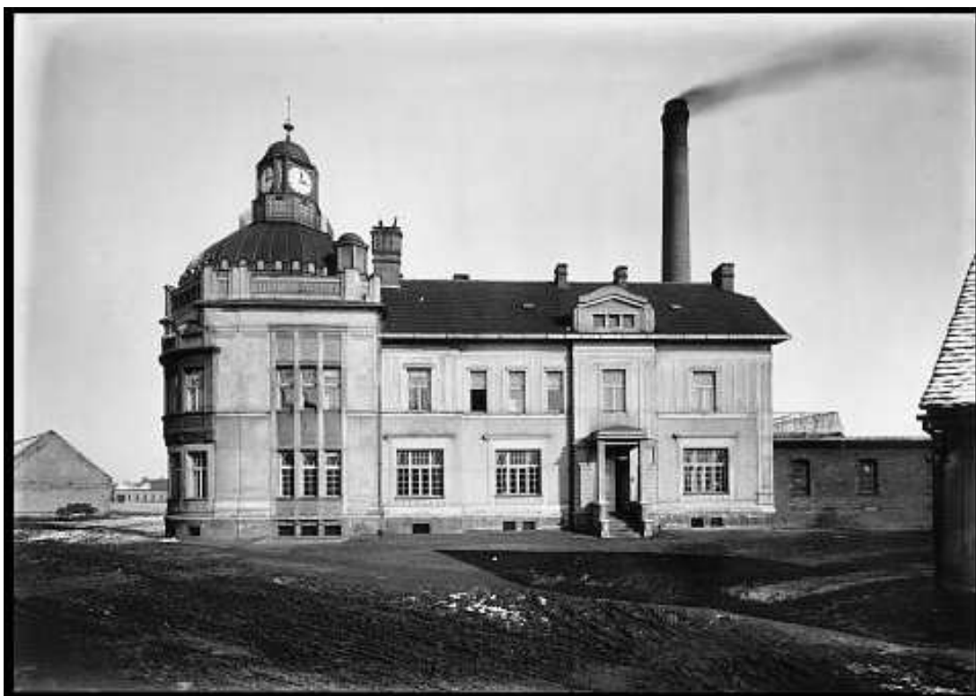
10. MĚSTSKÁ ELEKTRÁRNA NA KARLOVINĚ
