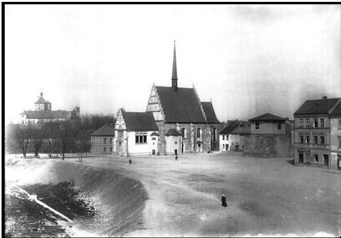
9. KOSTEL SV. BARTOLOMĚJE PO PŘESTAVBĚ V ROCE 1912, VLEVO „MĚSTSKÁ ŘEKA“ TĚSNĚ PŘED VYSUŠENÍM
