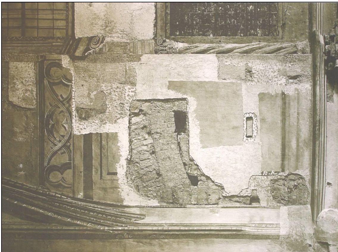
Obr. 39. Vladislavský sál, sondážní odkryv barevných a omítkových vrstev na zdivo, severovýchodní kout, foto J. Štenc 1924-1926, reprofoto autor
