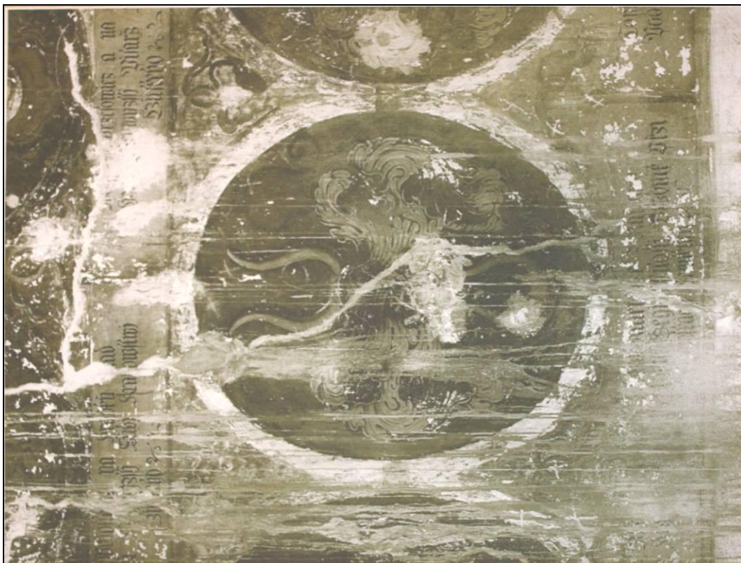
Obr. 25. Sál desek zemských po zajištění a poškození maleb cementovým mlékem V. Kalibou roku 1925, detail foto J. Štenc 1925, reprofoto autor
