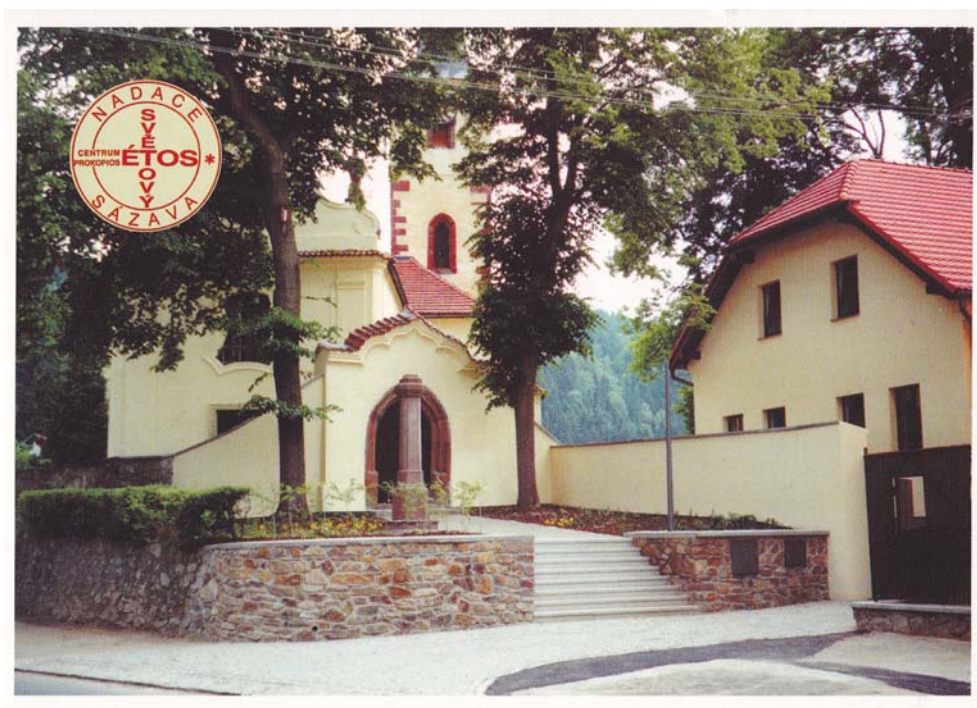
Příloha č. 4 Sídlo Nadace Světový Étos – Centrum Prokopios
