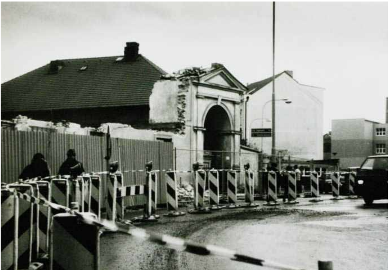
12. Demolice zástavby sousedící s kaplí (domy č.p. 292 a 433), únor 2009 (foto J. Procházka, SOkA Kutná Hora)
