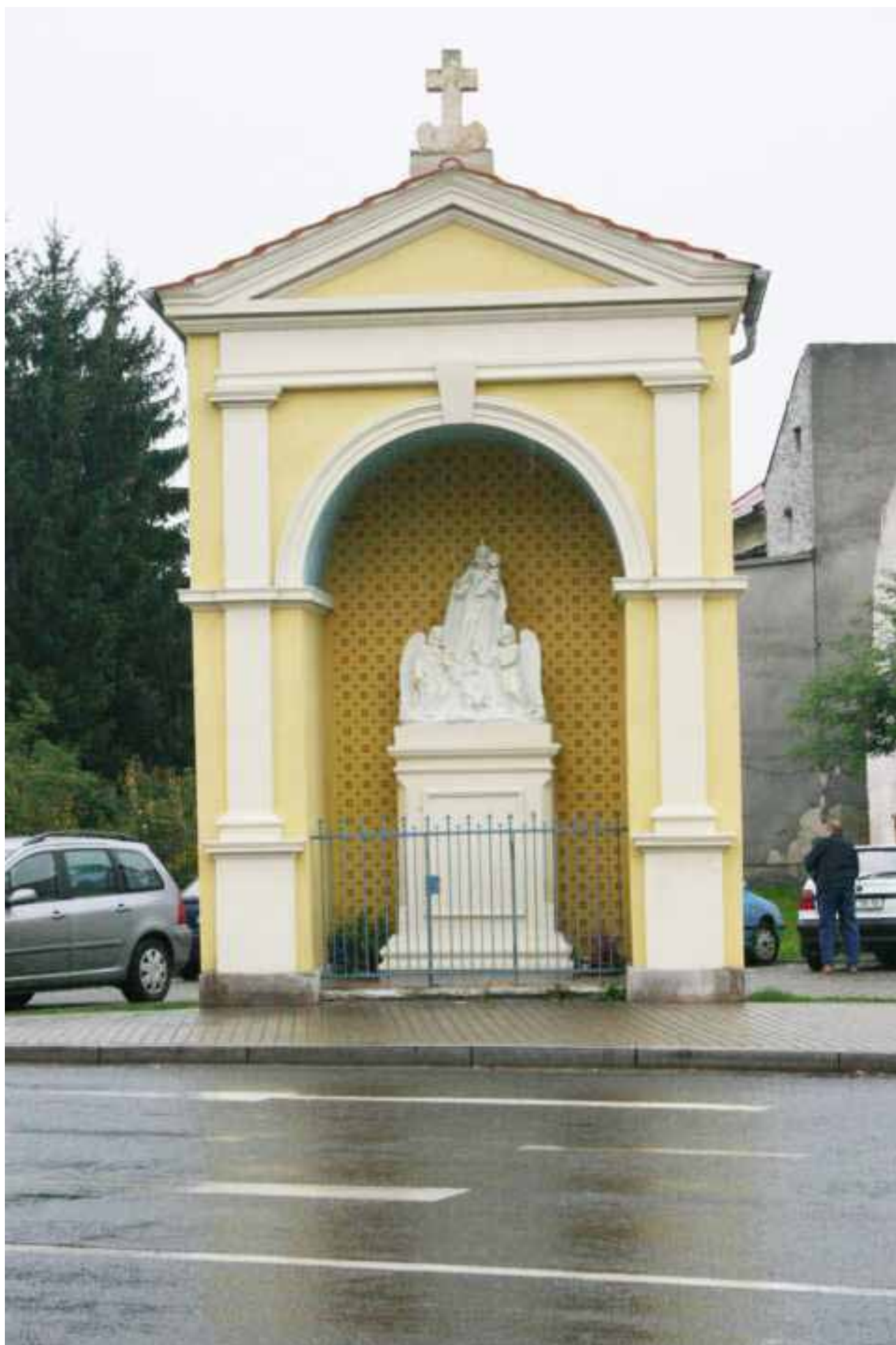
66. Kaple ve Vocelově ulici, celkový pohled
