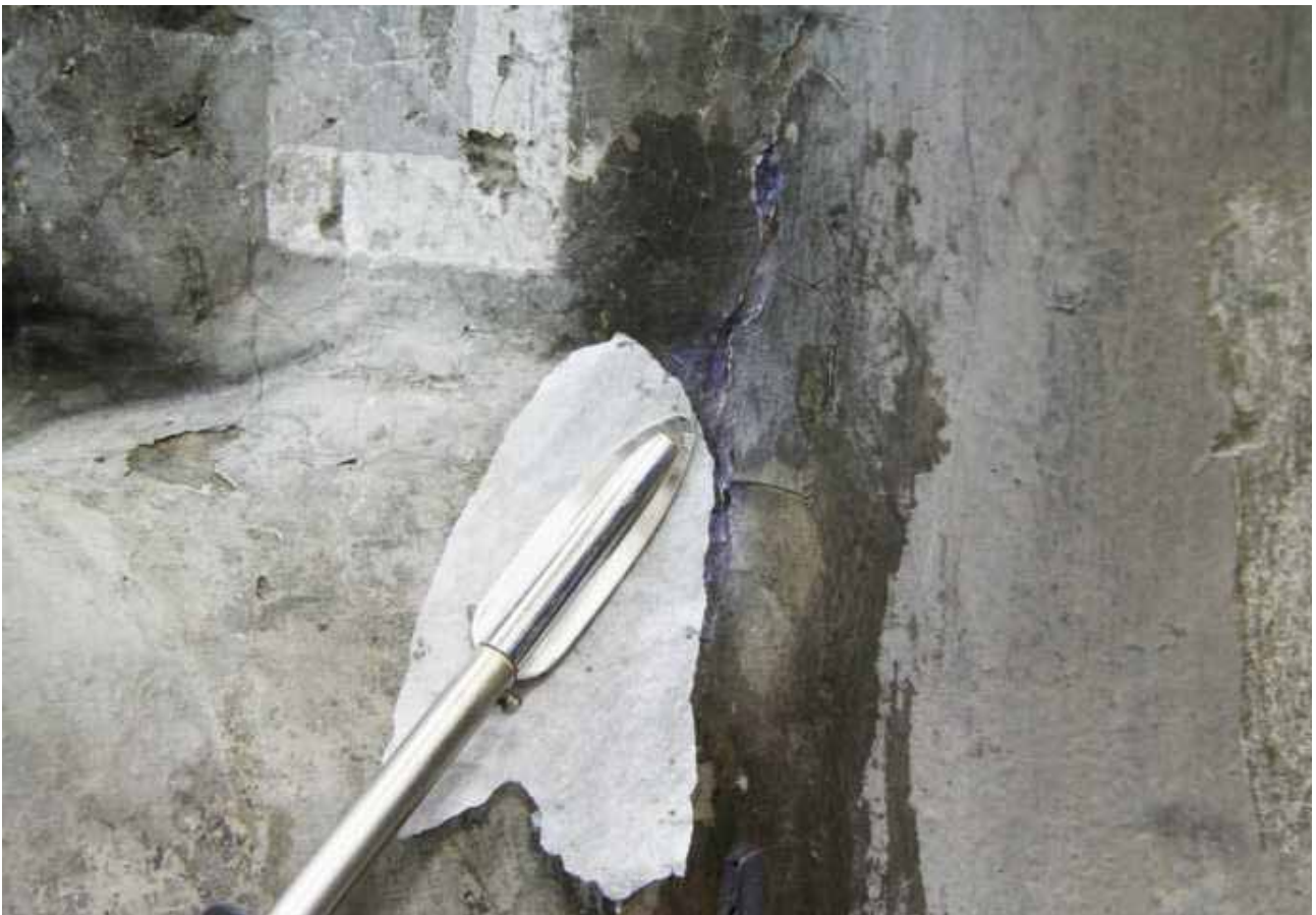
27. Postup fixáže barevné vrstvy, zažehlení pomocí tepelné špachtle
