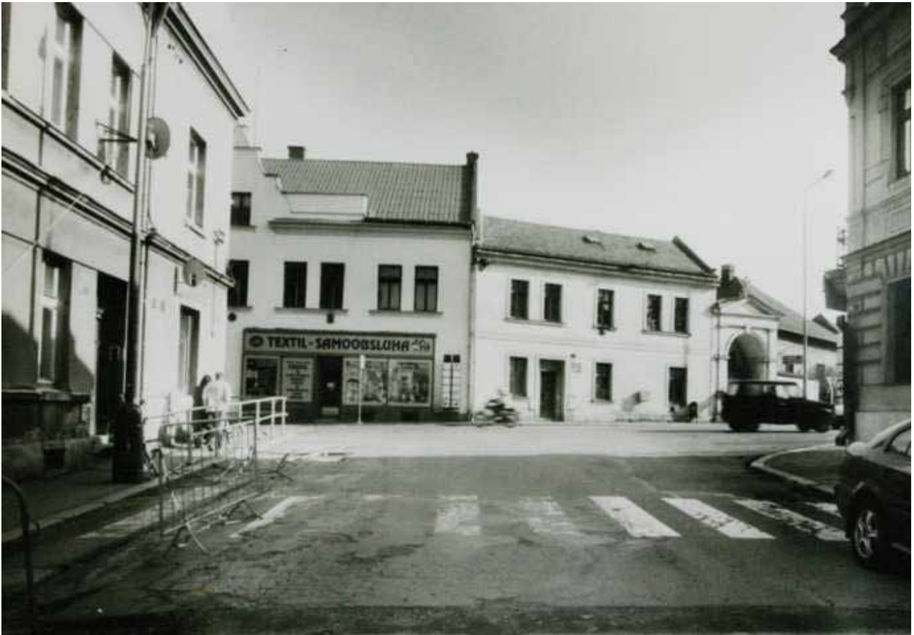
9. Pohled z Lorecké ulice, stav před demolicí domů, 7. 4. 2006 (foto J. Procházka, SOkA Kutná Hora)
