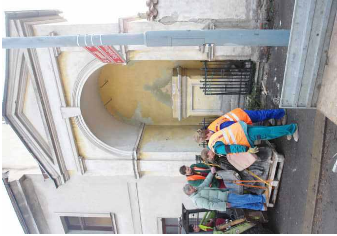
8. Průběh snímání sousoší z podstavce
