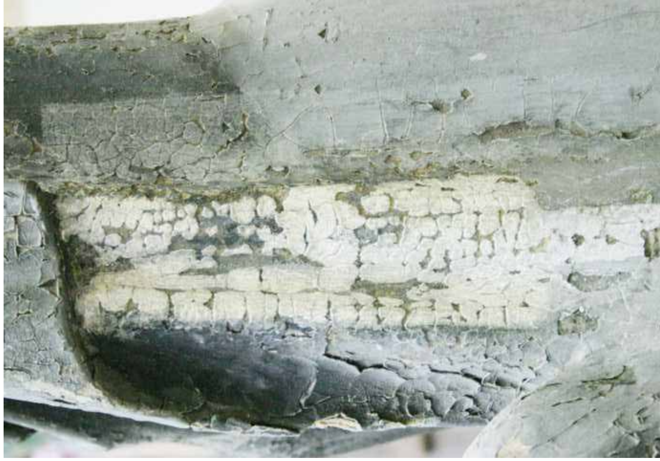
34. Zkouška odstranění mladších nátěrů
