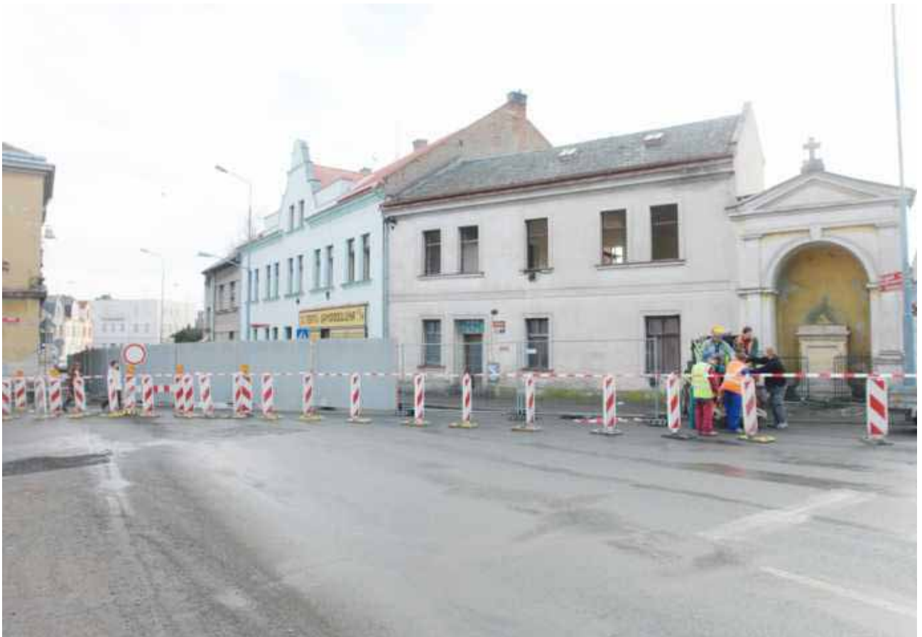
6. Křižovatka U Krupičků, stav před demolicí domu (2009), celkový pohled
