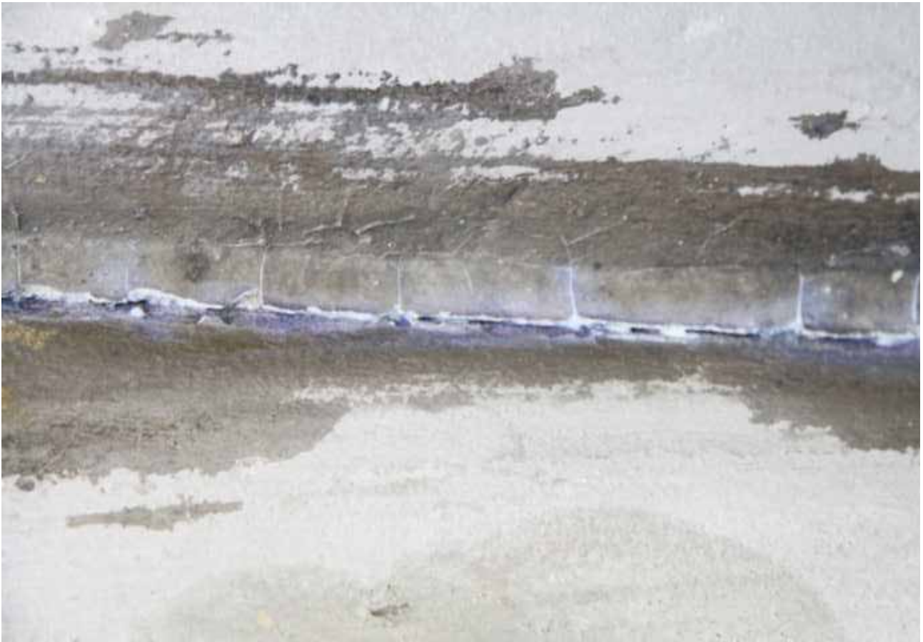
26. Postup fixáže barevné vrstvy, stav po injektáži fixážním materiálím
