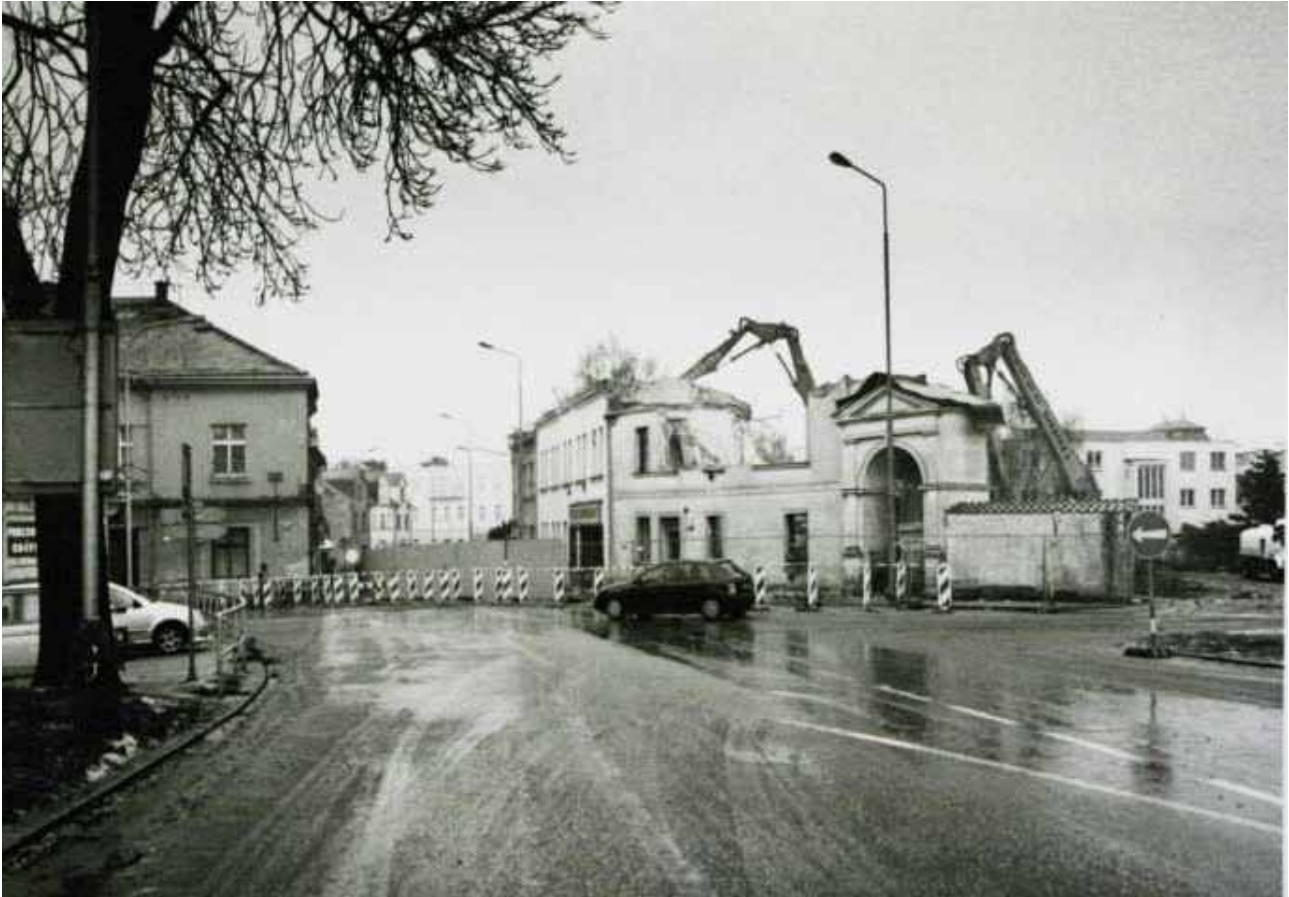
11. Demolice zástavby sousedící s kaplí (domy č.p. 292 a 433), únor 2009 (foto J. Procházka, SOkA Kutná Hora)
