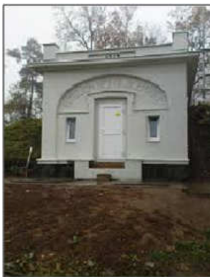
Obrázek 5 Zemní vodojem v Jilemnici
