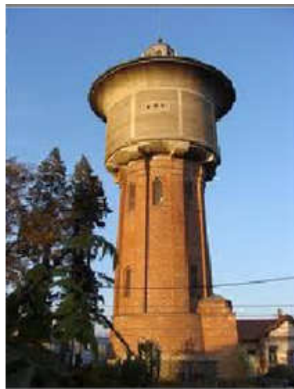
Obrázek 4 Věžový vodojem v Třeboni
