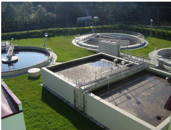
Obrázek 7 ČOV po rekonstrukci v Bystřici nad Pernštejnem
