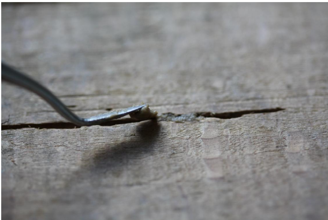
obr. 48) Tmelení otvorů v dřevěné desce
