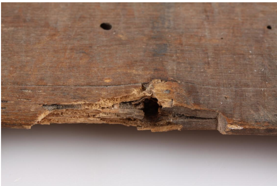
obr. 35) Horní otvor pro uchycení trnu – stav před restaurováním
