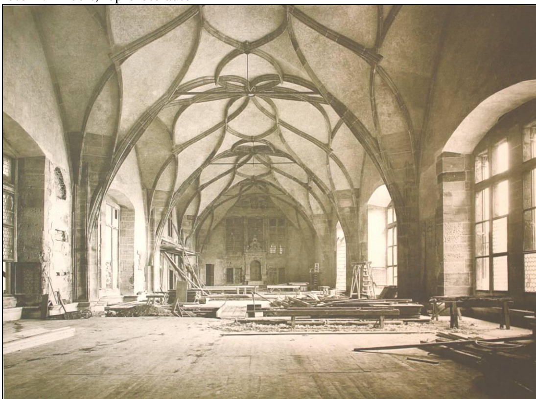
Obr. 30. Vladislavský sál, pohled do sálu směrem k východní stěně před dokončením rekonstrukce, foto J. Štenc 1929, reprofoto autor
