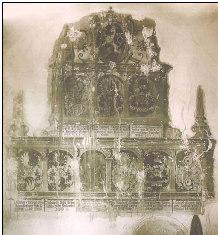
Obr. 21. Sál desek zemských po zajištění a poškození maleb cementovým mlékem V. Kalibou roku 1925, celek, foto J. Štenc 1925, reprofoto autor
