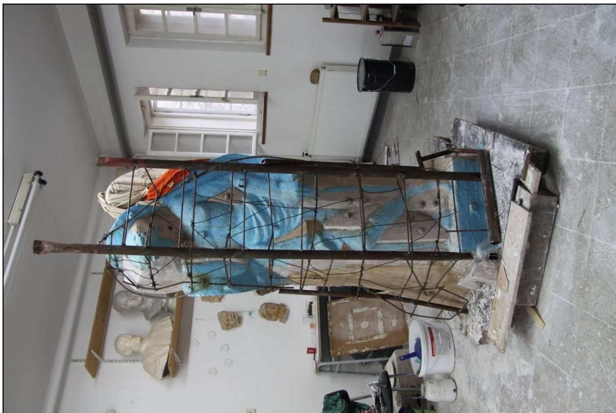
Obr. 33. Přední část formy s vrstvou silikonu, sádrovými klíny a svařovanou konstrukcí před a nahozením kadlubu.
