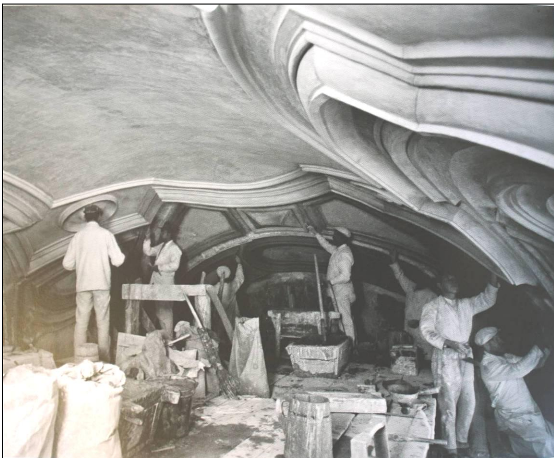
Obr. 52. Černínský palác, rekonstrukce štukové výzdoby, foto autor neznámý, reprofoto autor
