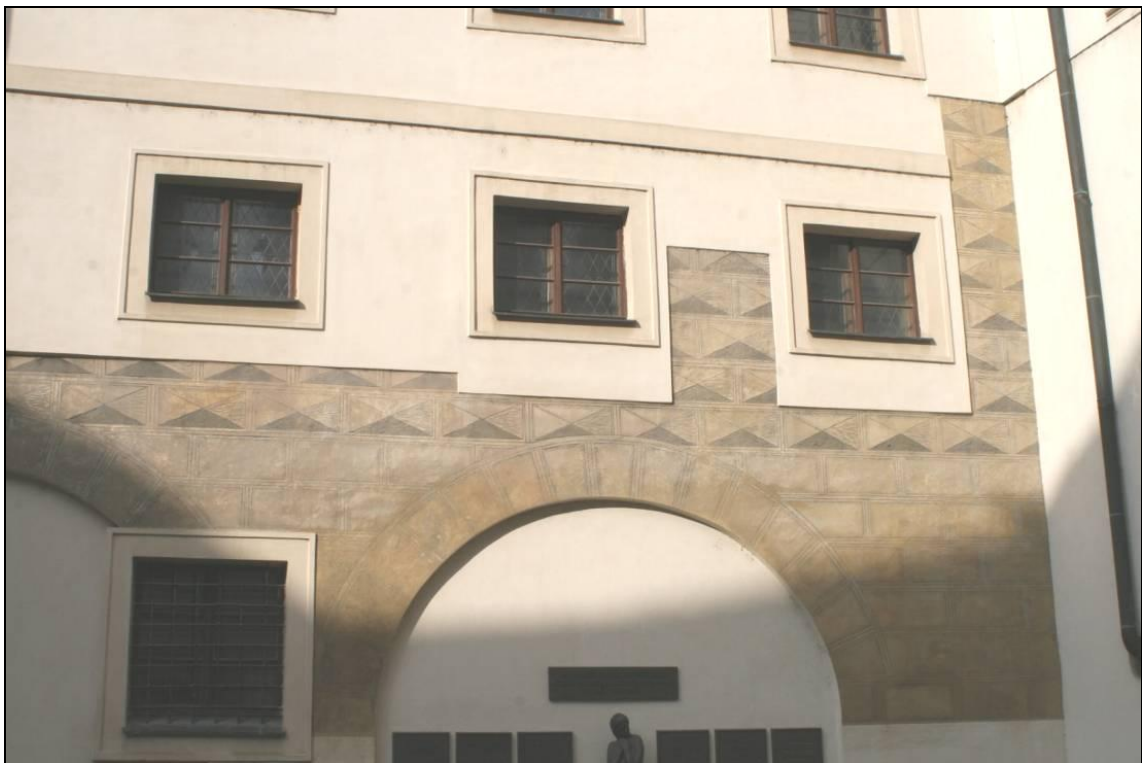
Obr. 44. Tyršův dům, analytická sonda sgrafitové výzdoby fasády na druhém nádvoří paláce, foto autor 2012
