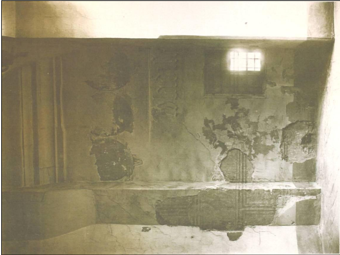
Obr.27. Starý palác, zemské desky částečně odkryté kartuše se znaky, nápis a sgrafitová kvádrová rustika fasády Vladislavského sálu, foto, Jan Štenc před 1924, reprofoto autor
