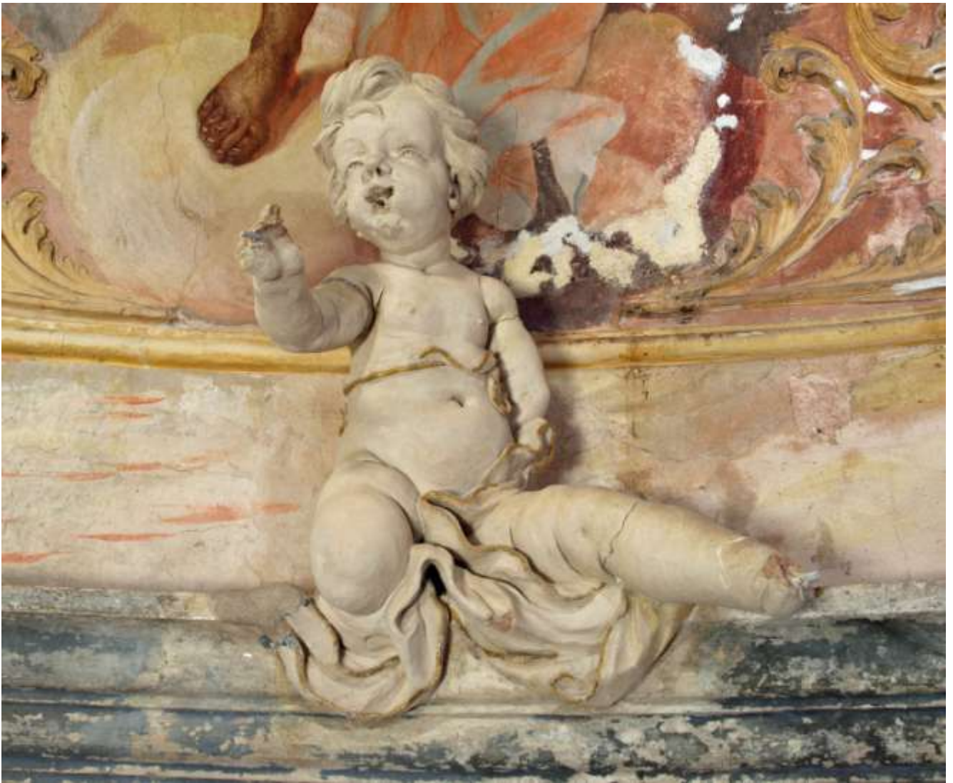
Obr.62. Plastika anděla K 1.41., přední strana - pohled. Stav po injektáži a očištění. (* Draperie vlevo: doplnění chybějící části v jádrovém štuku.)
