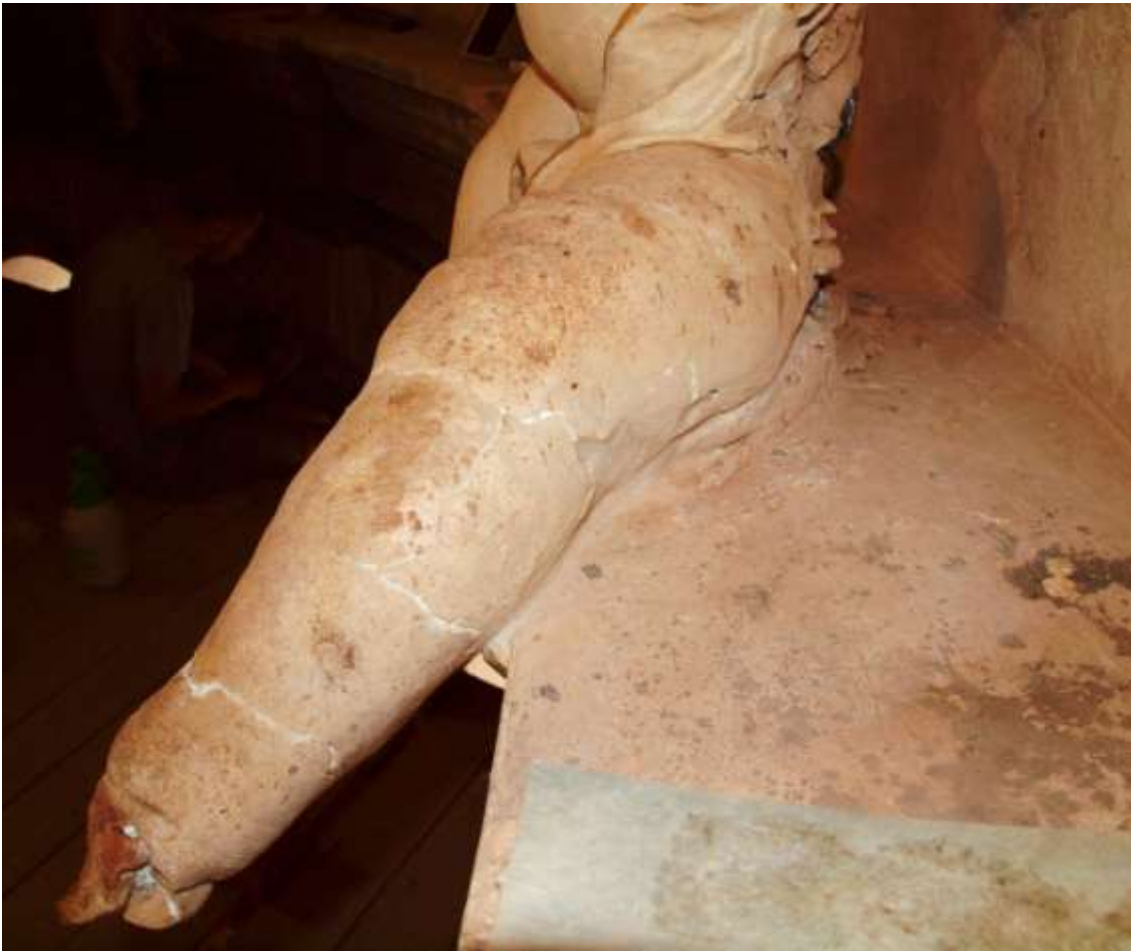
Obr.57. Levá noha, zadní strana, po injektáži - stav před dočištěním stékanců konsolidantu. Průběh prací.
