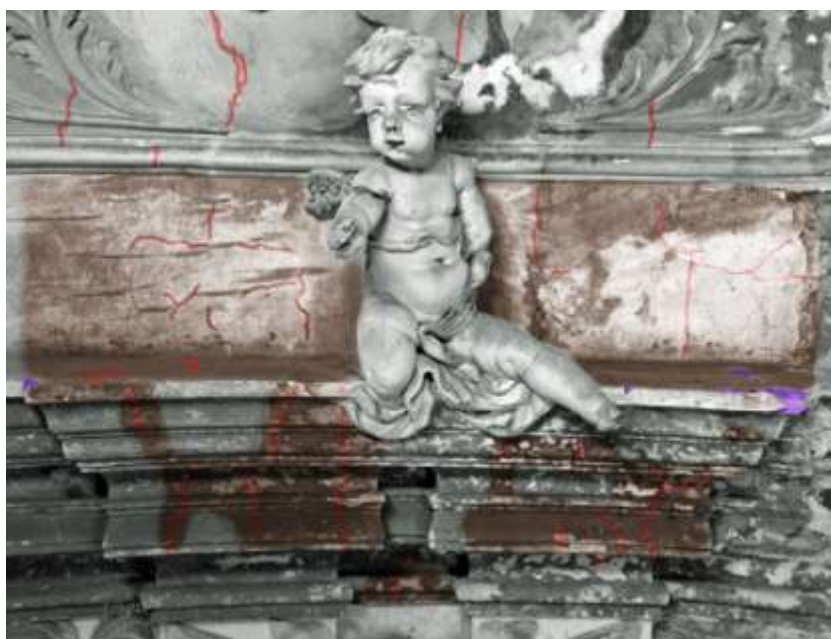
Graf.3. Zákresy poškození, zdivo a korunní římsa v okolí plastiky anděla.
