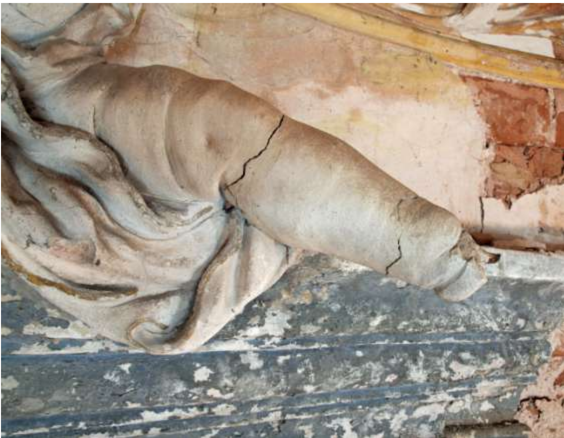
Obr.50. Levá noha, přední strana - trhliny skrz celou štukovou hmotu. Stav před restaurováním.
