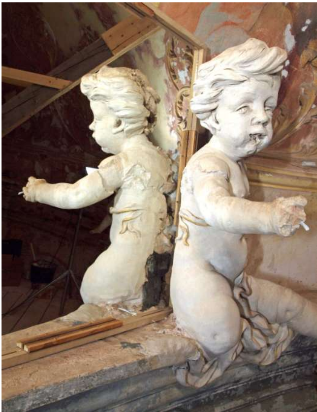
Obr.65. Plastika anděla K 1.41., pravá strana + odraz zadní strany v zrcadle. Stav po injektáži a očištění. (* Draperie vlevo: doplnění chybějící části v jádrovém štuku.)
