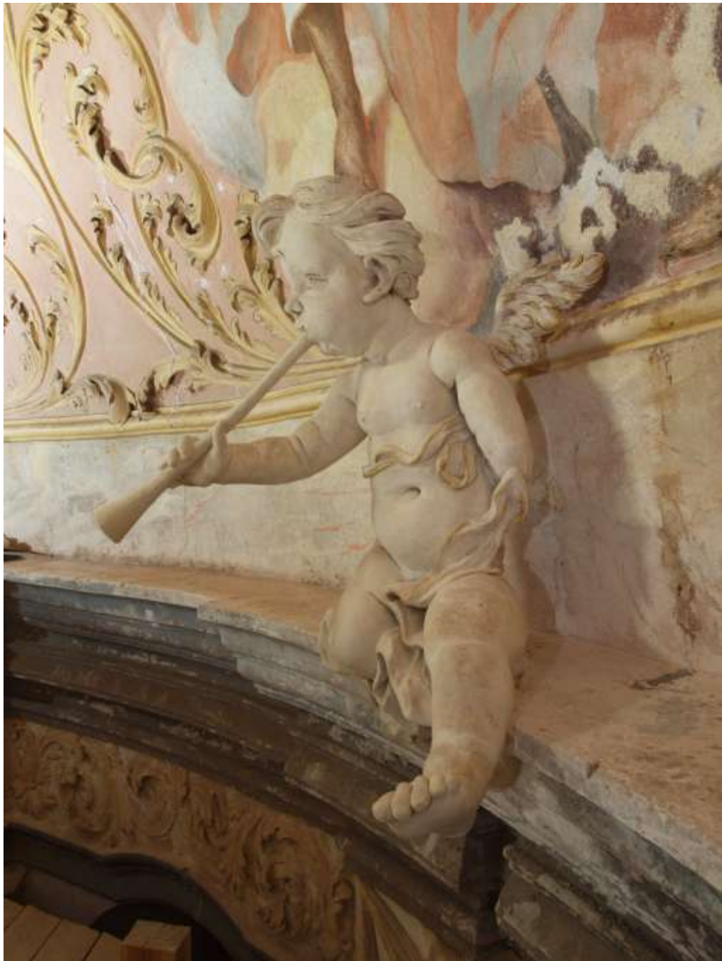
Obr.83. Plastika anděla K 1.41., Stav po vytmelení a plastických rekonstrukcích - levá strana.
