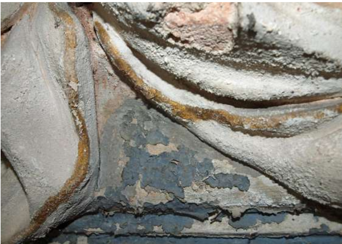
Obr.39. Plastika anděla K 1.41., detail okolí poškozené draperie u levé nohy, čelní pohled. Poškození: detail krakelování a odlupování se pozlacených partií, sprášující povrch. Stav před restaurováním.
