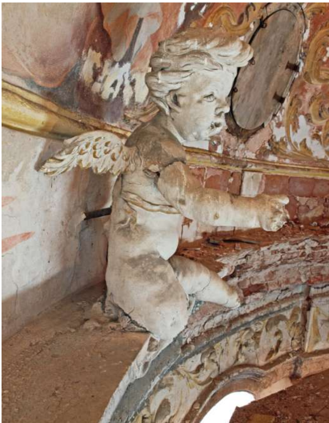
Obr.6. Plastika anděla K 1.41., pravá strana. Stav před restaurováním.
