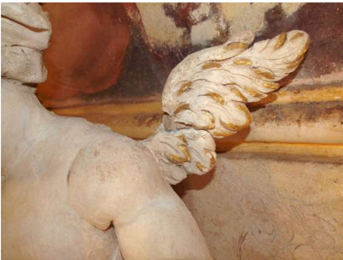
Obr.68. Plastika anděla K 1.41., lepení levého křídla. Průběh prací.
