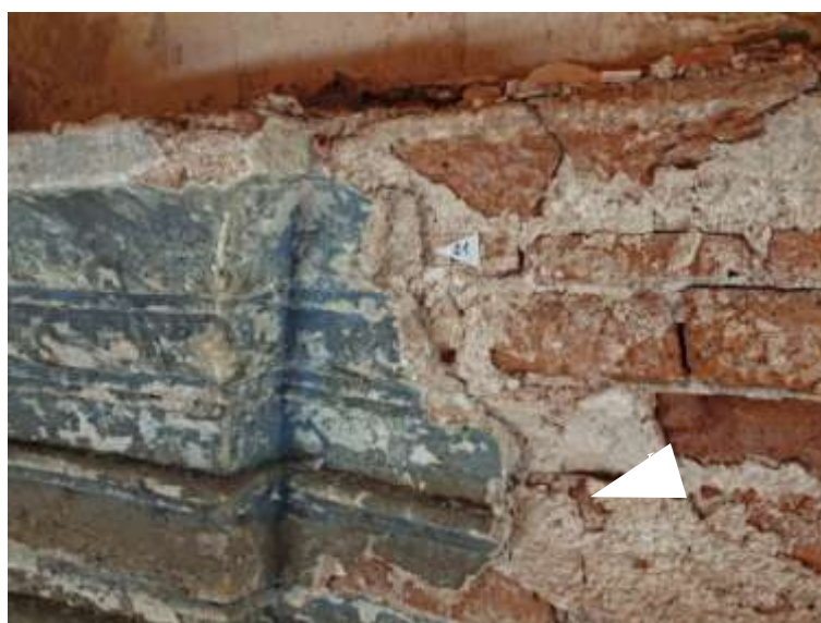
9b - Korunní římsa u anděla (K 1.41.), detail místa odběru vzorků.
