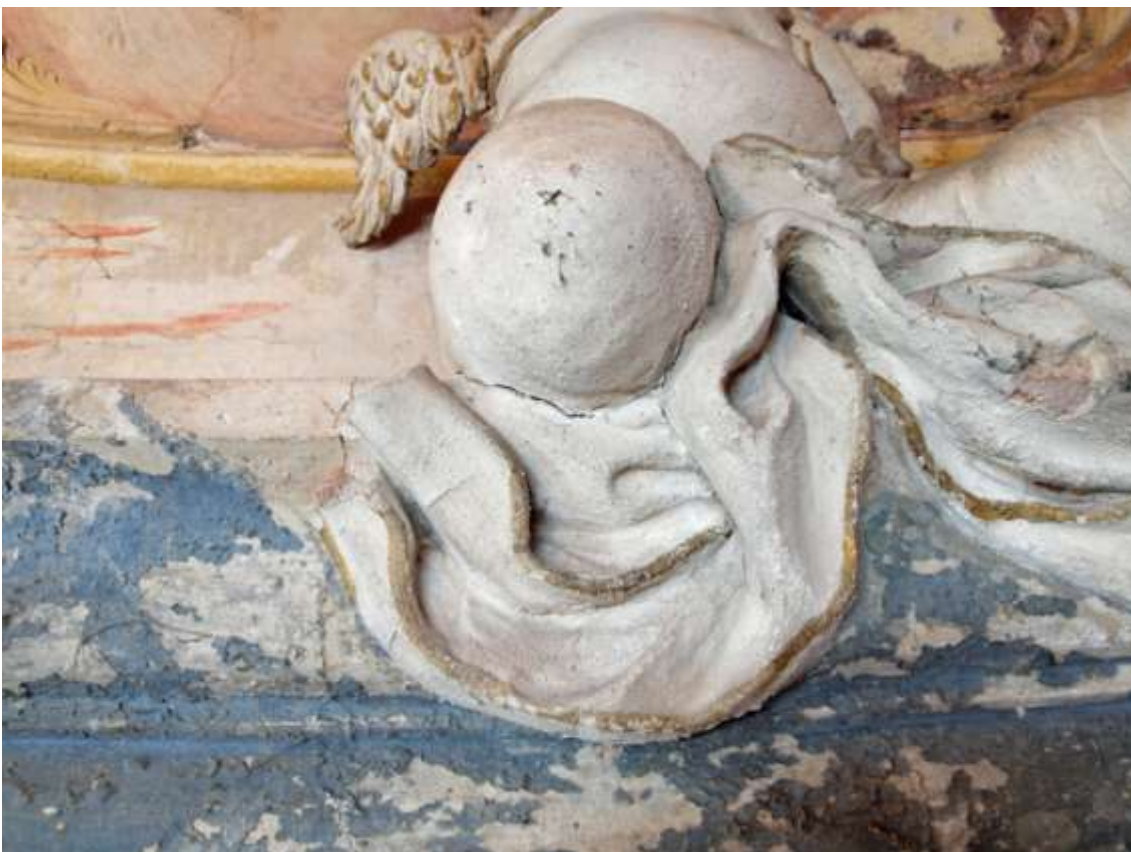
Obr.37. Plastika anděla K 1.41., pravého koleno s draperií. Poškození: „spára“ (oddělená hmota) mezi kolenem a draperií, trhliny, srašující povrch, chybějící části draperie. Stav před restaurováním.
