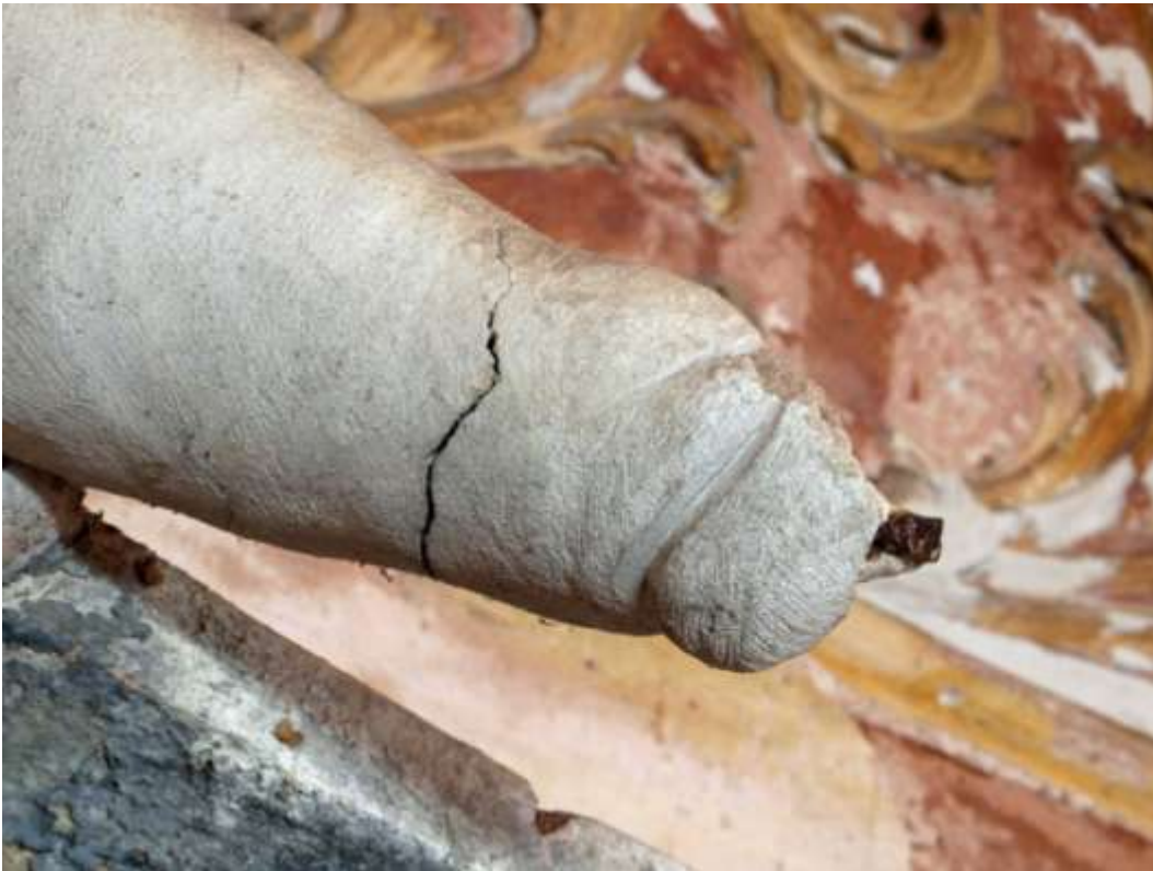
Obr.42. Plastika anděla K 1.41., detail poškozeného chodidla levé nohy - boční pohled zprava. Stav před restaurováním.
