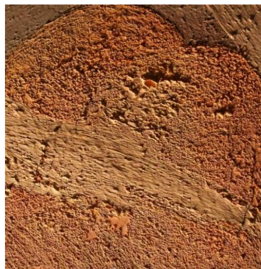
Obrázek č. 26: Ztráta adheze barevné vrstvy na inkarnátu andílka.
