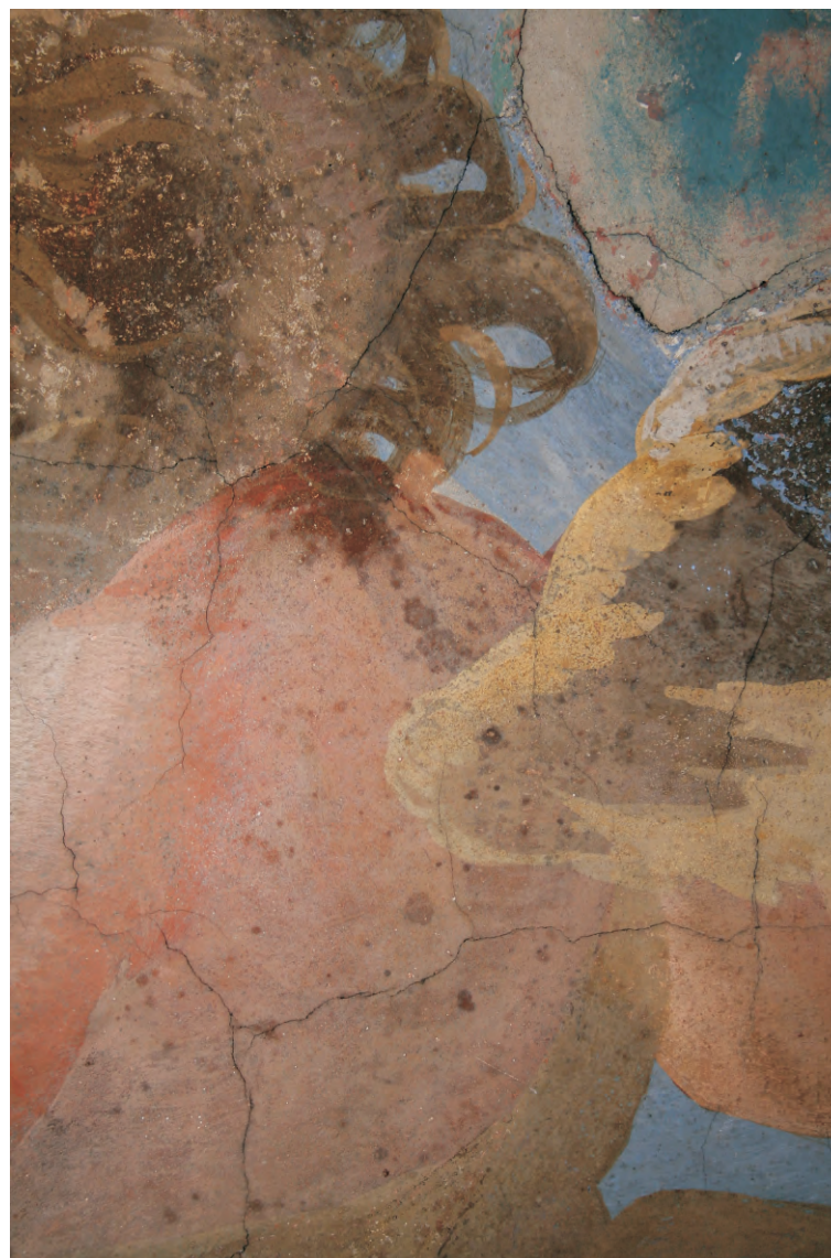
Obr. 45 Biologické napadení vyskytující se v podobě tmavých skvrn na postavě andělka (výsledky mikrobiologických zkoušek viz. Příklad 10.4. Technologické analýzy, lokalizace viz. Příklad 10.2. Grafická dokumentace).
