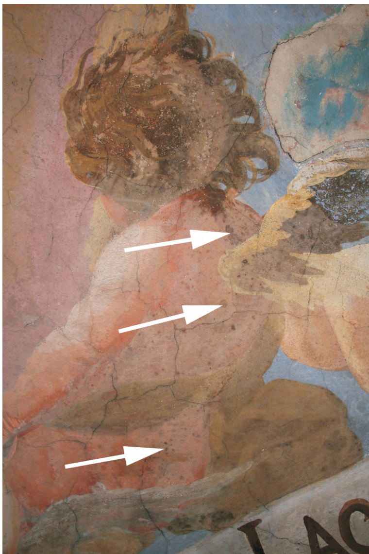
Obr. 45 Biologické napadení vyskytující se v podobě tmavých skvrn na postavě andělka (výsledky mikrobiologických zkoušek viz. Příklad 10.4. Technologické analýzy, lokalizace viz. Příklad 10.2. Grafická dokumentace).
