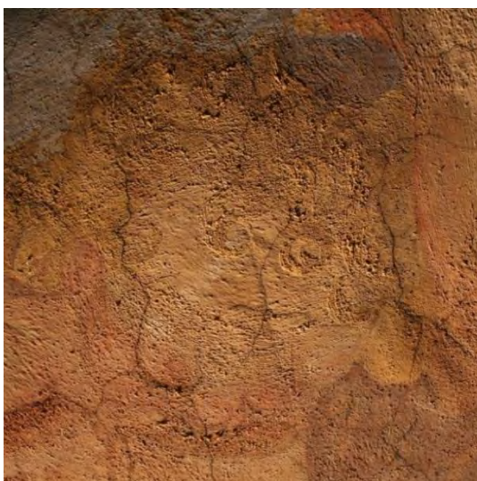
Obrázek č. 25: Ztráta adheze barevné vrstvy na hlavě andílka.
