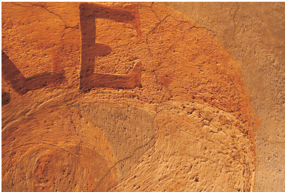
Obr. 41 Zpráškovatí lá barevná vrstva na částech provedených okrem v razantním boěním nasvícení - stav pøed restaurováním.
