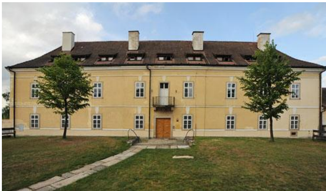
Obr. č. 19: Budova kláštera
