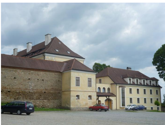
Obr. č. 22: Pohled na novou přístavbu
