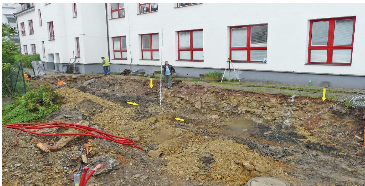
Obr. 16: Pohled na narušené zdivo věže druhého hradebního pásma s přílehlou částí severní kurtiny. Zdiva jsou zvýrazněna žlutými šipkami. Pohled od východu. Foto Jan Musil.
