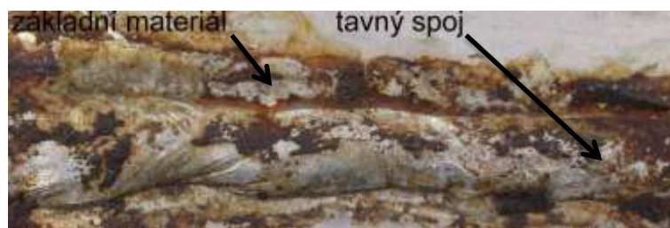
Obr. 21 – Makrosnímek koroze svaru technologií CMT
