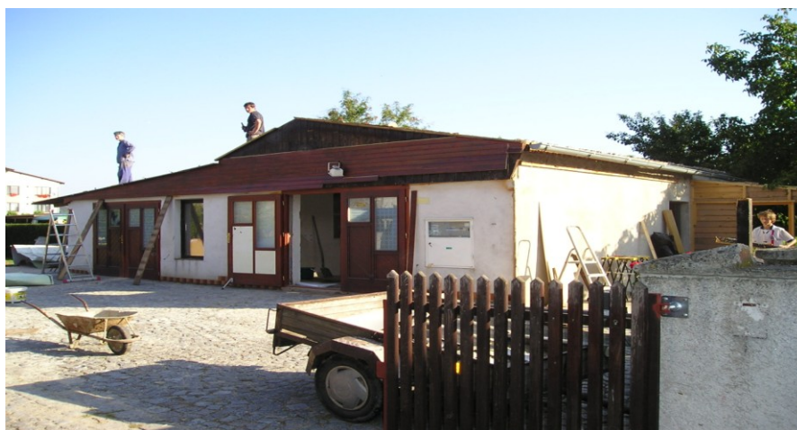
Obrázek 11: Původní budova při rekonstrukci
