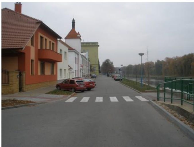
Obrázek 12 – Přechod pro chodce od rekonstruované lávky
