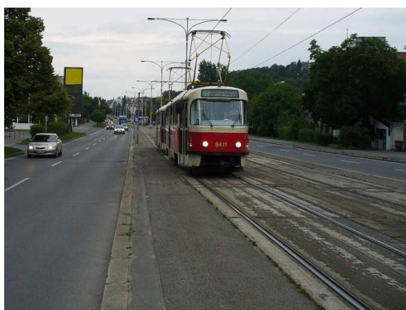
Obrázek č. 7: Vyvýšený tramvajový pás uprostřed komunikace
