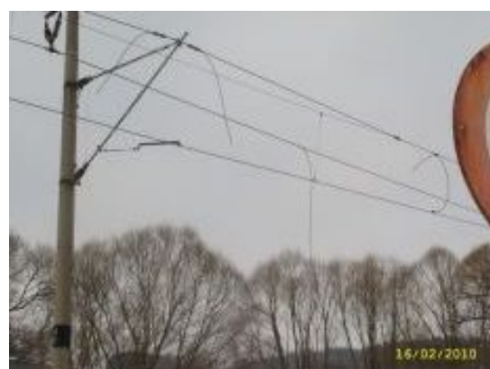
Obr. 2.7, 2.8 – Zbytky lan pevného bodu z případu zasahující do průjezdného profilu (Zdroj Policie ČR)
