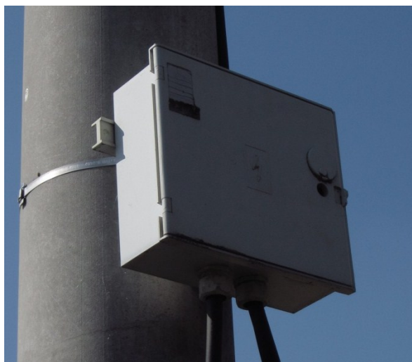
Obr. 4.16 - Pojistková skříň ČEZ
