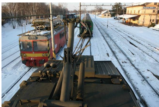
Obr. 2.11 - Poškozený sběrač lokomotivy řady 163 (Zdroj Policie ČR)
