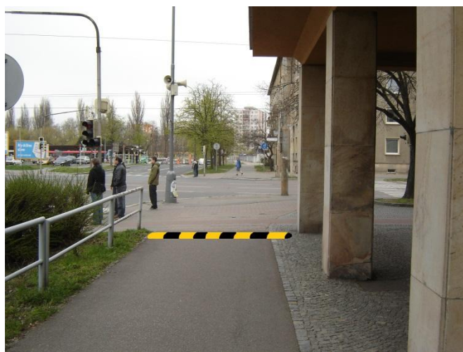
Obr. 21 – Problémové místo s umístěním zpomalovacího prahu
