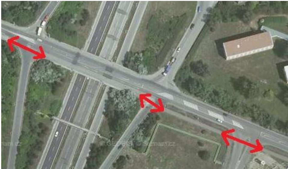
Nadjezd u silnice I/37
