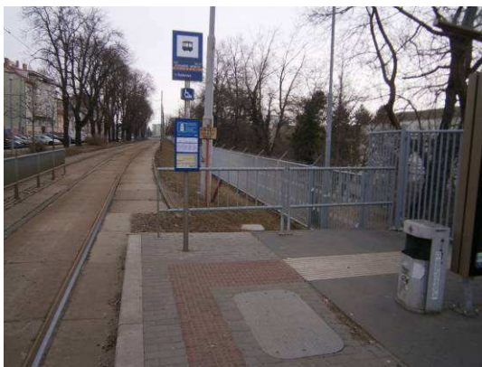
Obrázek 11: Chybné umístění signálního a varovného pásu
