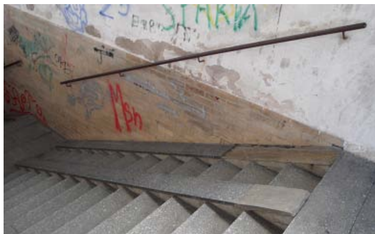
Obrázek 37 - Přesahy madla na schodišti [19]
