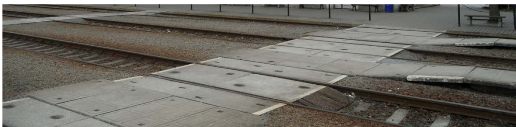
Obrázek 62 - Úroňový přechod kolejí ve stanicí [19]
