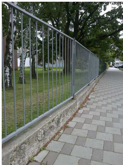
Obrázek 8 - Umělá vodící linie pomocí reliéfní dlažby a přirozená vodící linie [19]
