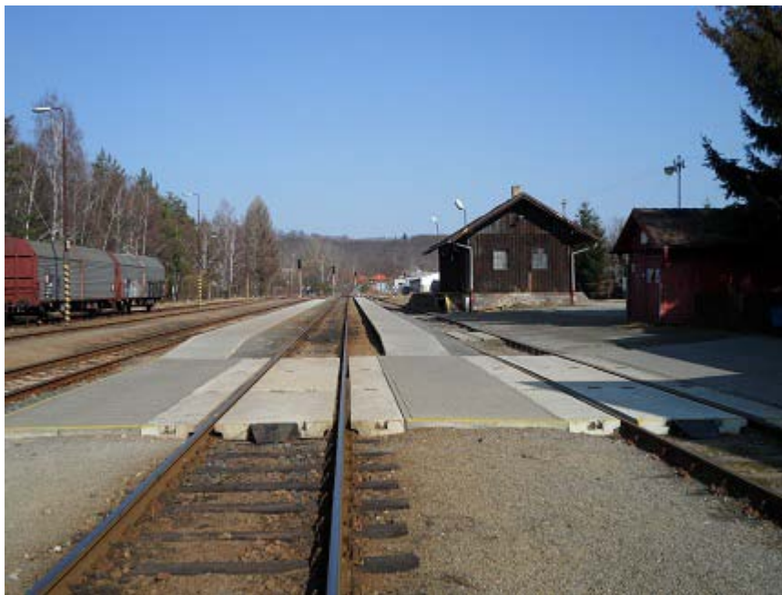
Obrázek 39 - Pohled na nástupiště ve stanici [19]
