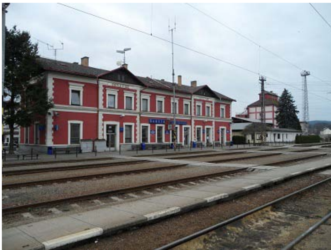
Obrázek 45 - Výpravní budova železniční stanice Světlá nad Sázavou [19]
