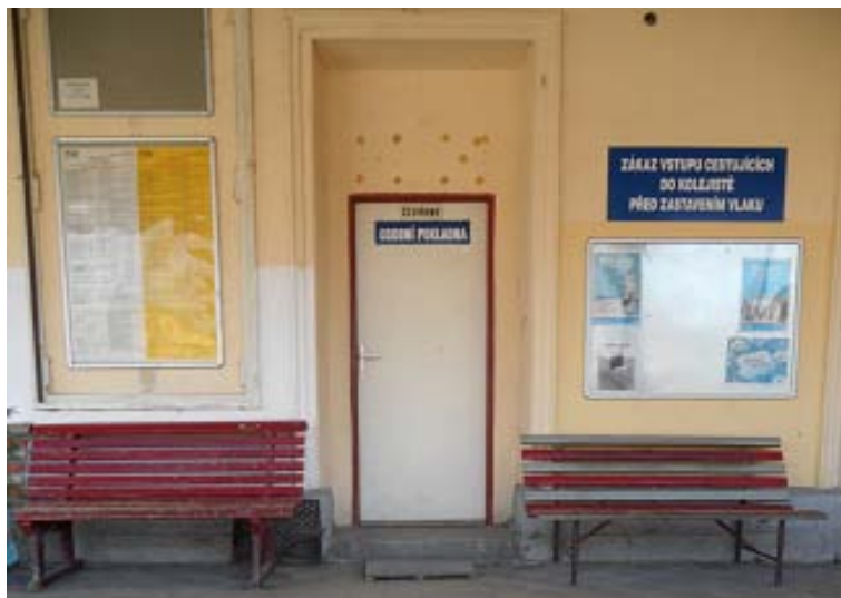
Obrázek 28 - Pohled na vstupní dveře [19]
