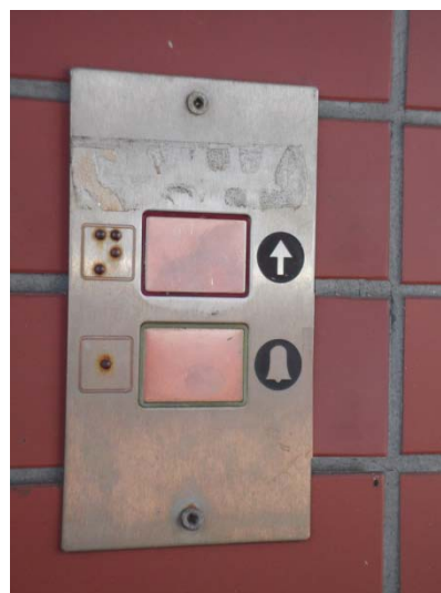
Obrázek 19 - Umístění kabiny výtahu a detail ovládacích prvků pro přivolání [19]
