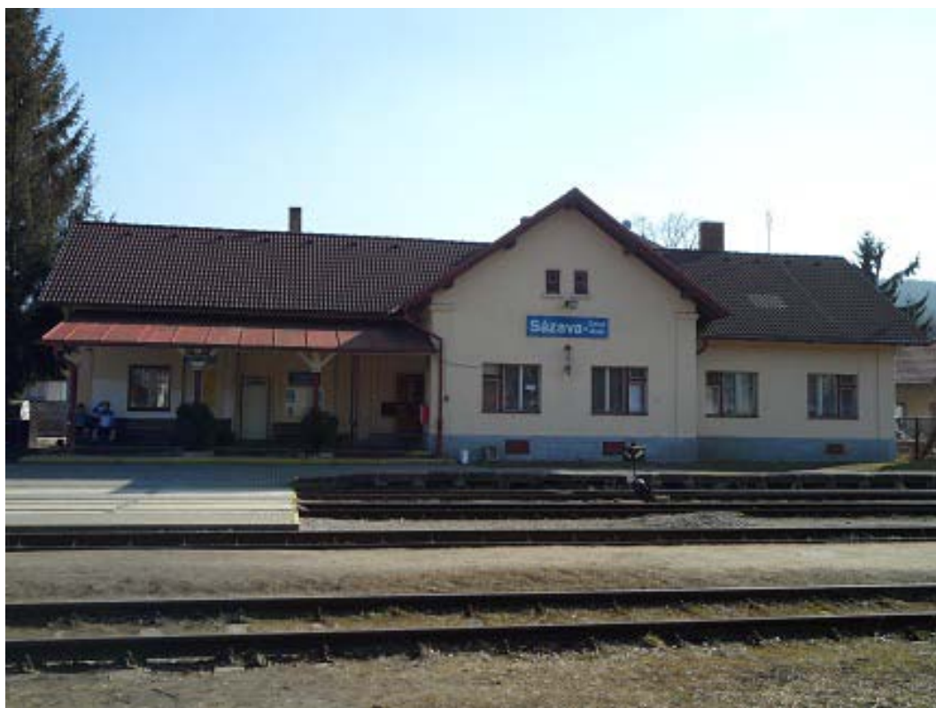
Obrázek 24 - Výpravní budova železniční stanice Sázava - Černé Budy [19]
