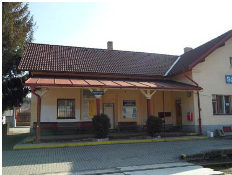
Obrázek 26 - Pohled na vstup do výpravní budovy z prostoru nástupiště [19]
