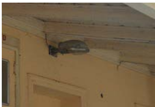
Obrázek 32 - Osvětlení nad vchodem do výpravní budovy [19]
