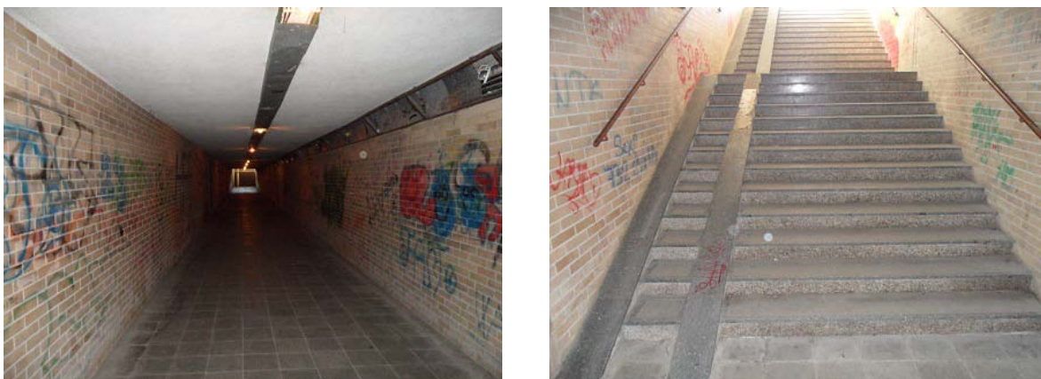
Obrázek 35 - Prostor podchodu a vstup do podchodu [19]
