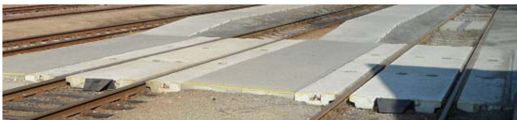
Obrázek 40 - Úrovňový přechod kolejí ve stanicích [19]
