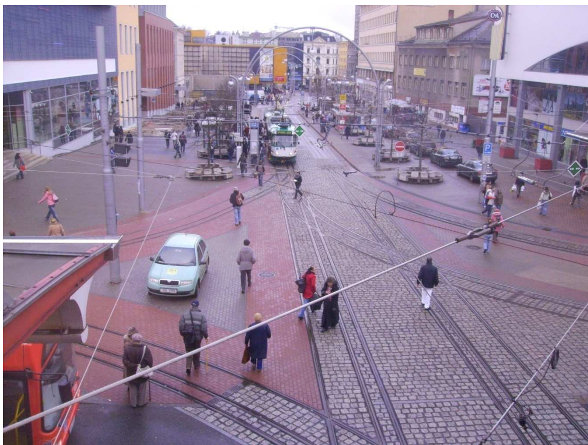
Obrázek 5: Tramvajová křižovatka po rekonstrukci v roce 2008 Zdroj: autor
