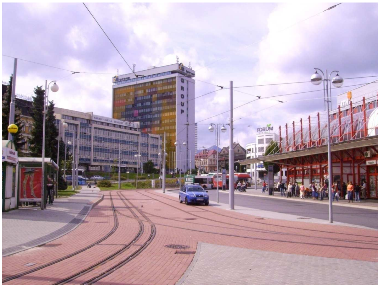
Obrázek 6: Výjezd ze smyčky terminálu MHD po rekonstrukci Zdroj: autor
