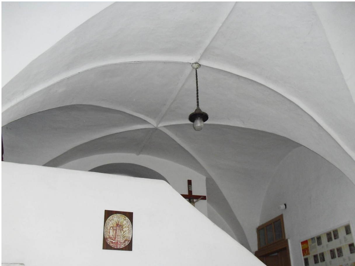
Klenba ve fáře, dům č. p. 63 323
