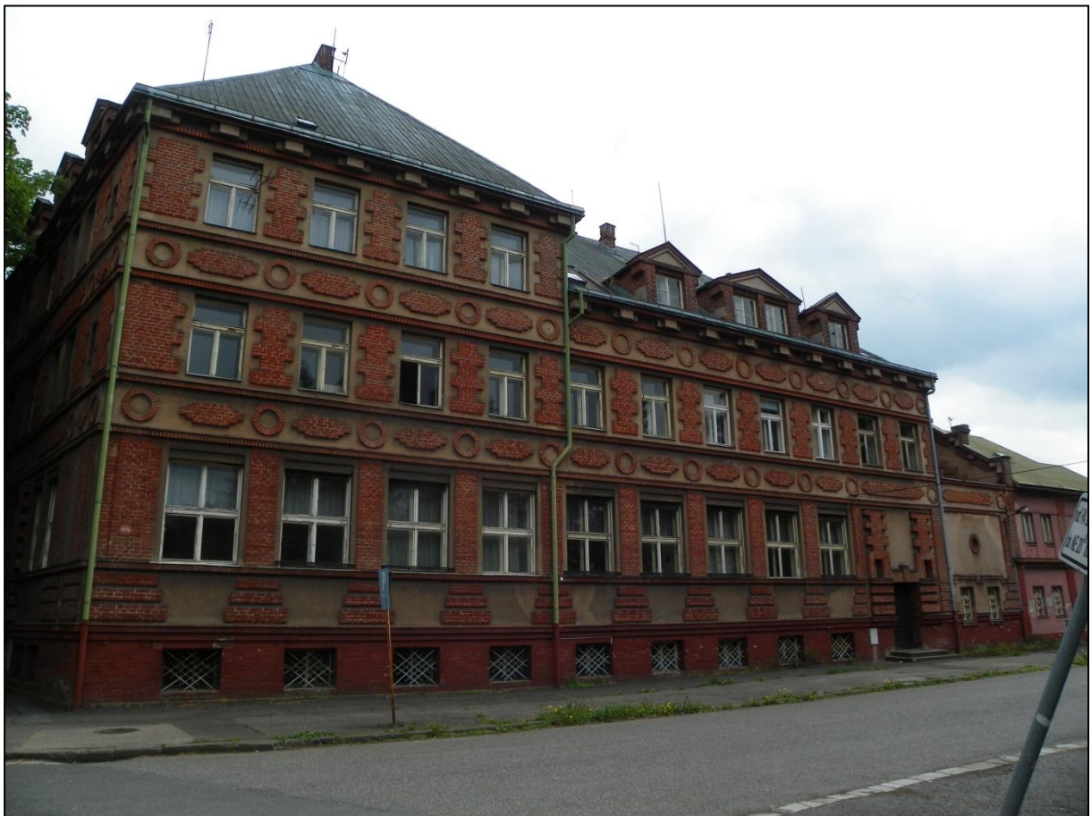
Obr. 30 - Administrativní budova projektována Pavlem Janákem – foto z roku 2011.
