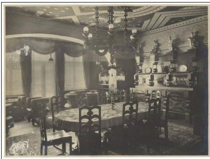
Obr. č. 18 – Původní interiér vily J. Sochora (na zadní stěně se nachází příborník od Josefa Gočára zdobený čtyřmi plastikami od Otto Gutfreunda – Trhač bavlny , Sukařka , Tiskař a Muž u selfaktoru ).
