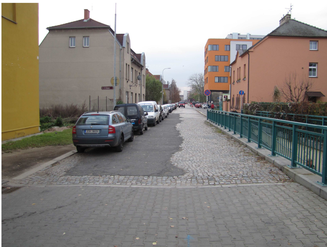
Fotografie 27 – pohled od začátku upravovaného úseku do ulice Rokycanova
