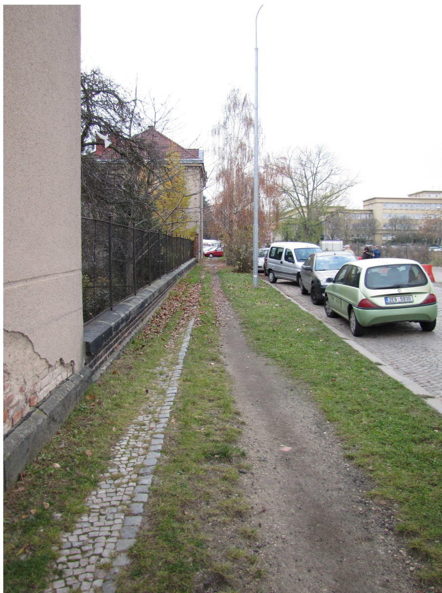
Fotografie 11 – stávající okapový chodník
