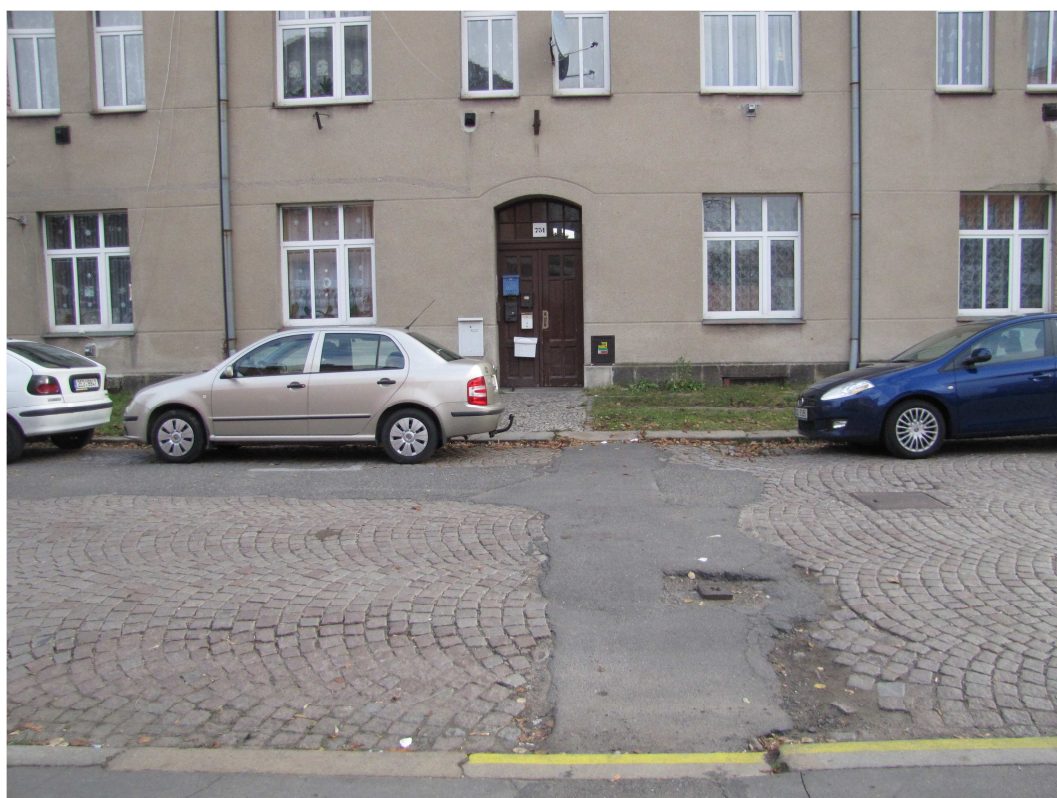
Fotografie 22 – vchod do objektu č.p. 751
